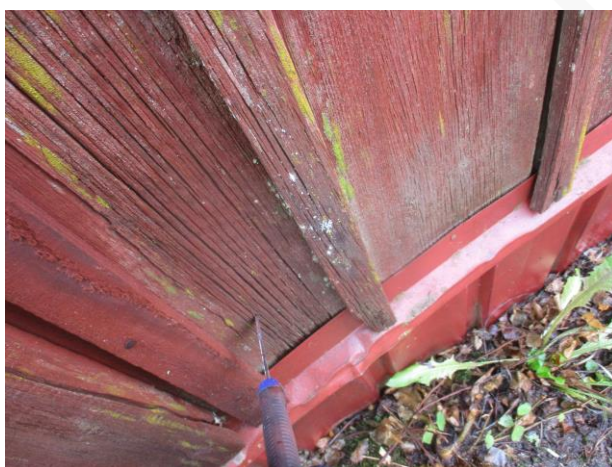
Kuva 2c. Haristumaa ja pehmentymää.
