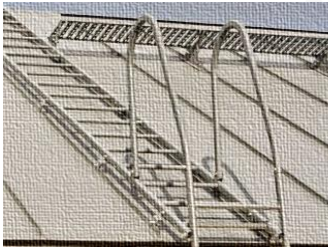
Talotikkaiden ankkurointi rakenteeseen.
