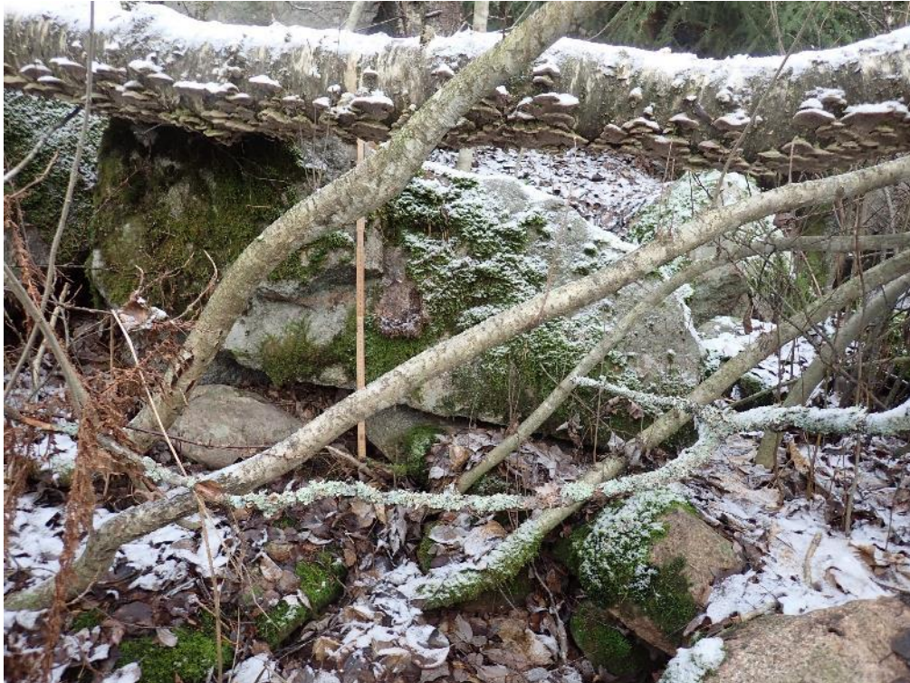
Kuva 5. Sahan luonnonkivistä ladottua perustusta.
