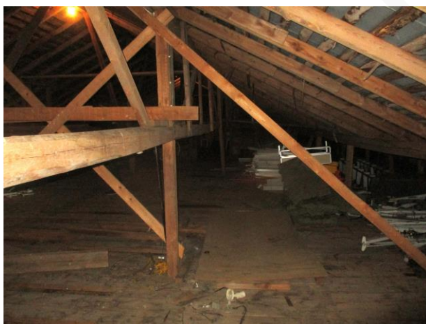
Kuva 4g. Yleiskuvaa yläpohjasta.
