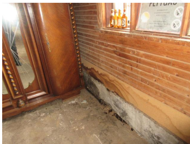
Kuva 1i. Rungon alaosat ovat paikoin hyvin märkiä
