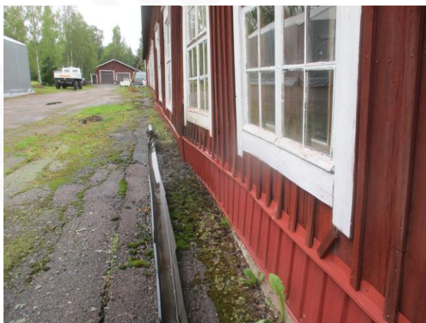
Kuva 1a. Rakennuksen vierustaa. Asfaltti on halkeillut, ehkä routimisen vuoksi. Kattovedet ohjautuvat sokkelin vierustalle. Muodon muutokset runkorakenteissa havaittavissa.
