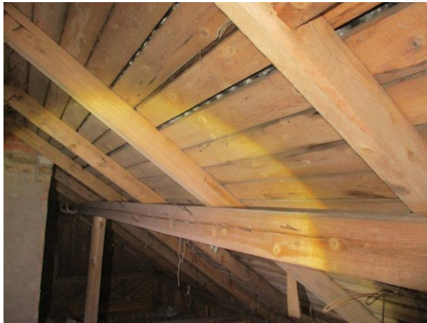
Kuva 4h. Laperakennetta. Aluskatetta ei ole asennettu.
