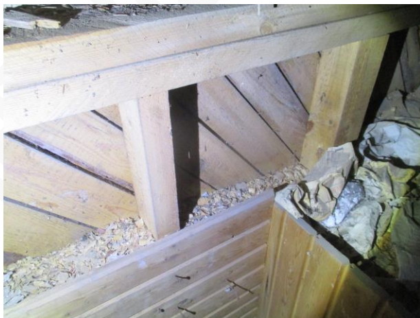
Kuva 4f. Puruntäyttöaukkoja ullakkoportaikon kohdalla.
