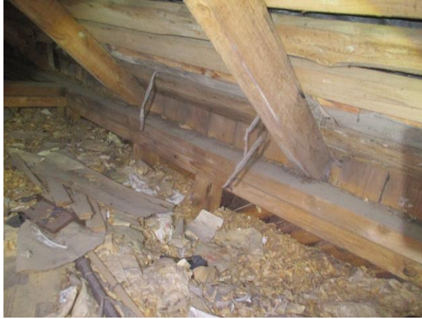
Kuva 4g. Räystäällä on rakennusajalle tavanomaisesti niukat tuuletusraot.
