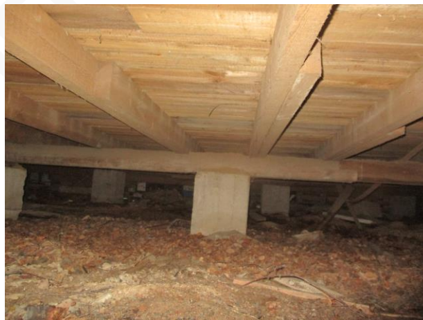
Kuva 1b. Alapohjaa. Tummentumaa tai lahoea ei havaittu, joskin alapohjasta saatiin vain osittainen havainto..
