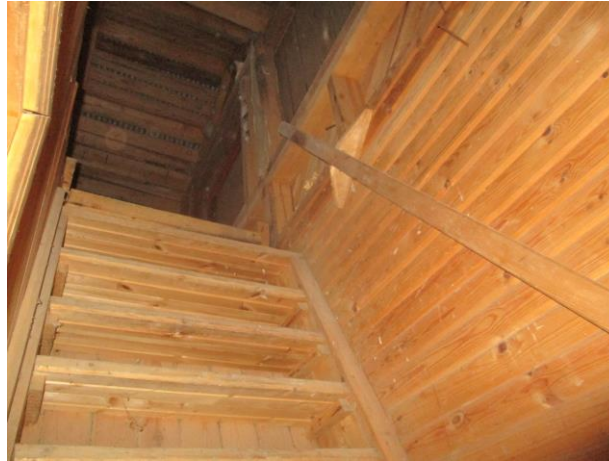
Kuva 6e. Ullakkoportaikko. Käsijohde on asennettu.
