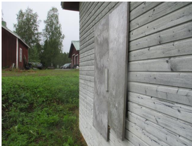
Kuva 3b. Yksittäinen ikkuna on poistettu.
