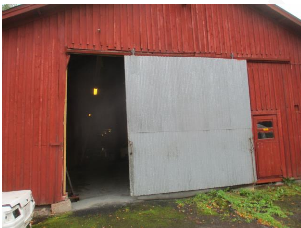
Kuva 3d. Päädyn liukuovi.
