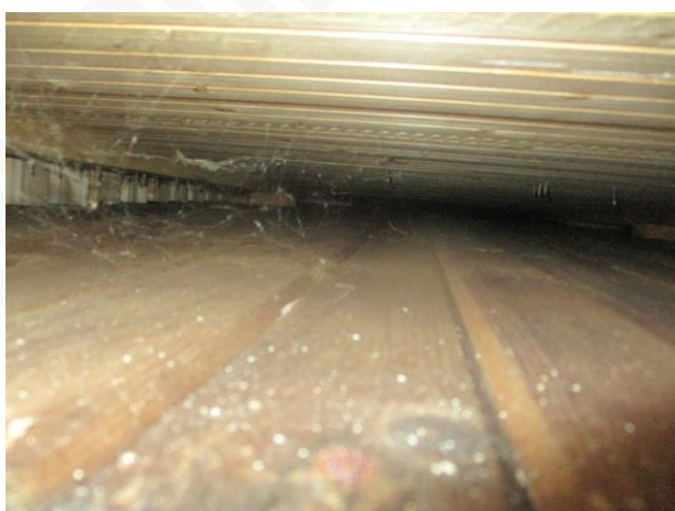
Kuva 5.2d. Panelin takainen ilmarako on riittävä.
