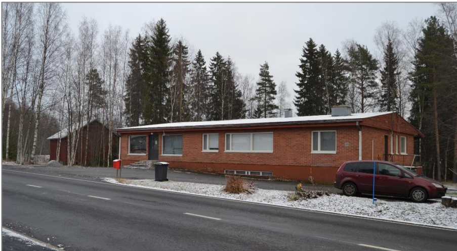
Kuva 30. Rakennuksen pääjulkisivu ja eteläpääty kuvattuna Käenmäentieltä.
