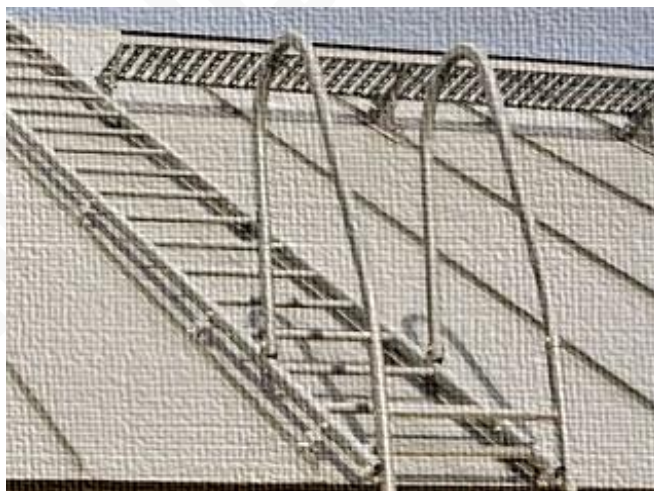
Talotikkaiden ankkurointi rakenteeseen.
