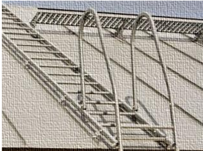
Talotikkaiden ankkurointi rakenteeseen.
