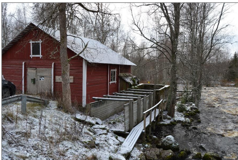
Kuva 7. Kairokosken mylly sijaitsee välittömästi selvitysalueen rajalla, kosken etelärannalla. Vuodelta 1929 oleva mylly on hirsirunkoinen, hakanurkkainen, pieni rakennus, jonka perustuksena on betonimuuri. Myllyn yhteydessä aiemmin sijainnut rankorakenteinen sirkkelikatos on purettu. Sahaus ja myllytoiminta Kairokosken myllyllä päättyivät 1980-luvulla.
