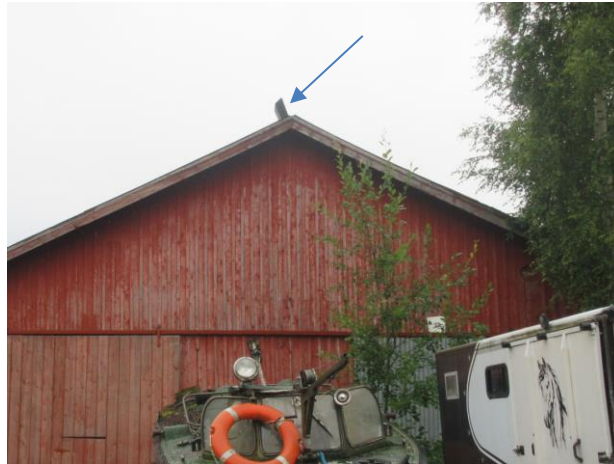
Kuva 4g. Harjapelti on kiinnitettävä.
