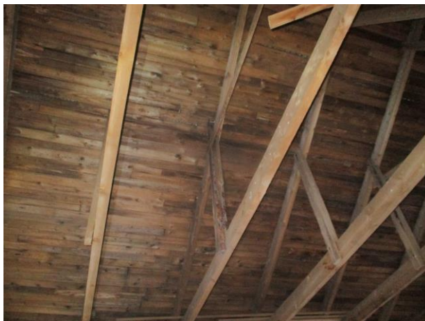
Kuva 4d. Yläpohjarakenteita ja aluslaudoitusta.
