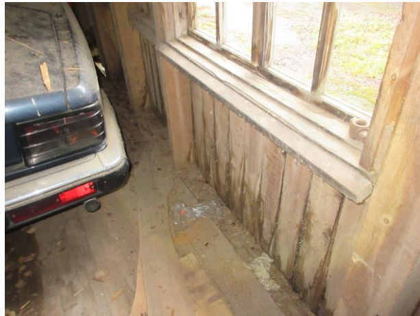
Kuva 2f. Kosteaa verhouslautaa sisäpuolella.
