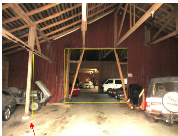
Kuva 1f. Rakennusta on jäykistetty. Viivastolla py- ritään havainnollistaman rakennuksen liikkumi- nen (kallistuma).
