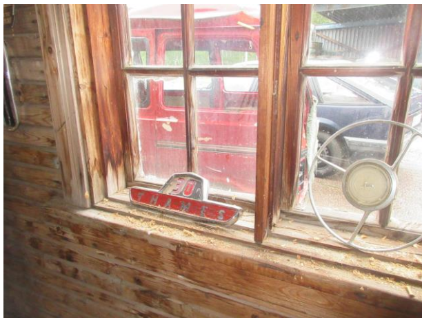
Kuva 3c. Kosteusjälkiä ikkunoissa.
