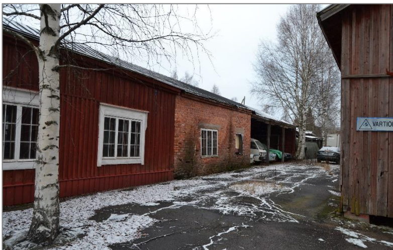
Kuva 17. Rakennuksen itäisivulla erottuu tiilirakenteinen osa.
