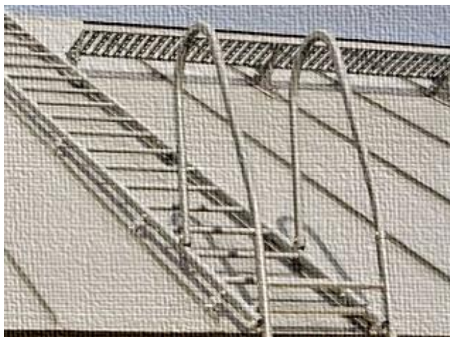
Talotikkaiden ankkurointi rakenteeseen.
