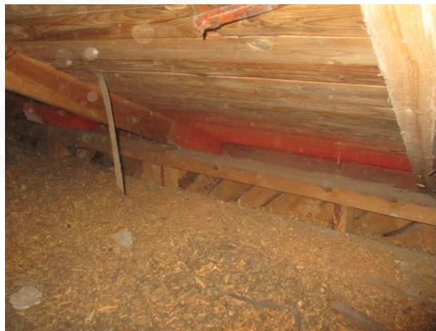
Kuva 4d. Tuuletus tapahtuu räystäsrakenteista.
