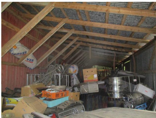
Kuva 4c. Yläpohjarakenteita (ko. tila on havainnon mukaan laajennus).
