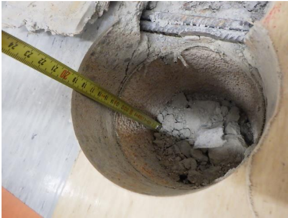
Kuva 25. Rakenneavaus RA-AP6. Vuonna 2014 peruskorjattu alapohjarakenne AP4.
