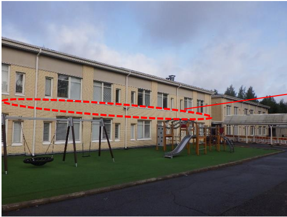
Kuva 100. Toisen kerroksen välipohjarakenteen kohdalla ulkoseinärakenteessa US2 on puurankarunkoinen ja sisäpinnastaan levyverhottu seinärakenne.
