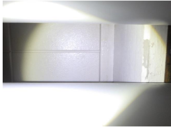
Kuva 169. Rakenneavauskohdassa RA-VP5 ensimmäisen kerroksen käytävän sisäkattopintana on muottilauδοituksen sisäpinnassa maalattu puukuitulevy (Haltex).
