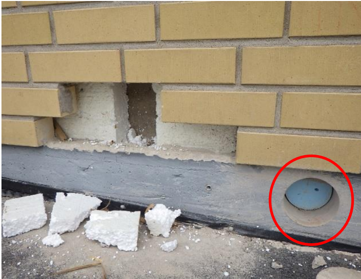
Kuva 133. Rakennesaavaus RA-US5. Sokkelihalkaisun lämmöneristeenä on XPS-levyä.
