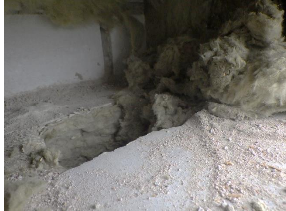
Kuva 92. Rakenneavaus RA-US14. Puukäsityöluokan sokkelihalkaisun lämmöneristeenä on mineraalivilla.
