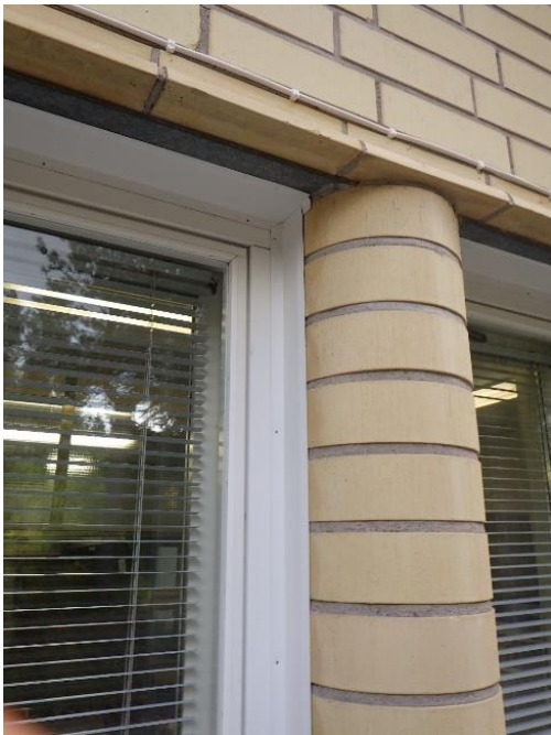
Kuva 105. Rakennuksen osan B julkisissa on osassa ikkunaväleistä muuratut pilasterit.
