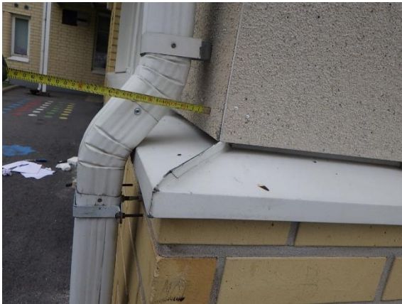
Kuva 126. Ulkoseinärakenteen US8 julkisivuna on sekä kivisirotepintaista julkisivulevyä että keltaista savitiilimurausta.
