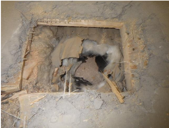
Kuva 165. Rakenneavaus RA-VP4. Ylälaattapalkiston puukoolatun lattian rakennekerrokset.
