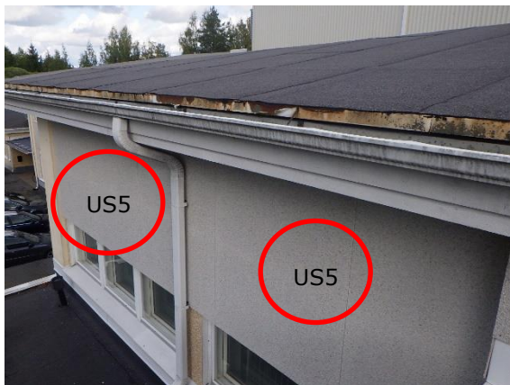
Kuva 119. Ulkoseinärakennetta on liikuntasalin länsisivulla.
