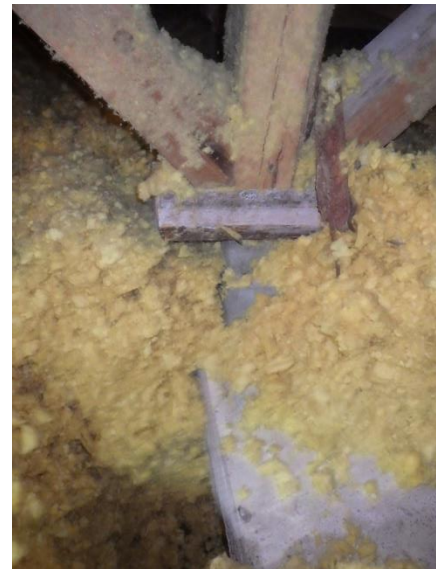
Kuva 194. Puiset vesikattorakenteet tukeutuvat teräsbetonipalkistoon.
