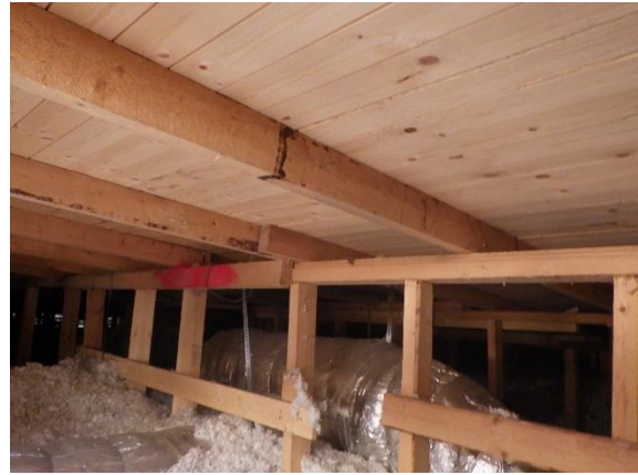
Kuva 228. Yläpohjatilassa ei havaittu viit- teitä puutteellisesta tuulettumisesta.
