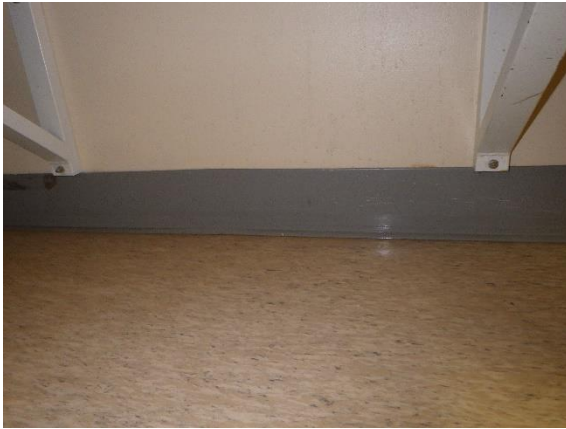
Kuva 40. Rakennuksen länsisivulla liikuntasalin pukuhuoneessa on jalkalistana seinään liimatut muovilistat.
