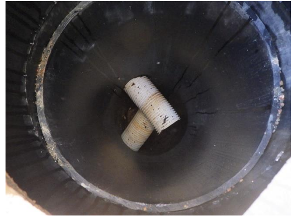
Kuva 4. Kuva tarkastuskaivosta numero 2. 1950-luvun rakennuksen osan länsisivulla salaojitusputkisto on vuoden 1991 peltosalaojaputkea.
