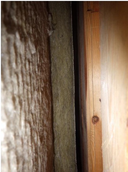
Kuva 218. Ruokalan yläpohjan ontelotila tuulettuu ulkoseinän tuuletusvälin kautta.
