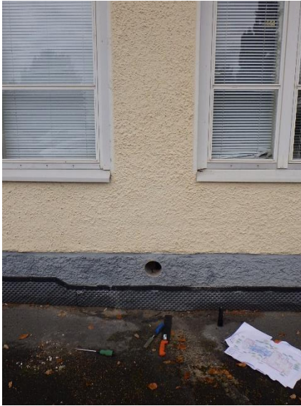
Kuva 82. Rakenneavaus RA-US13.1, ikkunoiden välissä oleva ulkoseinärakenne.
