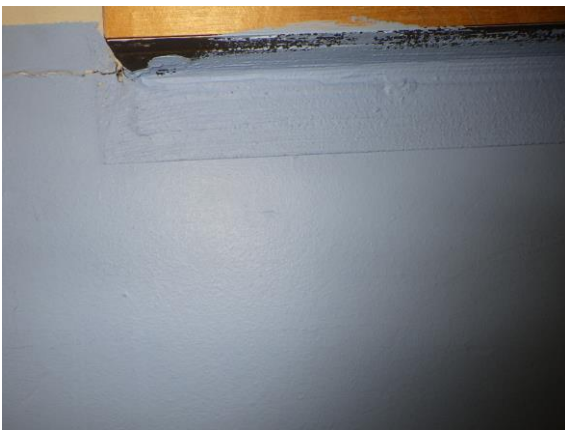
Kuva 108. Vahvikenauhalla tiivistyskorjattu ikkunapenkin ja ulkoseinän liitos.
