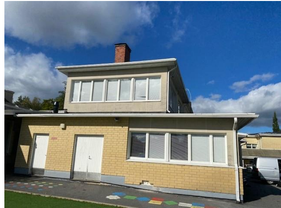
Kuva 125. Ulkoseinärakenne US8 on rakennuksen A osan eteläpäätyyn vuonna 1998 tehdyssä laajennuksessa.
