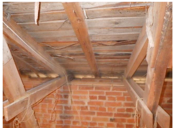
Kuva 197. Yläpohjarakenteen tuulettumisessa ei havaittu puutteita.
