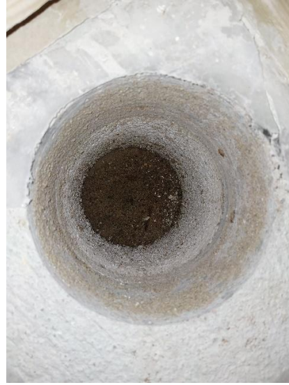
Kuva 17. Rakenneavaus RA-AP10. Puulattia on tehty alapuolelta lämmöneristetyt teräsbetonilaatan päälle.
