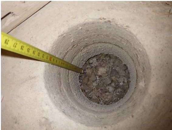
Kuva 49. Rakenneavaus RA-AP1. Maanvaraisen teräsbetonilaatan rakennekerrokset.
