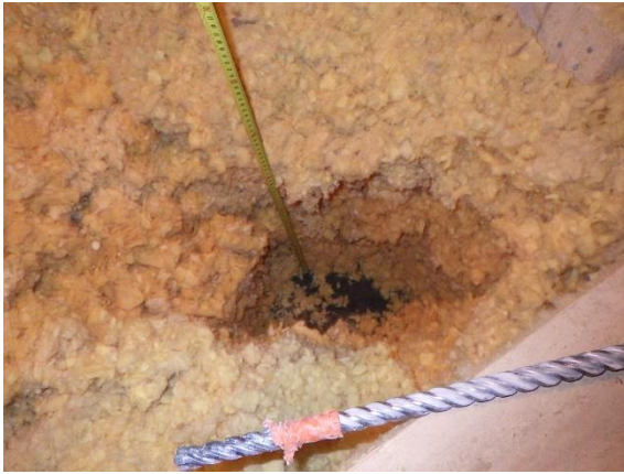
Kuva 191. Rakenneavaus RA-YP1. Yläpohjan YP1 rakennekerrokset ullakkotilasta tarkistettuna.
