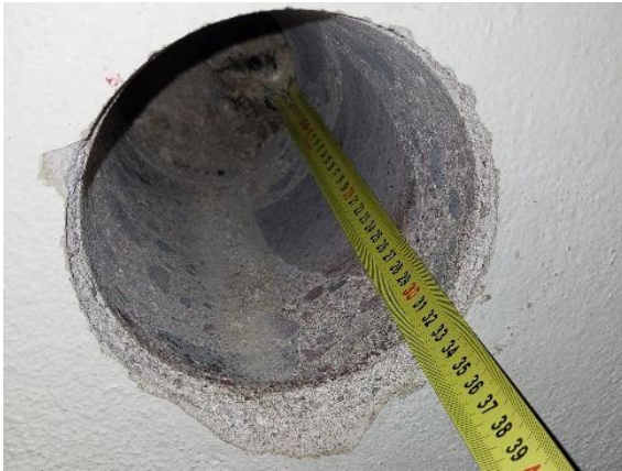
Kuva 54. Rakenneavaus RA-KS1. Kellarikerroksen maanvastainen seinärakenne KS1 on paikalla valettu teräsbetoniseinä.
