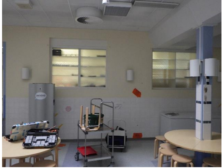
Kuva 177. Ruokala on laajennettu 1950-luvun rakennuksen osan yhteyteen vuonna 1991. Laajennuksessa ulkoseinä on muuttunut väliseinäksi.
