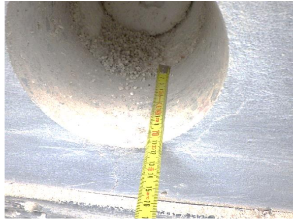
Kuva 116. Rakenneavaus RA-US1. Ulkoseinän sokkelirakenteessa on lämmöneristeenä EPS.
