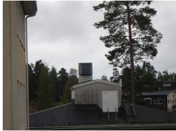
Kuva 280. Ulkoilmasäleikössä on lumiloukku.
