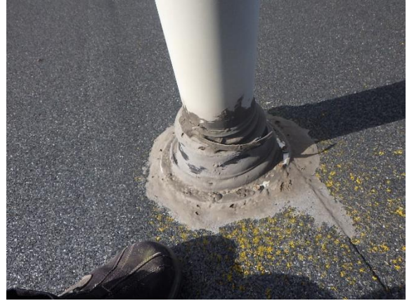
Kuva 236. Läpivientikappaleen kiristys-panta on irronnut.
