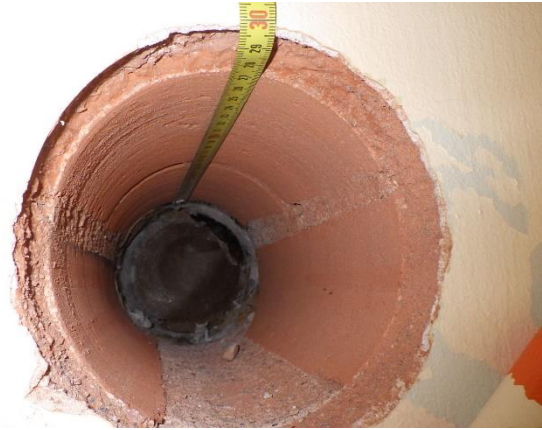
Kuva 73. Rakenneavaus RA-US9. Kantavan massiivitiiliseinän paksuus on 280–300 mm.
