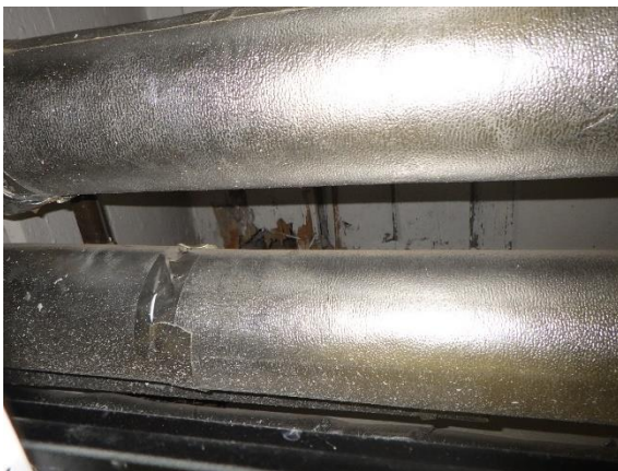
Kuva 166. Ensimmäisen kerroksen käytävän 1004 ja 1005 alakattotilassa on ylälaattapalkiston muottilauoituksia.
