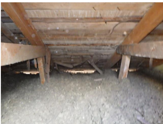
Kuva 207. Yläpohjarakenne tuulettuu räystäiden tuuletusaukkojen kautta.
