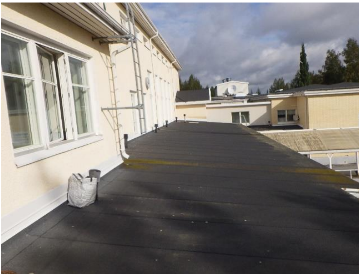
Kuva 237. 1950-luvun yksikerroksisen osan yläpohja tuulettuu räystäiden ja alipaineventtiilien kautta.
