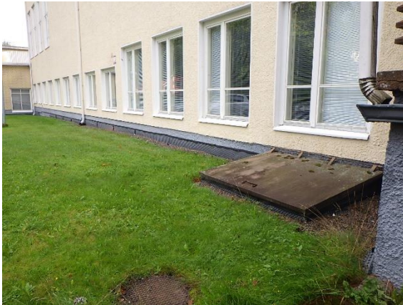
Kuva 65. 1950-luvun rakennuksen osan länsisivu. Julkisivun rappaus- ja maalipinta on hyväkuntoinen.
