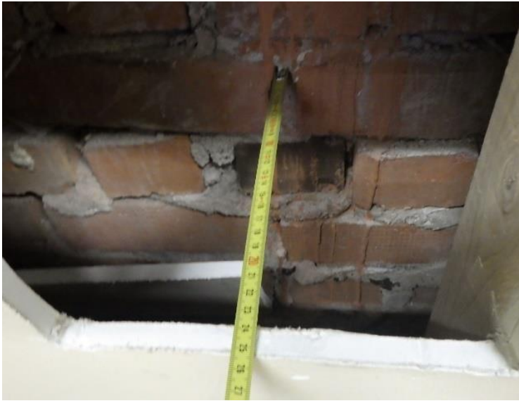
Kuva 183. Rakenneavaus RA-VS3. Korjatun väliseinän sisäpinnassa on tilan 1031 puolella puurankarunkoinen ja levyverhottu seinärakenne.
