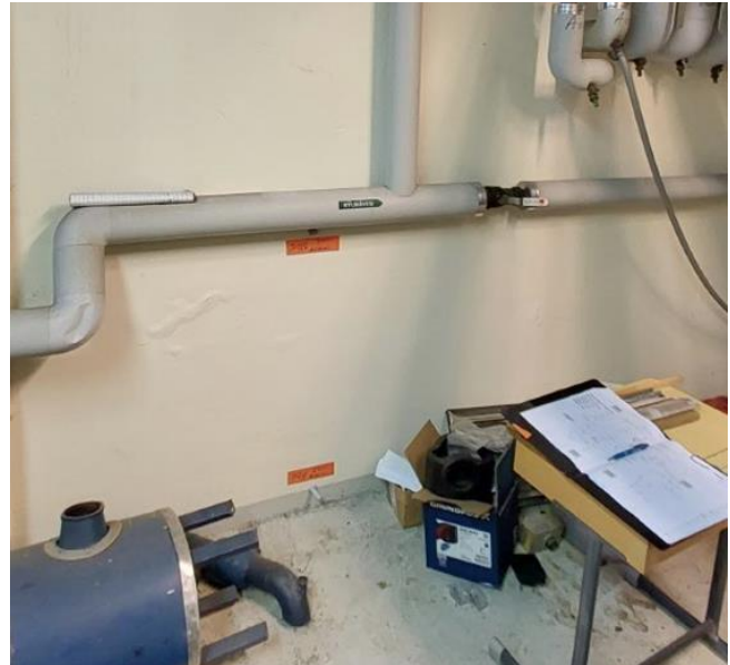
Kuva 58. Kellarin muurattu väliseinärakenne. Alhaalla porareikämittaus PR3 ja ylempänä PR4. Porareikien syvyys 50 mm.
