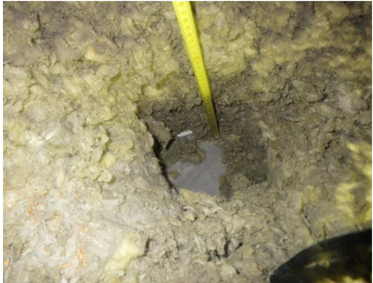
Kuva 211. Keskellä rakennusta yläpohjan YP5 lämmöneristeenä on puhallusvilla, minkä kerrospaksuus on noin 300 mm
