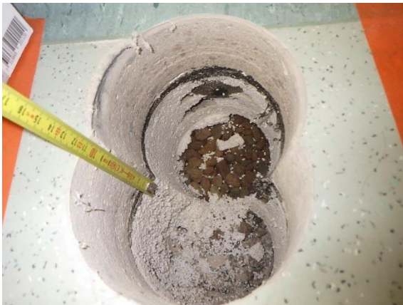
Kuva 27. Rakenneavaus RA-AP5. Vuonna 2005 peruskorjattu alapohjarakenne AP4.
