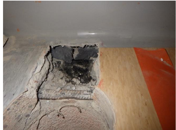
Kuva 34. Rakenneavaus RA-AP2. Teräsbetonilaatan alla oleva tervapaperi / sitkeä suojapaperi on asennettu betonilaatan ja ulkoseinän erotuskaistaksi.
