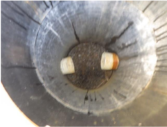
Kuva 3. Kuva tarkastuskaivosta numero 1. Vuonna 1991 valmistuneen laajennusosan itäsivulla salaojaputkiston on yksinkertaista peltosalaojaputkistoa.
