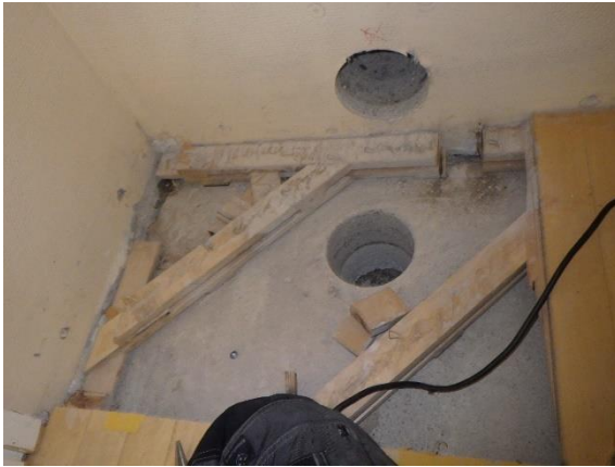
Kuva 47. Rakenneavaus RA-AP1. Liikuntasalin koolattu puulattia.
