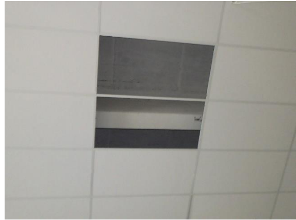
Kuva 192. Sisäkaton takana on näkyvissä yläpohjan kantavana rakenteena oleva ylälaattapalkisto. Kuva tilasta 2007.
