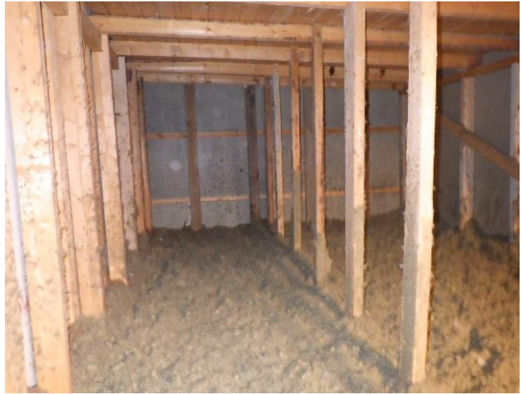
Kuva 219. Ruokalan yläpohjatilassa ei havaittu vaurioita.
