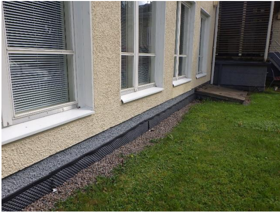
Kuva 149. 1950-luvun rakennuksen osien ikkunapellitusten kaadot ovat riittävät.
