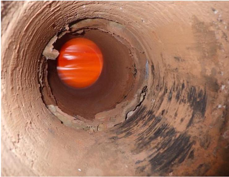
Kuva 180. Rakenneavaus RA-VS2. Väliseinärakenteessa on alkuperäinen 1950-luvun ulkoseinän kuorimuuraus ja lämmöneristys. Kuva ruokalan väliseinärakenteesta.
