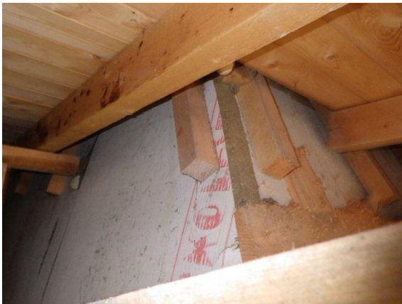
Kuva 261. Ruokalan yläpohjan ontelotila tuulettuu kattoikkunoiden pellitysten kautta. Kattoikkunoita vasten olevat ul- koseinärakenteet ovat hyväkuntoisia.
