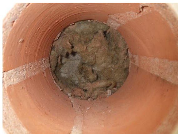
Kuva 189. Rakenneavaus RA-VS4. Ulkoseinästä muutetun väliseinän entisen kuorimuurauksen takana oleva mineraalivillaeristys.
