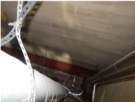
Kuva 172. Kuva vuoden 1998 laajennusosan alakattotilasta, missä näkyvissä toisen kerroksen välipohjarakenne sekä sitä kantava teräsrunko.
