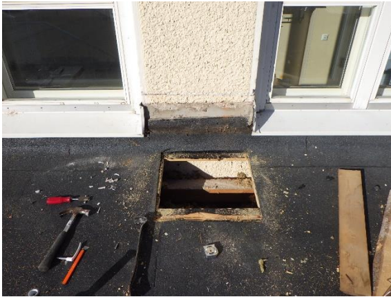
Kuva 201. Yläpohjarakenteen rakenneavaus RA-YP3 1950-luvun yksikerroksisella osalla.
