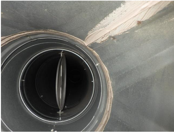
Kuva 284. Tuloilmakanavisto oli tarkastushetkellä juuri puhdistettu.
