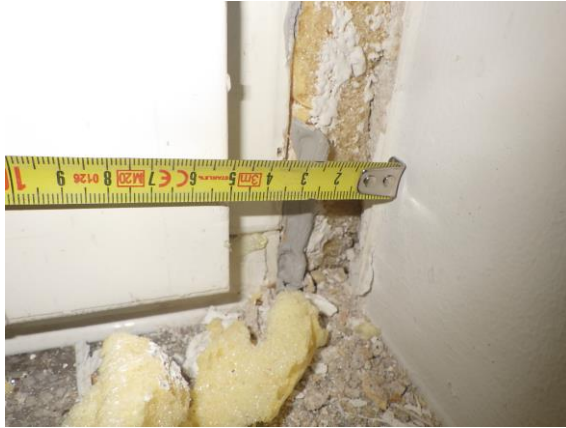
Kuva 85. Luokkatilan 1007 (ATK-luokka) ikkunan ja ulkoseinän liitos.
