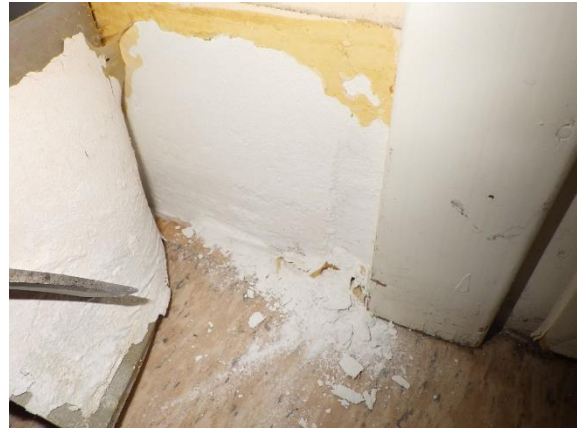
Kuva 41. Jalkalistojen takana ei havaittu betonilaatan ja ulkoseinän liitoksessa näkyvää betonin kuivumiskutistumaa.
