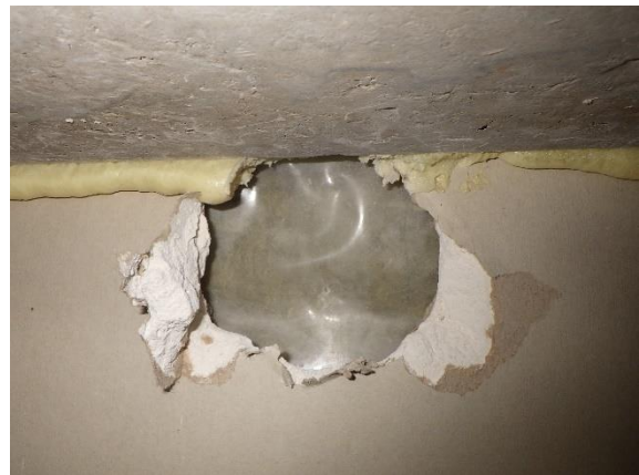
Kuva 103. Rakenneavaus RA-US20. Talotekniikkakoteloinnin kohdalla ulkoseinässä on rakennusmuovi höyrysulkuna.
