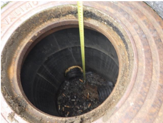
Kuva 5. Kuva tarkastuskaivosta numero 3. Vuoden 1998 laajennusosassa on keksiseinämainen salaojitusputkisto.
