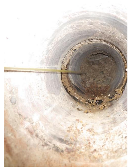
Kuva 181. Rakenneavaus RA-VS2. Väliseinässä on alkuperäinen 1950-luvun sokkelirakenne, missä lämmöneristeenä on lastuvillalevy. Kuva ruokalan väliseinärakenteesta.
