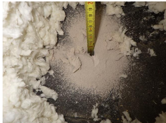
Kuva 226. Teräsbetoni-laatan pinnassa on höyrysulkuna bitumikermi.
