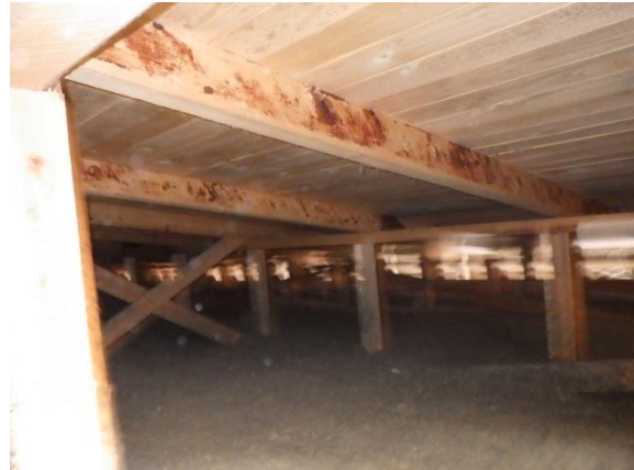
Kuva 215. Yläpohja tuulettu räystäsraakenteiden kautta.
