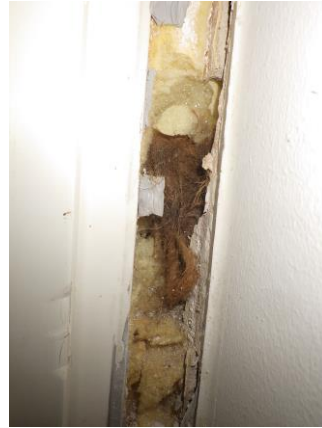
Kuva 86. Alkuperäisen apukarmin tilke-eristeenä on pellavarivettä.
