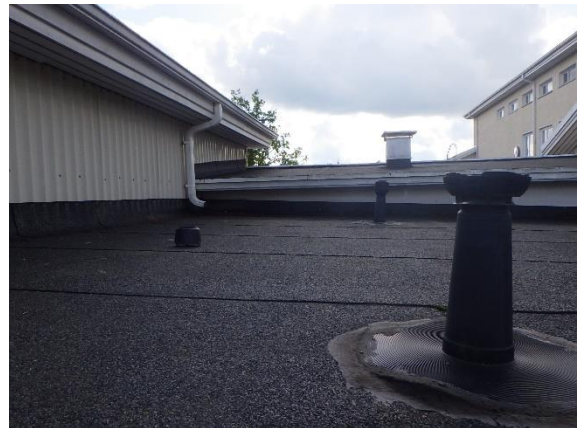
Kuva 254. Ruokalan katolle johdetaan kattovesiä ylemmiltä kattopinnoilta.
