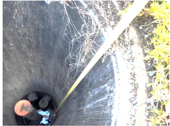
Kuva 8. Kuva tarkastuskaivosta numero 7. Kellarikerroksen kohdalla salaojitusputkisto on noin 1600 mm maanpinnan alapuolella. Putkiston on kaksinkertaista salaojitusputkea.
