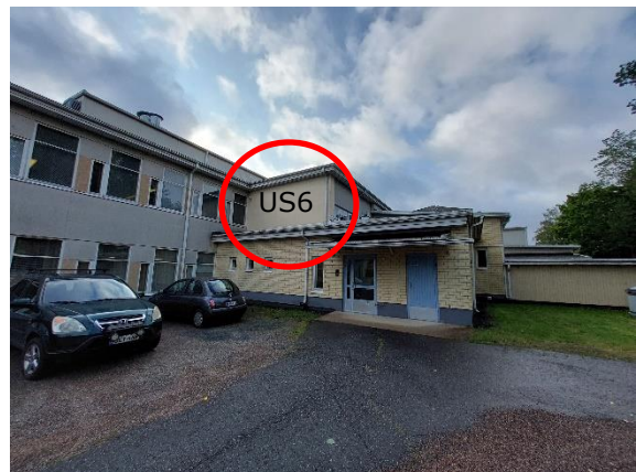
Kuva 120. Ulkoseinärakennetta US6 on liikuntasalin pohjoissivulla.
