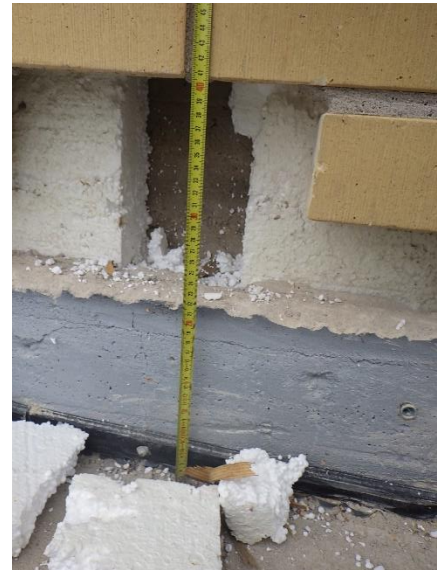
Kuva 134. Ulkoseinän alaosaa on lämmöneristetty EPS-eristeellä lattiapinnan alapuolelta.
