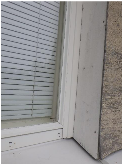
Kuva 154. Vuoden 1998 laajennusosassa on alumiinipuitteisiä MSE-ikkunoita.
