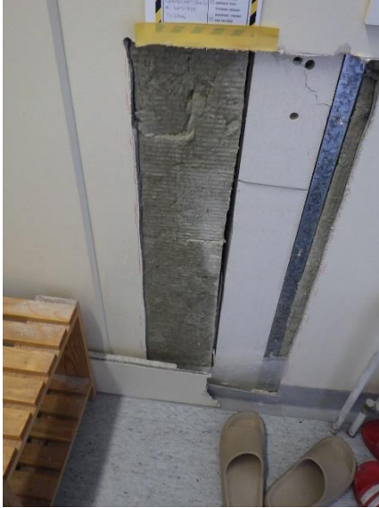
Kuva 112. Rakenneavaus RA-US10. Ulkoseinärakenne US2 on metallirankarunkoinen.
