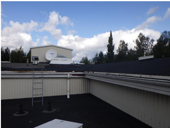
Kuva 253. Ruokalan katto on ympäröiviä vesikattoja alempana.
