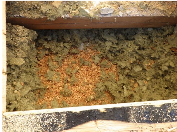
Kuva 202. Yläpohjaan on lisätty puhallusvillaa vanhan kutterilastun päälle. Tuulettusväli 20–100 puhallusvillan päällä.
