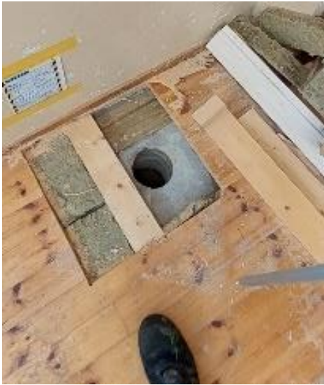
Kuva 16. Rakenneavaus RA-AP10. Puukäsityön luokassa on maanvaraisen teräsbetonilaatan päälle koolattu puulattia.
