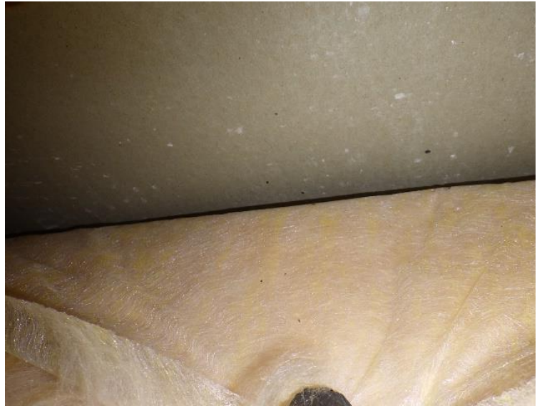
Kuva 222. Tuulensuojakipsilevyn alapinnalla ei havaittu viitteitä vaurioista.
