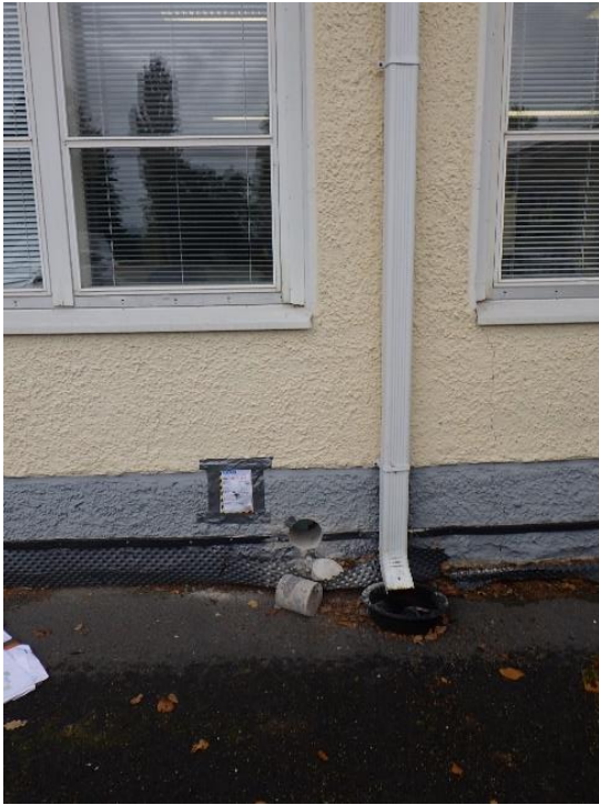
Kuva 80. Rakenneavaus RA-US13, rakennuksen itäsivu.
