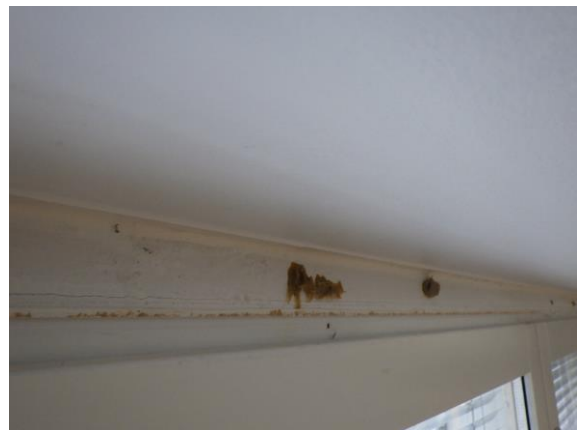
Kuva 109. Ikkunan ja ulkoseinän liitos on tehty uretaanivaahdotuksella ja massauksella ikkunan yläosasta. Liitos on aistienvaraisesti arvioituna melko ilmatiivis.
