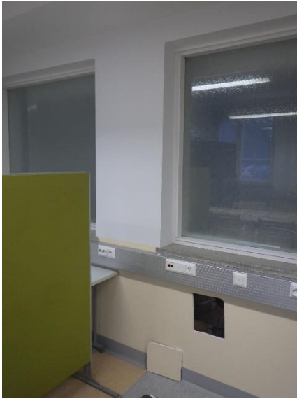
Kuva 176. 1950-luvun rakennuksen osaa on laajennettu. Laajennuksessa ulkoseinä on muutettu väliseinäksi, kuva tilasta 1031.
