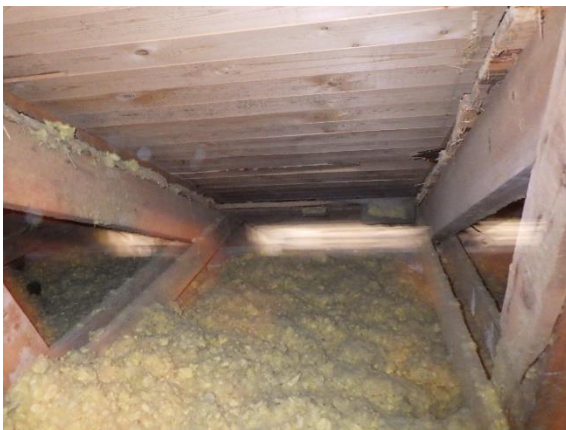
Kuva 196. Yläpohjarakenne tuulettuu räystäiden tuuletusaukkojen kautta
