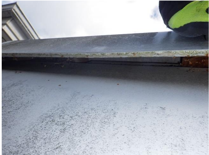
Kuva 260. Ruokalan yläpohjarakenne tuulettuu räys- täiden kautta.
