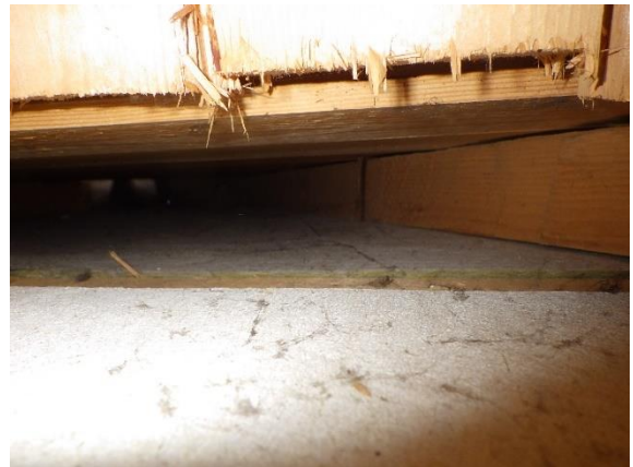
Kuva 262. Ruokalan yläpohjan ontelotila tuulettuu kattoikkunoiden pellitysten kautta. Kattoikkunoita vasten olevat ul- koseinärakenteet ovat hyväkuntoisia.
