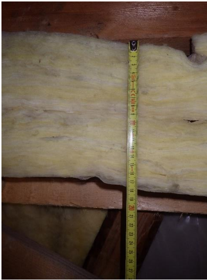
Kuva 221. Lämmöneristeenä käytetyn mineraalivillan kerrospaksuus on noin 200 mm.
