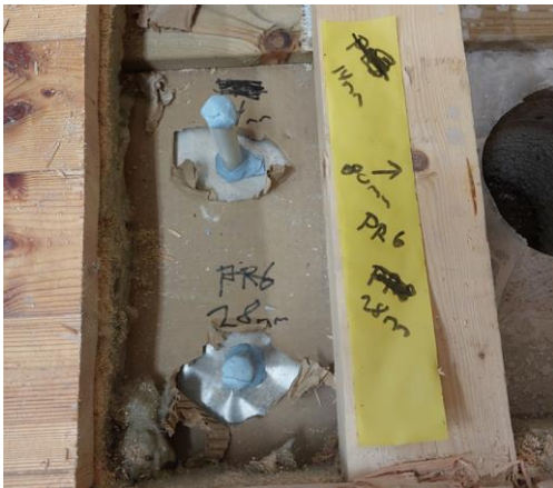
Kuva 18. Porareikämittaukset (PR6) kahdelta eri syvyydeltä teräsbetonilaatassa rakenneavauksen RA-AP10 kohdalla.
