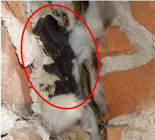
Kuva 187. Verhomuurauksen takana olevasta bitumipaperista otettiin näyte PA4.
