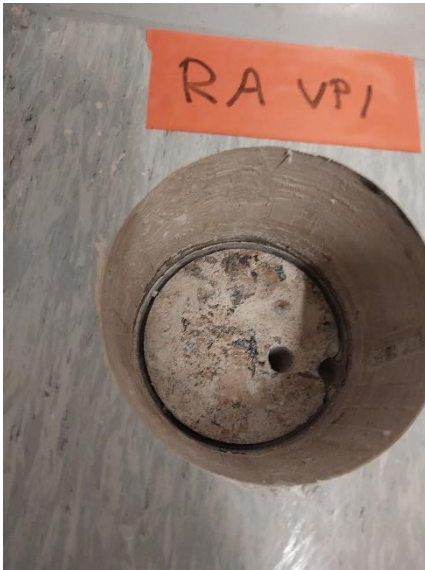
Kuva 164. Rakenneavaus RA-VP1. Väli- pohjan VP3 rakennekerrokset.
