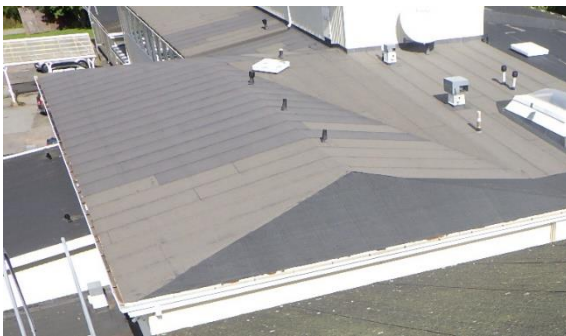
Kuva 249. Liikuntasalin bitumikermikatetta on osittain uusittu vuoden 1991 korjauksen jälkeen.
