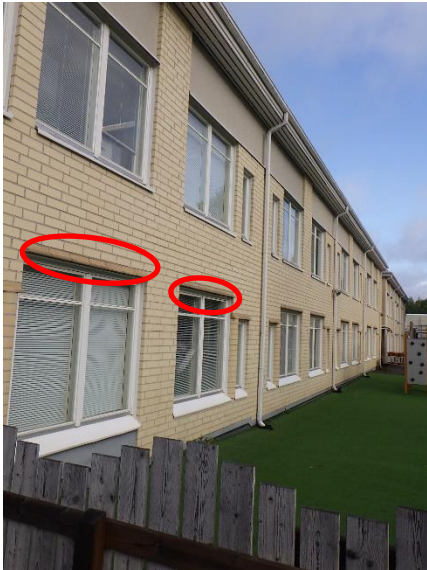
Kuva 104. Rakennuksen B osan julkisivussa on ensimmäisen kerroksen ikkunoiden yläpuolella savitiilestä muuratut ulokkeet.
