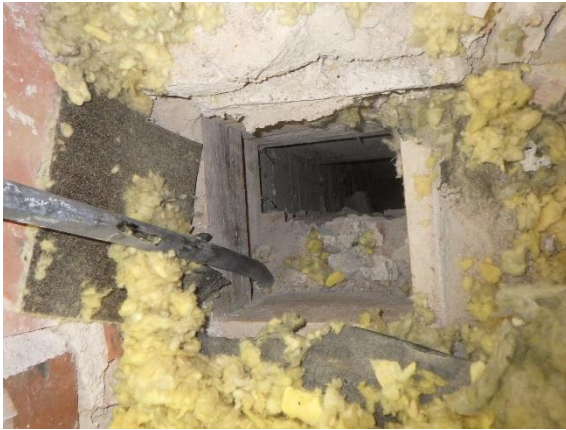
Kuva 198. Käytöstä poistettu ilmanvaihdon poistohormi on avoin yläpohjatilaaan
