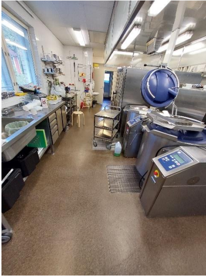
Kuva 36. Keittiön lattiapinnoitteena ja vedeneristeenä on akryylibetoni.
