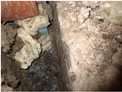
Kuva 84. Rakenneavauskohdassa RA-US13.1 sokkelihalkaisu on täytetty sepelillä.
