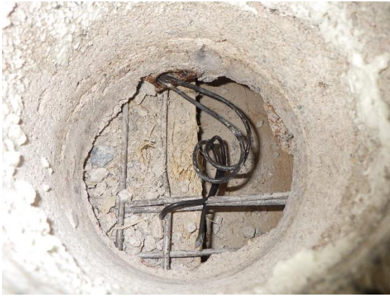
Kuva 168. Ensimmäisen kerroksen käytävän alakatossa olevat muottilauδοitukset, kuva rakenneavauksesta RA-VP5.
