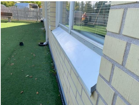
Kuva 151. 1990-luvun rakennuksen osan ikkunapellitusten kaadot ovat riittävät.
