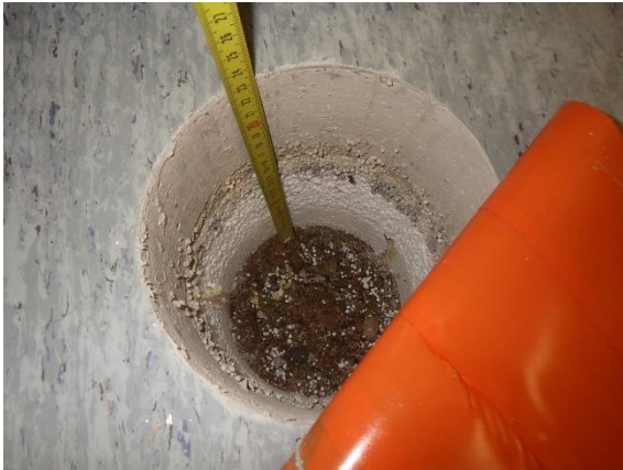
Kuva 33. Rakenneavaus RA-AP4. Alapohjarakenteeseen AP5.
