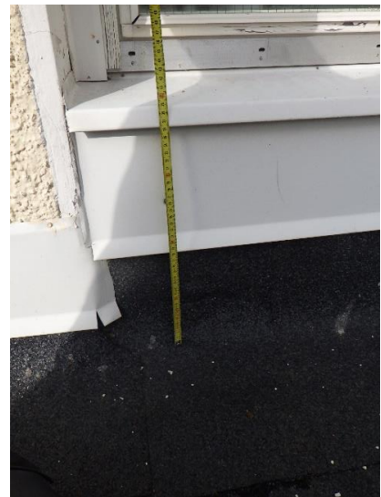
Kuva 238. Vesikaton rintataitetta suojaa pellitys.
