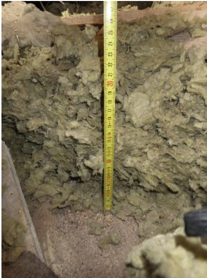
Kuva 205. Yläpohjan YP4 rakenneavaus RA-YP4. Puhallusvillan kerrospaksuus on 200-250 mm.
