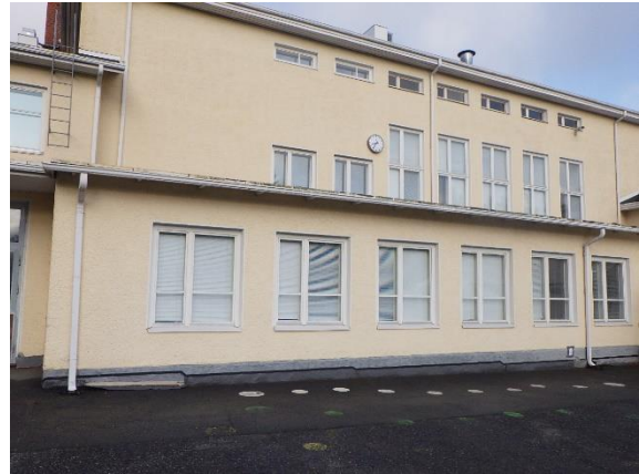
Kuva 66. 1950-luvun rakennuksen osan itäisivun julkisivun rappaus- ja maalipinta on hyväkuntoinen.
