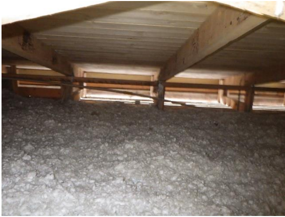
Kuva 227. Yläpohjatila tuulettuu räystäs- rakenteiden kautta.
