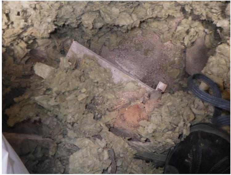
Kuva 206. Puhallusvillakerroksen seassa havaittiin vanhoja ruodelautoja.
