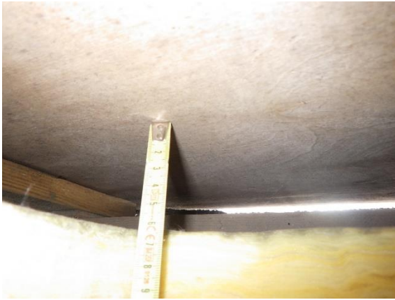
Kuva 141. Toisen kerroksen sirotekivipintaisen julkisivulevyn takana on noin 50 mm tuuletusväli.
