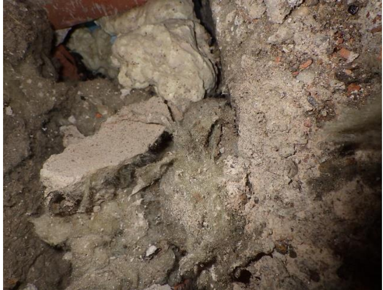
Kuva 83. Rakenneavauskohdassa RA-US13.1 massiivitiilisen ja kuorimuurauksen välissä on mineraalivil-läeristys, mikä jatkuu sokkelihalkaisuun asti.
