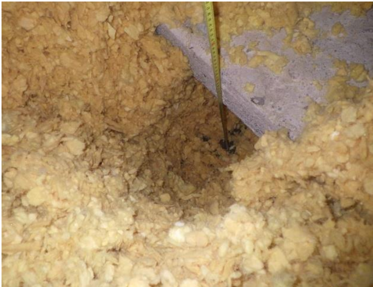
Kuva 193. Ylälaatta on purettu ja vanhat eristemateriaalit on korvattu puhallusvillalla.
