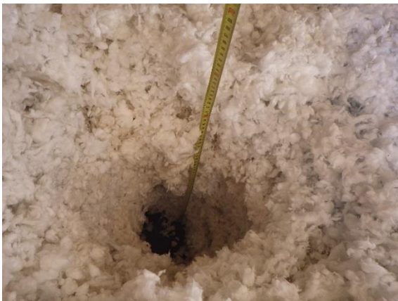
Kuva 225. Puhalluslasivillan kerrospaksuus on noin 500 mm.
