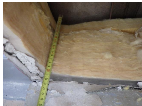
Kuva 136. Rakennesaavaus RA-US8 (2. krs). Ulkoseinän US8 rakennekerrokset.
