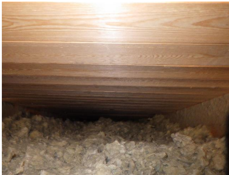
Kuva 204. Yläpohjan aluslaudoituksessa ei havaittu aistinvaraisesti vaurioita, jotka olisivat aiheutuneet riittämättömästä tuulettumisesta.
