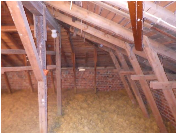
Kuva 233. Alkuperäisissä vesikattorakenteissa ei havaittu merkittäviä vaurioita.
