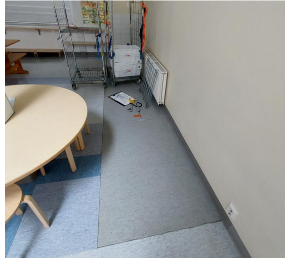
Kuva 39. Viiltomittaus VM2 uusitun muovimaton alueelle.
