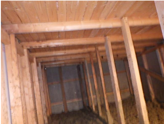
Kuva 214. Yleiskuva yläpohjarakenteista. Rakenteissa ei havaittu laaja-alaista vaurioitumista.
