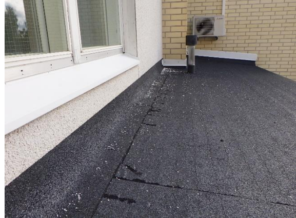
Kuva 113. Kuva 1950-luvun ja 1990-luvun rakennuksien osien välisen yhdyskäytävän julkisivusta.
