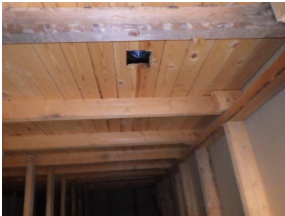
Kuva 220. Vesikaton ponttilaudoituksissa ei havaittu merkkejä mikrobikasvustosta tai muista vaurioista.
