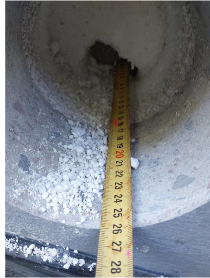
Kuva 94. Rakenneavaus RA-US17. Sokkelihalkaisun lämmöneristeenä on solupolystyreeni.
