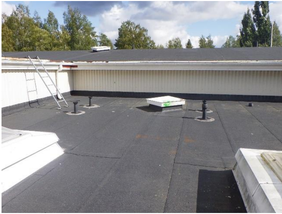
Kuva 144. Ulkoseinärakennetta US9 on näkyvässä ruokalan, liikuntasalin sekä kaksikerroksisen rakennuksen osan liitoksessa.
