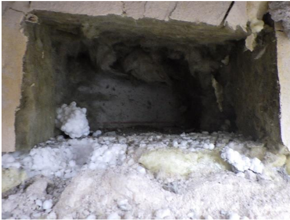
Kuva 115. Rakenneavaus RA-US1. Ulkoseinän sokkelirakenteessa on lämmöneristeenä EPS.
