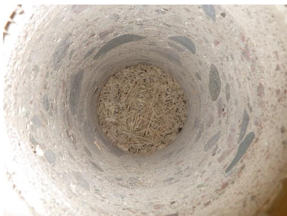
Kuva 188. Rakenneavaus RA-VS1. Ulkoseinästä muutetun väliseinän alkuperäisen sokkelin lämmöneristeenä on lastuvillalevyä.
