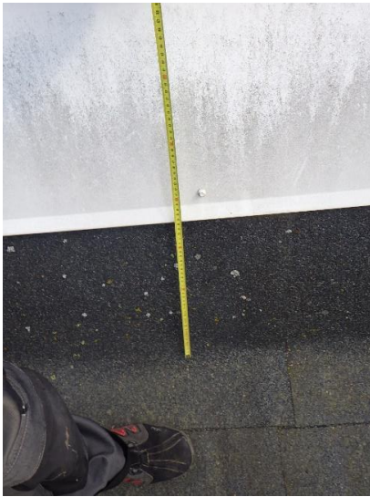
Kuva 259. Vesikatteen ylös- nosto ulkoseinälle on riittävä.
