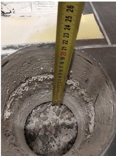
Kuva 22. Rakenneavaus RA-AP9. Alapohjarakenteen AP3 rakennekerrokset.
