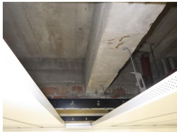
Kuva 167. Kuva käytävän 1005 alakattotilasta, mistä muottilauoituukset on poistettu alakattotilasta.
