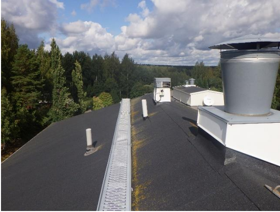
Kuva 235. Yleiskuvaa alkuperäisen osan vesikatolta.
