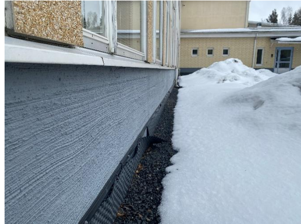
Kuva 27. Yleiskuva uusitusta ulkoseinän alaosasta US-1.
