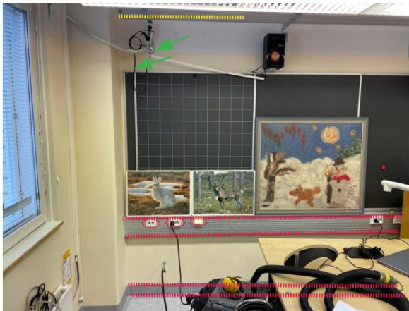
Kuva 53. Merkkiainekoe US 2. Merkkiainekokeessa havaitut merkittävät ilmapuodot on esitetty punaisella, vähäiset ilmapuodot keltaisella ja pistemäiset ilmapuodot vihreällä.
