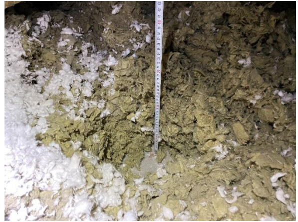
Kuva 93. Rakennearaus RA-YP 2. Ontelolaa- tan yläpinnassa on höyrynsulku- muovi.
