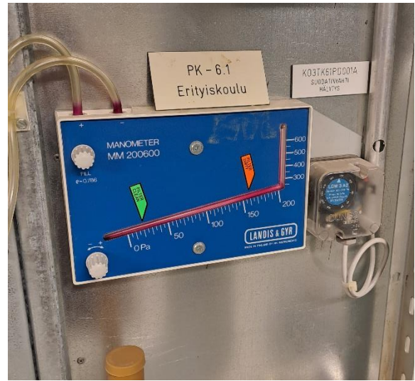
Kuva 111. Suodatinvahdistusta puuttuu manometrimesteet.
