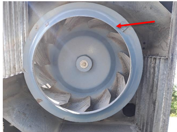
Kuva 123. Siipipyörässä on lommo.
