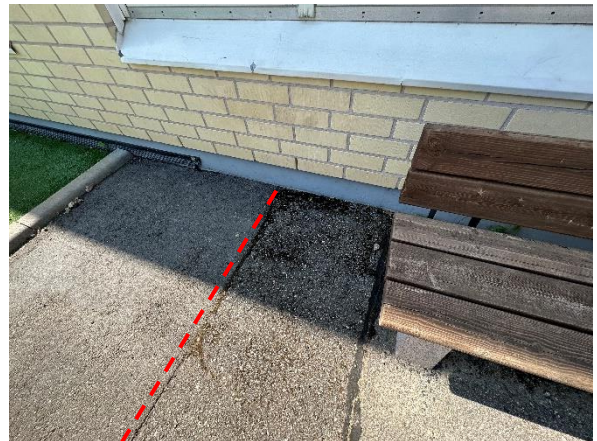
Kuva 6. Lähikuvaa uusitun ja vanhemman alueen rajapinnasta sisäänkäyntikatosten kohdalta. Sisäänkäynnin kohdalla asfaltti on vanhempaa.
