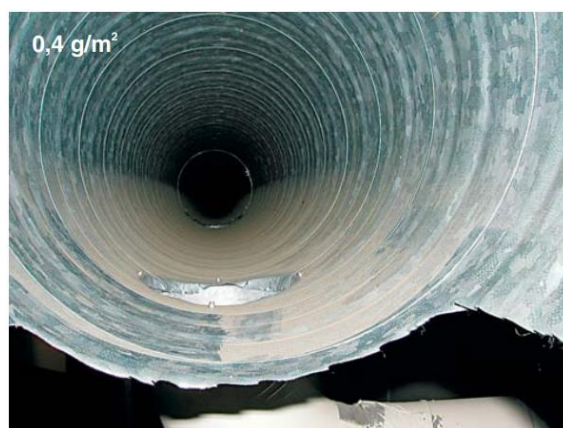
Kuva 129. Vertailukuva pölykertymästä 0,4 g/m 2 (lähde: ohje LVI 39-10409).
