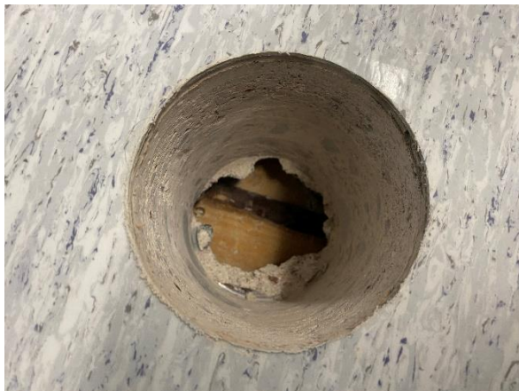
Kuva 66. Rakenneavaus VP-2 alkuperäiseen osaan. Välipohja on betonirakenteinen. Alapinnassa on vaihdellen puukoolaus ja akustiikkalevytys sekä ripustettu alakatto.
