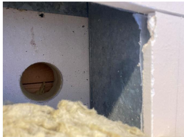
Kuva 58. Rakenneavaus US-10 sisäänkäynnin vesikatteen ja ulkoseinän liitokseen. Ulkoseinä on toteutettu metallirunkoisena ja mineraalivillaeristettynä. Rakenteessa ei havaittu viitteitä vaurioista.
