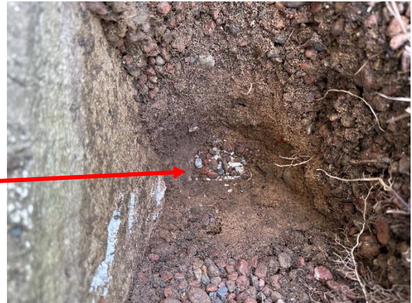
Kuva 10. Rakennuksen pohjoispäädystä maa-aines on hienojakoista hiekkaa. Koekuopan perusteella sokkelin vierustalla on vaakasuuntainen routaeristys.
