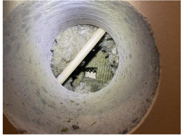
Kuva 42. Rakenneavaus RA-US 9 jäykistävään seinään. Jäykistävien ulkoseinien kohdilla sisäkuori on betonia.
