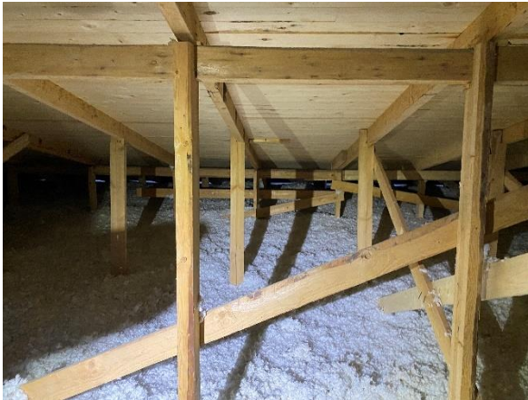
Kuva 88. Yleiskuvaa yläpohjatilasta alkuperäisen osan kohdalta. Yläpohjan puhallusvilla ja vesikaton aluslaudoitukset on uusittu ja ne ovat hyväkuntoisia.
