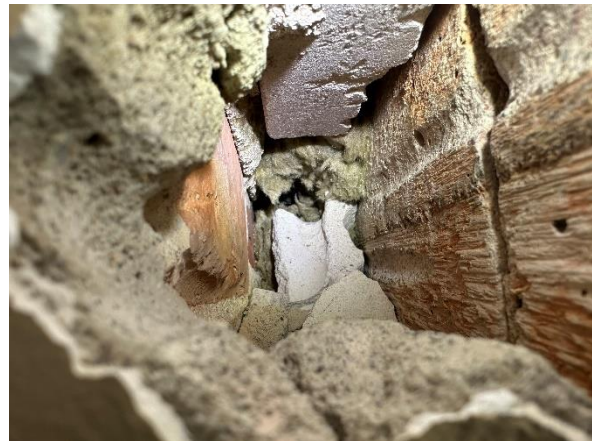
Kuva 73. Rakenneavaus VS-1 alkuperäisen osan ja laajennusosan väliseen seinään. Seinärakenne on alkuperäisen ulkoseinärakenteen US-6 mukainen. Ulko- ja väliseinän eristetilat ovat ilmayhteydessä toisiinsa.
