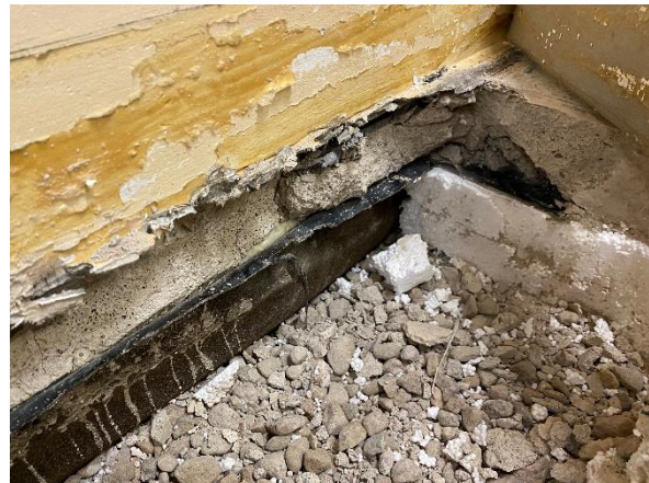
Kuva 17. Rakenneavaus AP-2 Käytävän 1045 alkuperäisen osan väliseinälinjalle. Alapohjan ja väliseinän liittymä on tiivistyskorjattu.
