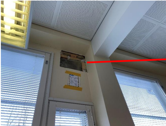
Kuva 34. Toisen kerroksen alkuperäisen osan ikkunauharakenteet on toteutettu sisäosistaan levyverhoiltuina. Kuva luokkatilasta 2028.
