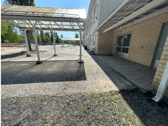
Kuva 3. Yleiskuvaa C-osan itäjulkisivulta. Maanpinnan kallistukset ovat loivat, mutta viettävät kaikkialla rakennuksesta poispäin.
