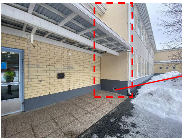
Kuva 47. Alkuperäisen osan jäykistävä päätyseinä (US-6) on toteutettu muista kuorimuuratuista ulkoseinistä poikkeavalla, tuulettumattomalla rakenteella.
