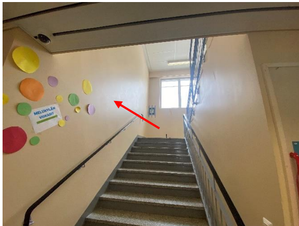
Kuva 72. Alkuperäisen osan ja laajennusosan välistä seinää eli porrashuoneen 1172 ja luokkatilojen 1050 ja 2029 välistä seinää tutkittiin rakenneavauksin.
