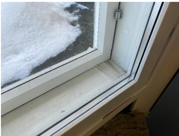
Kuva 59. Ikkuna peltiverhoillun ulkoseinän (US-5) kohdalla eteläjulkisivulla. Ikkunoiden kunto on välttävä.
