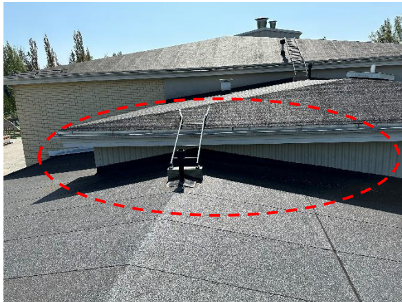
Kuva 80. Vesikate on yleisilmeeltään siisti. Liittyvien korkeampien osien kohdilla yläpohjan tuulettuvuus on heikompi kuin muualla.
