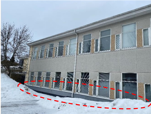
Kuva 26. Yleiskuva julkisivultaan levyverhoiluista ulkoseinästä. Rakennetyyppi US-1 käsittää 1. kerroksen ulkoseinän alaosan.
