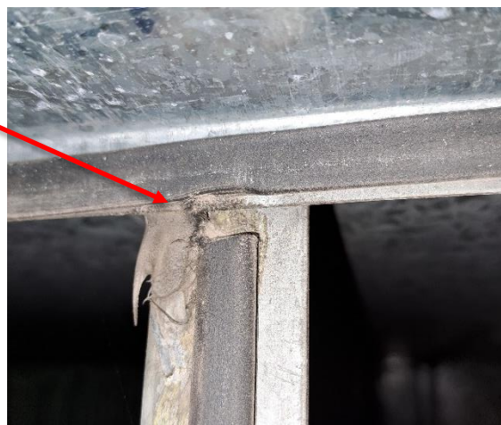
Kuva 105. Lähikuva tiivistyspuutteesta.
