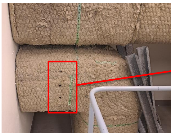
Kuva 132. Mineraalivillaeristettyä kanavaa.
