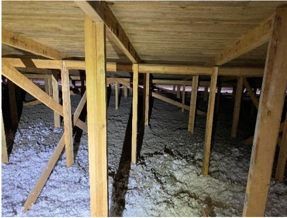
Kuva 90. Yleiskuva laajennusosan yläpohjatilasta. Yläpohjan puhallusvilla on todennäköisesti alkuperäinen.
