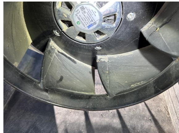
Kuva 121. Siipipyörä on pölyinen.
