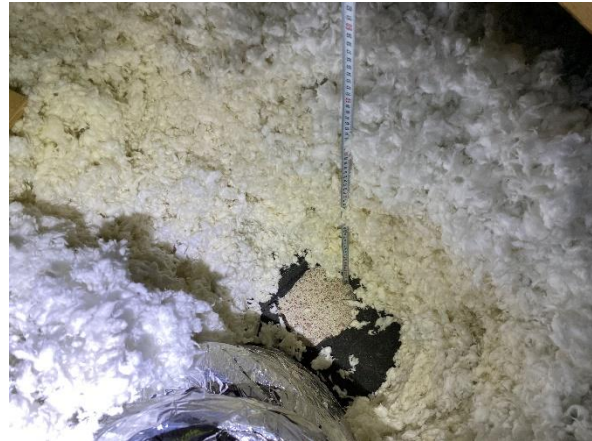
Kuva 89. Rakenneavaus RA-YP 4. Kantavan betonilaatan yläpinnassa on höyrynsulkukermi.
