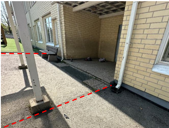
Kuva 5. Salaojien ja sokkelin ulkopuolisten korjausten yhteydessä sisäänkäyntien kohdat on jätetty korjaamatta punaisella esitetyltä alueelta. Kuva rakennuksen itäsivulta.
