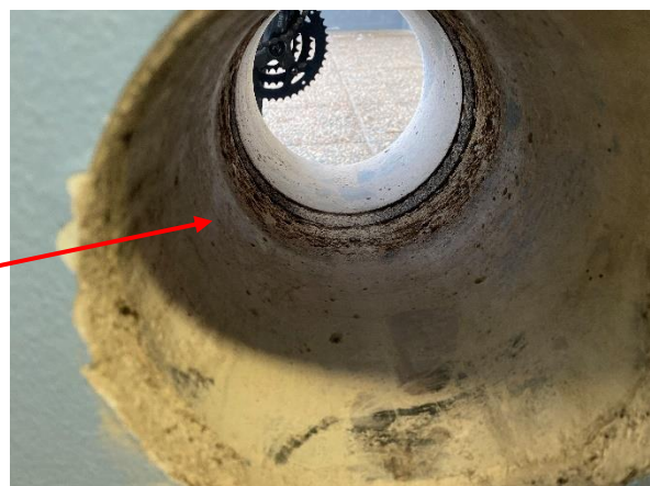
Kuva 48. Sokkelirakenne on päätyseinän kohdalla toteutettu tuulettumattomana korkki- ja toja-levyeristeisenä rakenteena.
