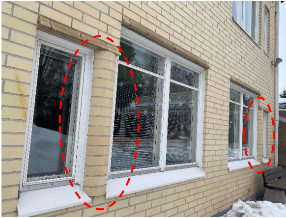
Kuva 43. Ikkunoiden väliset rakenteet on toteutettu erillisten tiilipilastereiden avulla.
