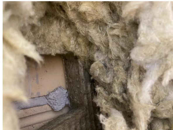
Kuva 46. Rakenneavaus RA-US 16 yksikerroksisen osan ikkunanauharakenteeseen. Ikkunanauharakenteet on toteutettu yksikerroksisella osalla tuulettumattomina.
