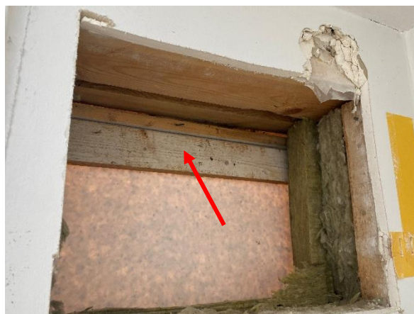
Kuva 31. Rakenneavaus RA-US 3. Ikkunanauharakenteen yläosaan on asennettu vaakakoolaus siten, että se osaltaan heikentää ulkoseinän tuulettuvuutta (punainen nuoli). Rakenteessa ei havaittu viitteitä vaurioista.
