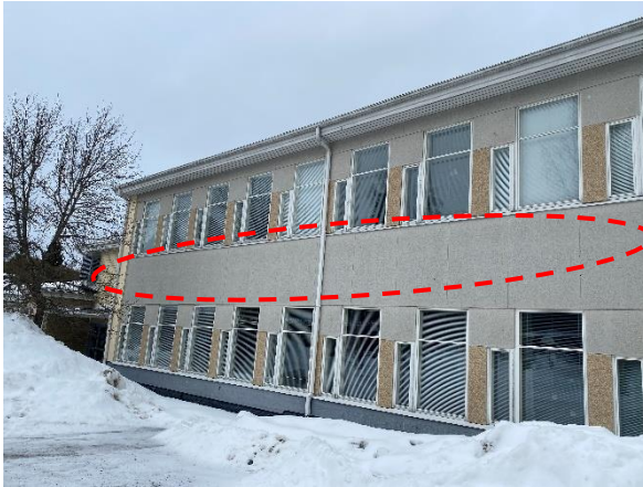
Kuva 32. Yleiskuva julkisivultaan levyverhoillusta ulkoseinästä. Rakennetyyppi US-2 käsittää 2. kerroksen ulkoseinän alaosan.
