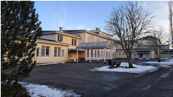
Takajulkisivu 90-luvun laajennusosa sekä sisäänkäyntikatoksen takana 60-luvun osa.
