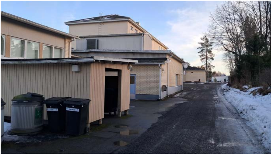
Takajulkisivua. Matalat tiilipintaiset laajennusosat vuodelta 1991.
