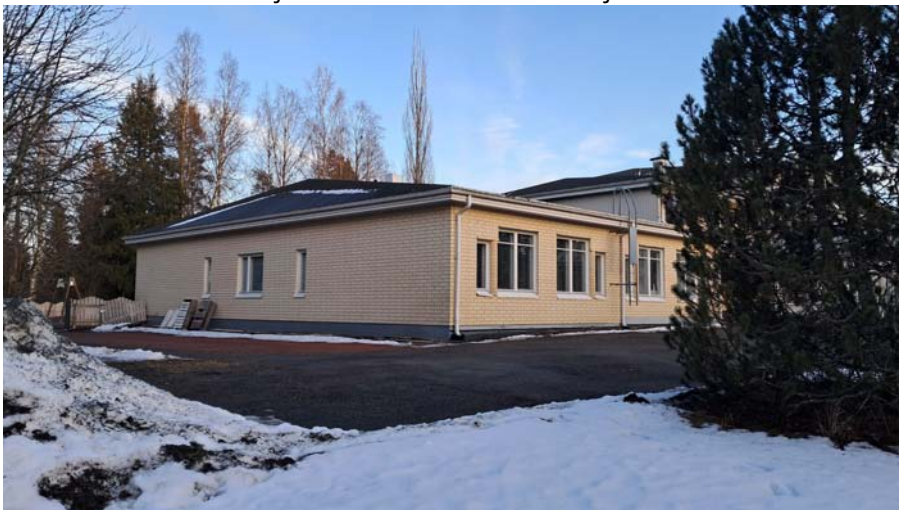
Vuoden 1991-laajennusosan 1-osainen pääty.
