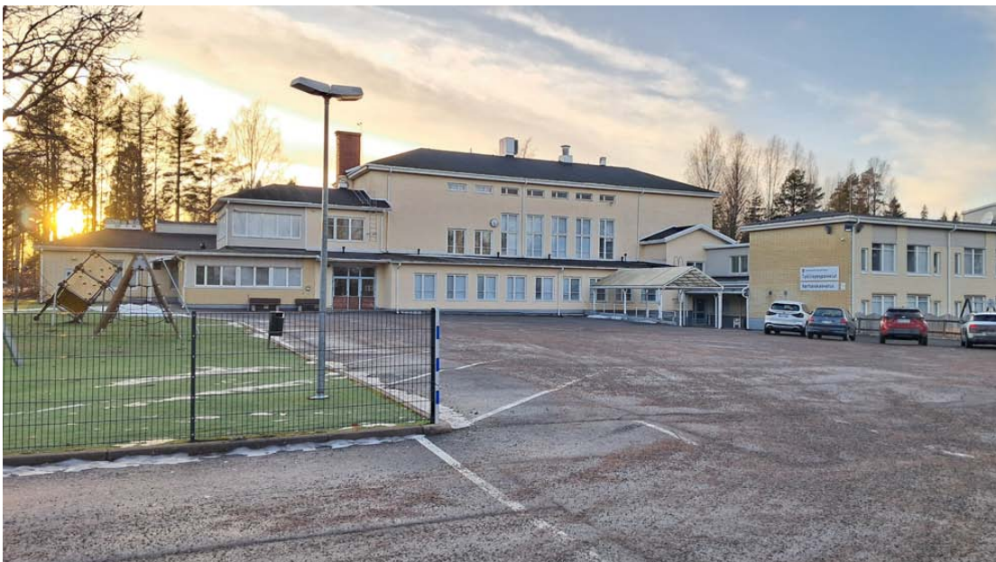
Julkisivu etupiha, vanhin 1950-luvun 3-kerroksinen osa. Päädyssä 90-luvun yksikerroksiset laajennusosat ja oikealla 90-luvun kaksikerroksinen laajennusosa. Kuva Eija Pohtola
