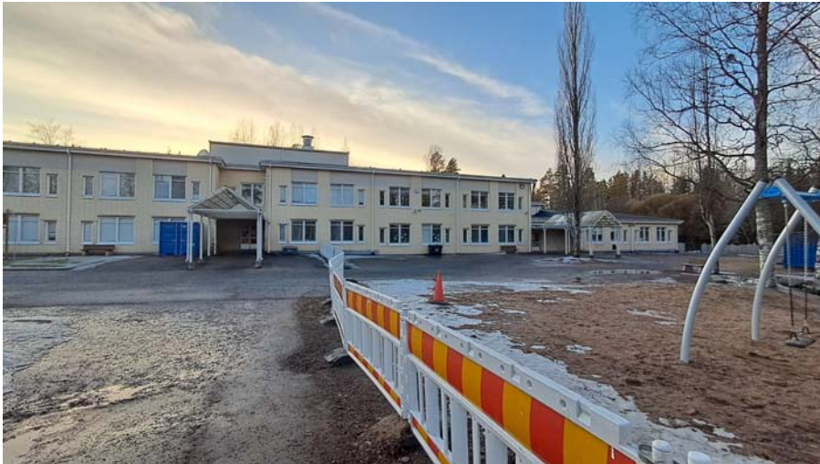
Vuoden 1990-luvun laajennusosan 2-kerroksinen julkisivu.
