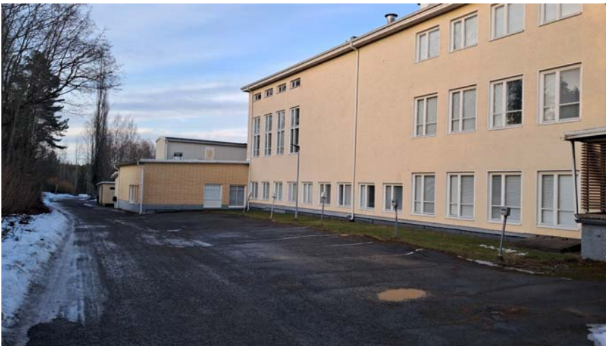
Takajulkisivu 50-luvun alkuperäinen rakennus.
