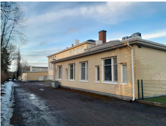
Takajulkisivua, Vuoden 1991 laajennus
