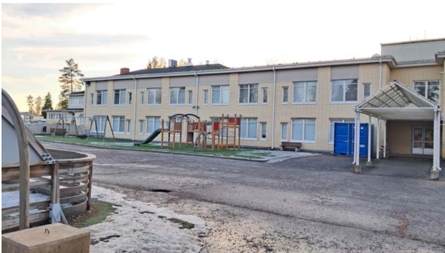
Vuoden 1991-laajennusosan 2-kerroksinen julkisivu.
