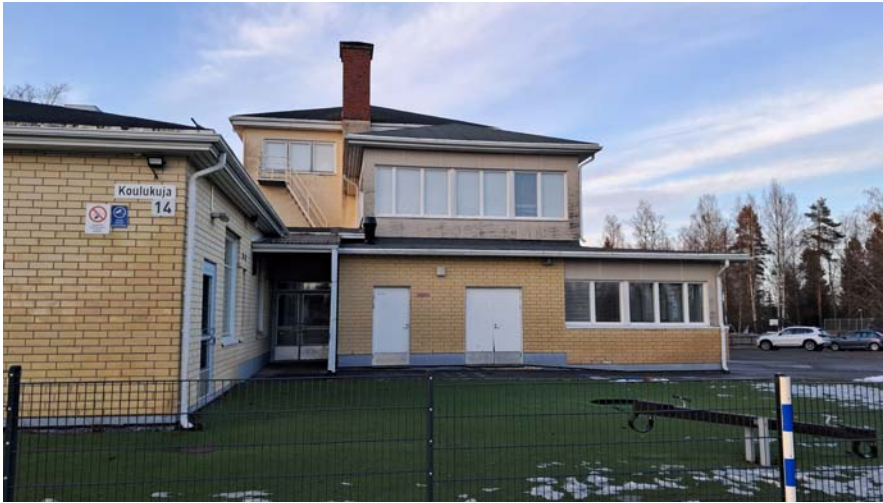
Pääty Koulukuja, oikealla 1998 laajennus, vasemmalla 1991 laajennus, taustalla 50-luvun rakennus
