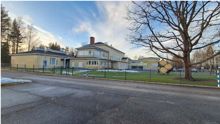
Koulurakennus päädyistä etujulkisivulle päin. Edessä, 3-kerroksisessa rakennuksessa kiinni oleva 1-kerroksinen laajennus 1950-luvun lopulta. Etualalla ja oikealla 50-luvun rakennuksen jatkeena 90-luvun laajennusosat. Kuva 2026 Eija Pohtola
