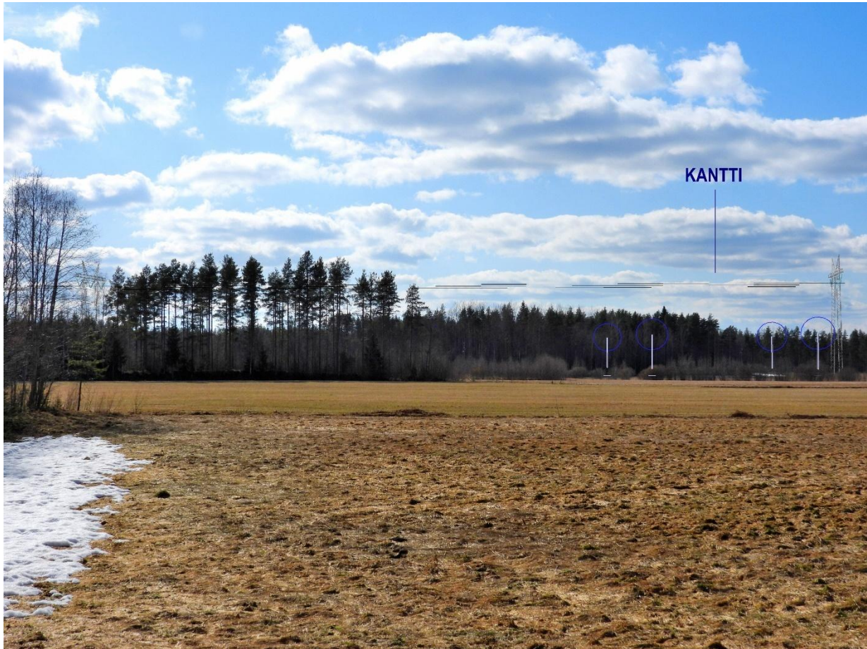
Kuva 145. Kuvauspaikka 16, kuvaan korostettu Kantin voimalat SVE1:n takana.
