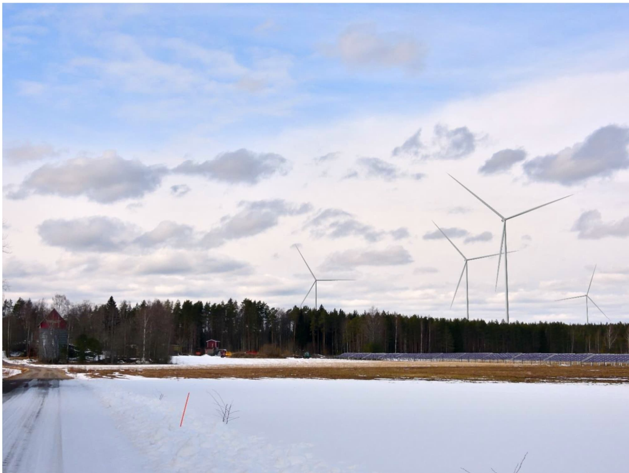
Kuva 22. Kuvaspaikka 6. Aurinkovoimala oikealla, tuulivoimalat taustalla. Lähin tuulivoimala 1,5 km päässä kuvauspiisteestä.
