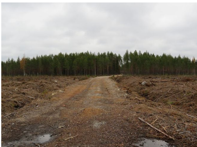
12. Uusi metsäautotie koilliseen.
