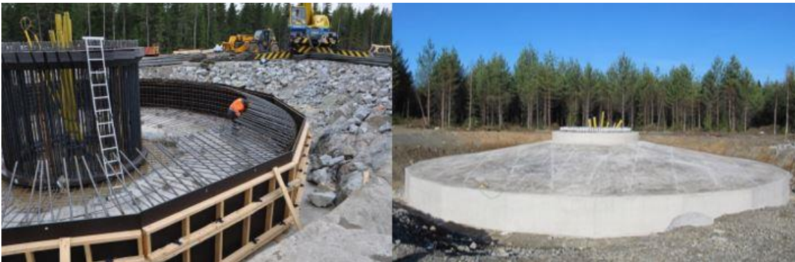
Kuva 9-11. Tuulivoimalan perustusten rakentamista (Leila Väyrynen, FCG).
