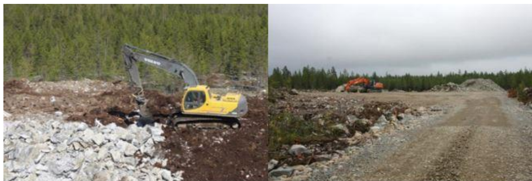
Kuva 9-9. Tuulivoimapuiston rakentaminen alkaa huoltoteiden ja pystytysalueiden rakentamisella (Ville Suorsa, FCG).
