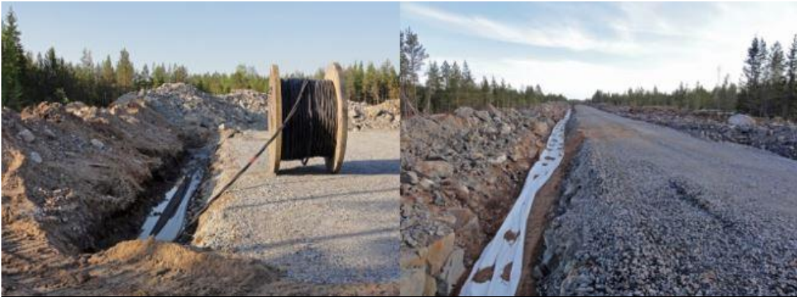
Kuva 9-10. Maakaapelit upotetaan huoltoteiden yhteyteen (Ville Suorsa, FCG).
