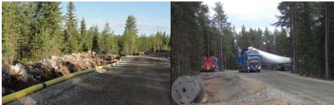
Kuva 9-8. Vasemmalla esimerkki tuulivoimapuiston rakennus- ja huoltotiestä. Teitä käytetään muun muassa betonin, soran ja voimaloiden komponenttien kuljetuksiin sekä tuulivoimapuiston käyttövaiheessa huoltoajoihin. Maakaapeli sijoitetaan ojakaivantoon tien reuna-alueelle. Oikealla tuulivoimalan osia kuljetetaan erikoiskuljetuksina. (Ville Suorsa, FCG).
