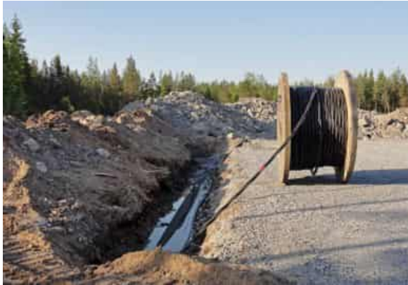
Kuva 4.15 Maakaapelit upotetaan huoltoteiden yhteyteen (FCG Rakennettu ympäristö Oy).
