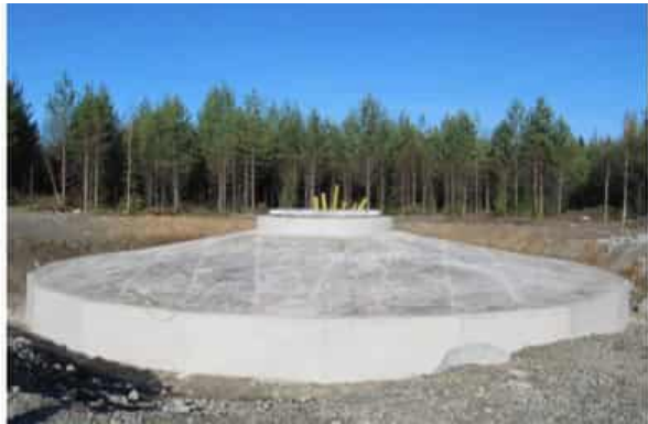
Kuva 4.16 Tuulivoimalan perustusten rakentamista (FCG Rakennettu ympäristö Oy).
