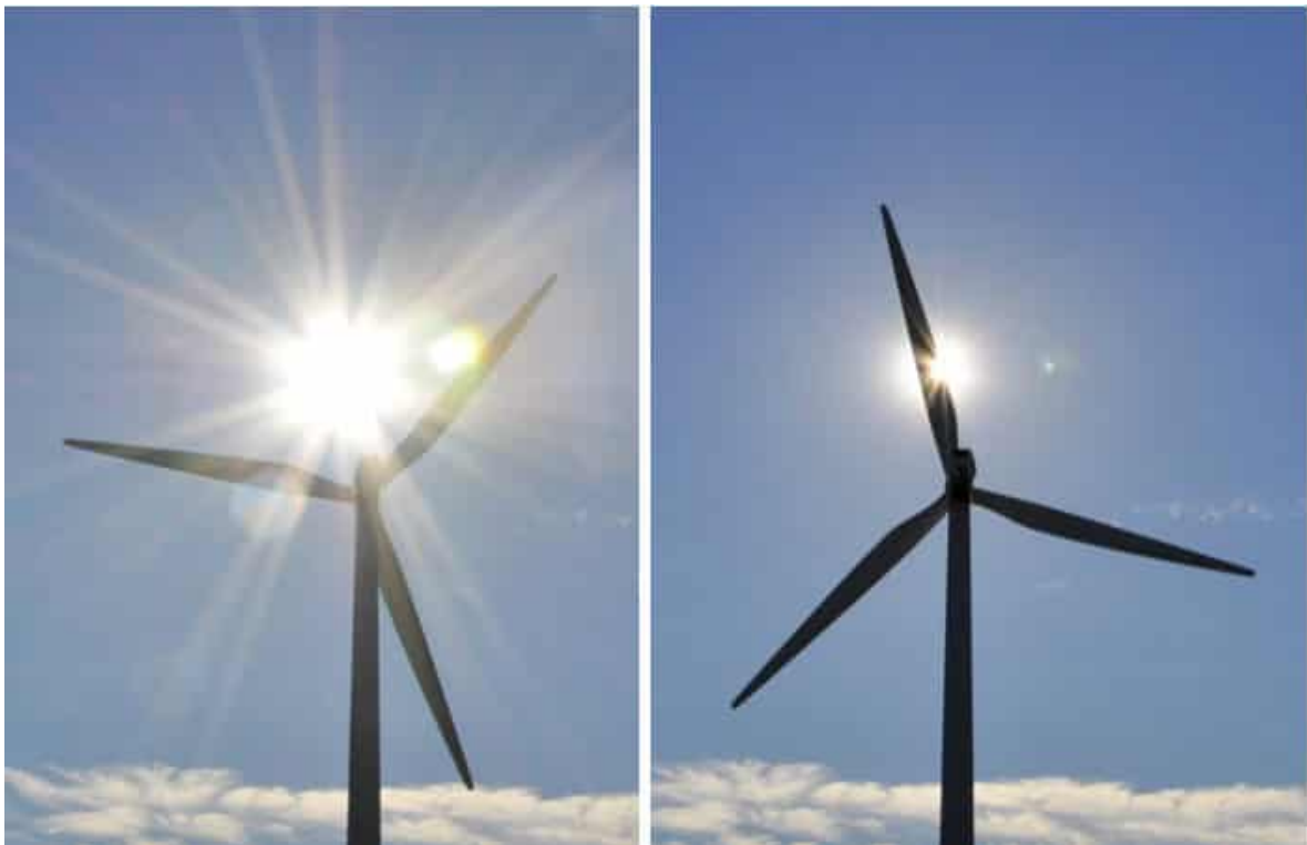
Kuva 20.1 Tuulivoimaloiden lavat aiheuttavat pyöriessään vilkkumista ja varjon välkkymistä aurinkoisella säällä.
