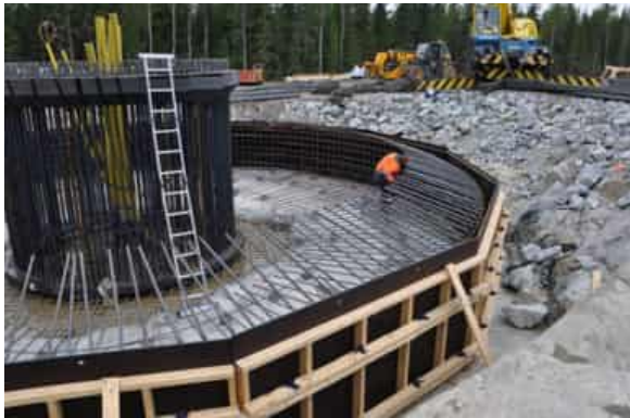
Kuva 4.16 Tuulivoimalan perustusten rakentamista (FCG Rakennettu ympäristö Oy).
