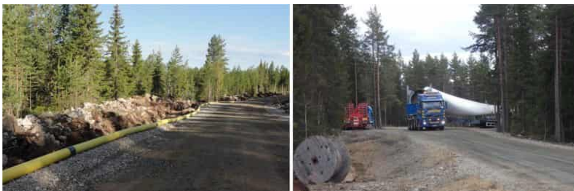
Kuva 4.10 Vasemmalla esimerkki tuulivoima-alueen rakennus- ja huoltotiestä. Oikealla tuulivoimalan osia kuljetetaan erikoiskuljetuksina (FCG Rakennettu ympäristö Oy).
