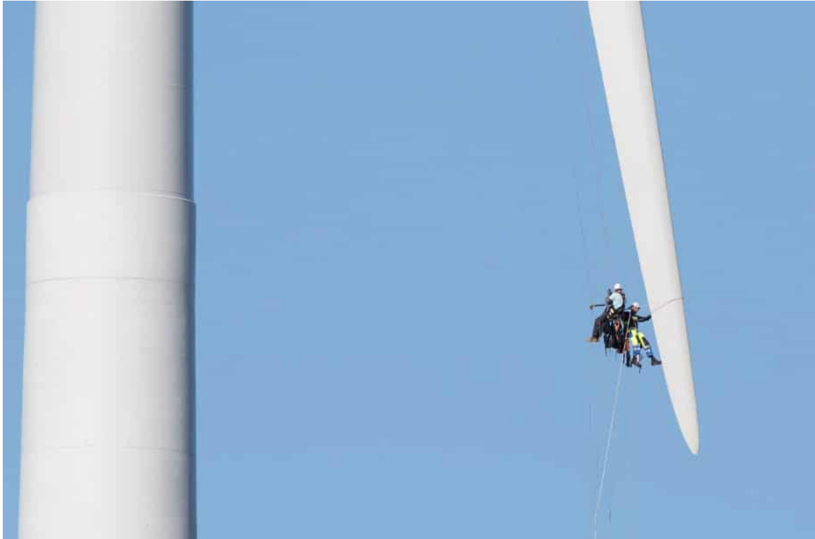
Kuva 4.22 Tuulivoimalan huoltotoimenpiteitä (FCG Rakennettu ympäristö Oy).
