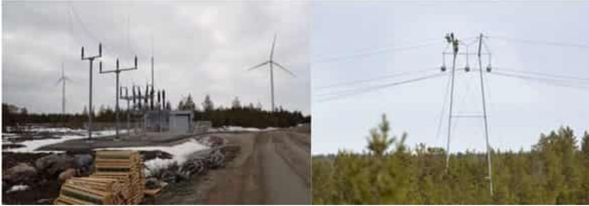
Kuva 4.20 Sähköaseman ja voimajohdon rakentamista (FCG Rakennettu ympäristö Oy).
