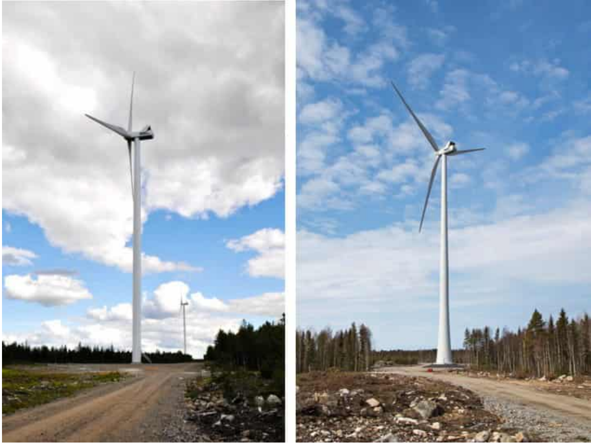
Kuva 4.2 Vasemmalla on esimerkki teräslieriötornista ja oikealla hybriditornista (FCG Rakennettu ympäristö Oy).
