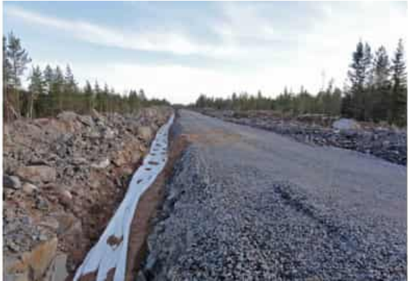
Kuva 4.15 Maakaapelit upotetaan huoltoteiden yhteyteen (FCG Rakennettu ympäristö Oy).
