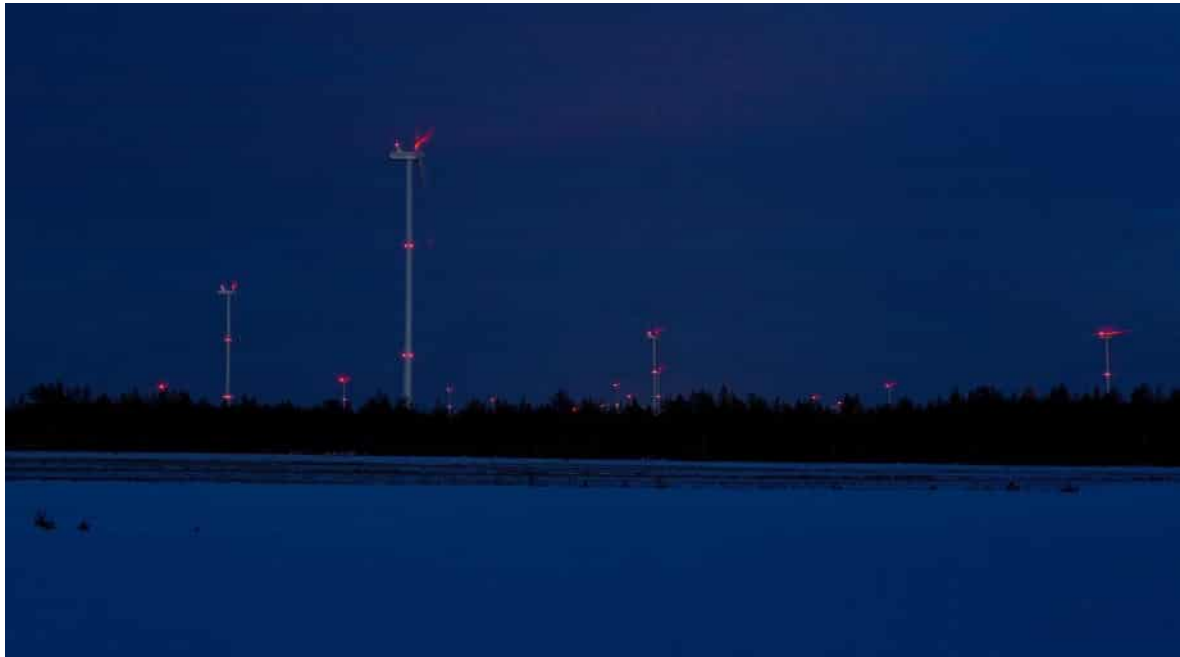
Kuva 4.5 Kiinteät punaiset lentoestevalot (FCG Rakennettu ympäristö Oy).
