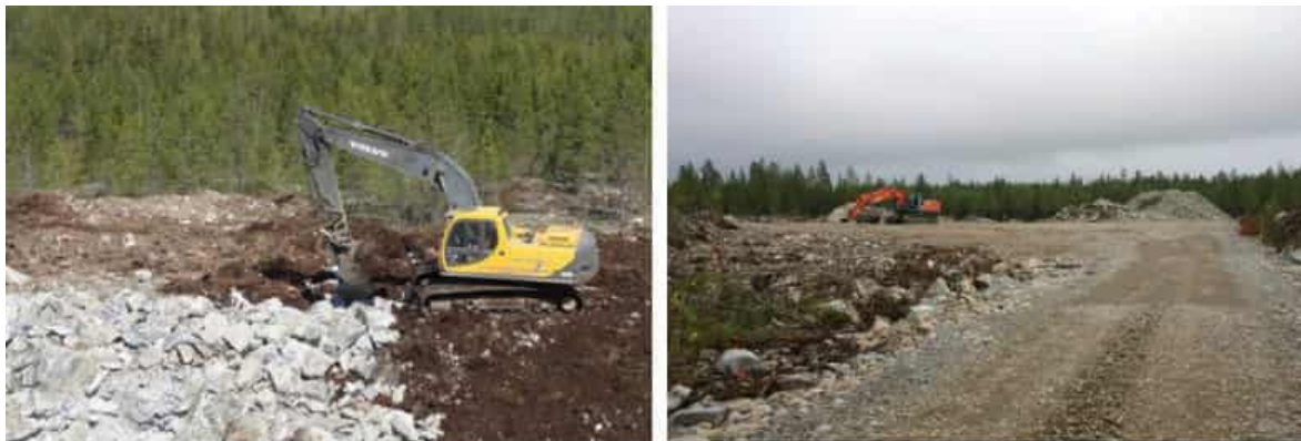
Kuva 4.14 Alueen rakentaminen alkaa huoltoteiden ja tuulivoimaloiden pystytysalueiden rakentamisella (FCG Rakennettu ympäristö Oy).
