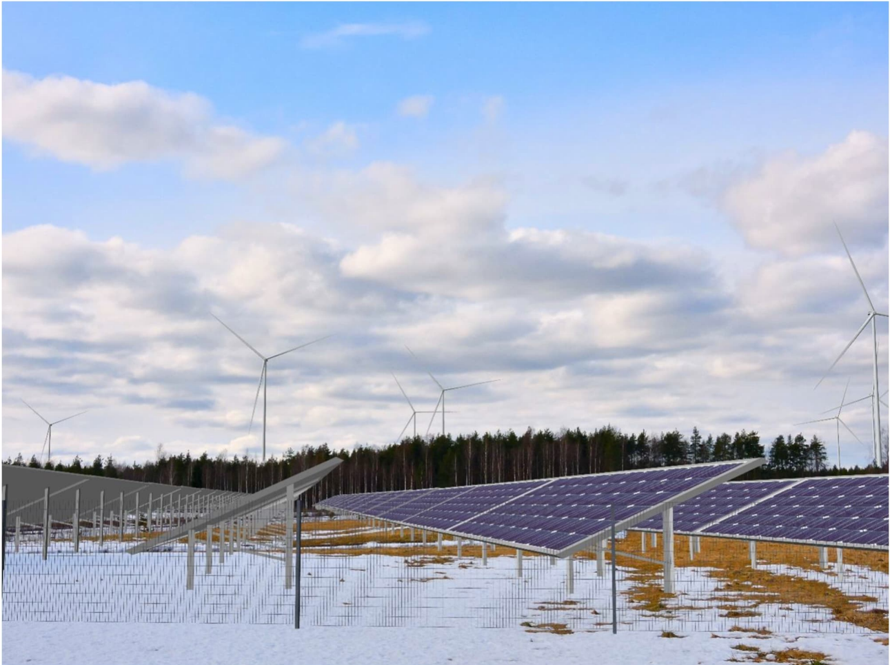
Kuva 20. Kuvauspaikka 5. Etualalla aurinkovoimala, taka-alalla tuulivoimalat.
