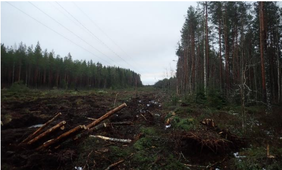
Kuva 49. Pohjoisimman sähkönsiirtoreitin pohjoisosaa Mettälänkylässä. Etelään.
