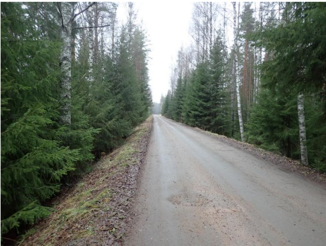
Kuva 42. Vanhaa ratapohjaa, nykyistä Ratapaanantietä. Pohjoiseen.
