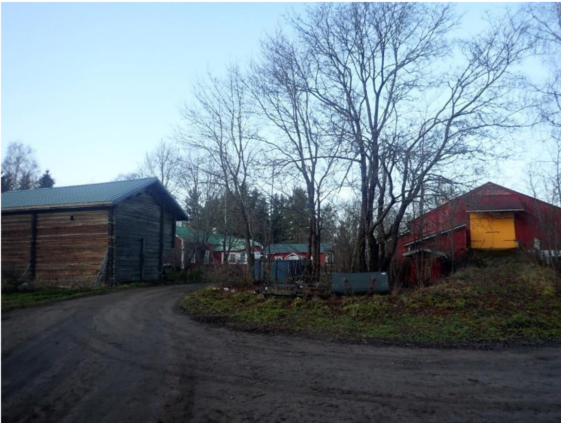
Kuva 8. Joensuun rakennuksia. Pohjoiseen.
