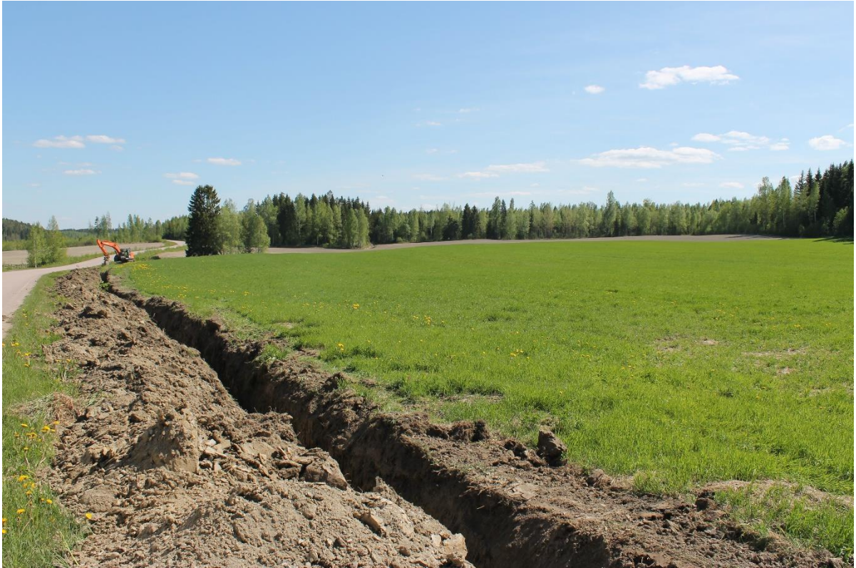
Kuva 6-7. Esimerkkikuva, jossa maakaapelin asentamiseksi kaivettu oja, kun rakennetaan tuulivoimapuiston ulkoista maakaapelia.
