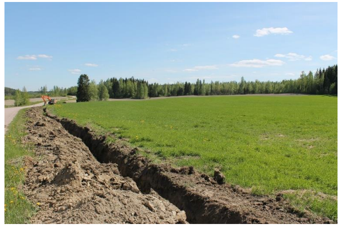
Esimerkkikuva maakaapeliojan kaivuutyöstä. (Kuva: Abo Energy Suomi Oy, Ratiperän tuulivoimapuisto Jämijärvellä).
