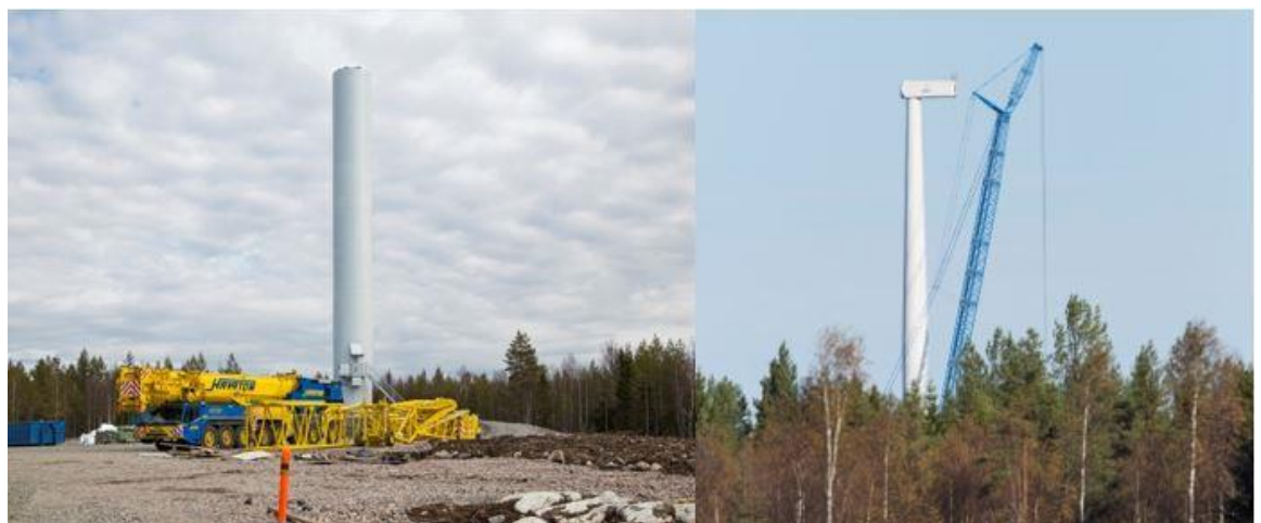
Kuva 9.12. Tuulivoimalan kokoamista (Ville Suorsa, FCG).
