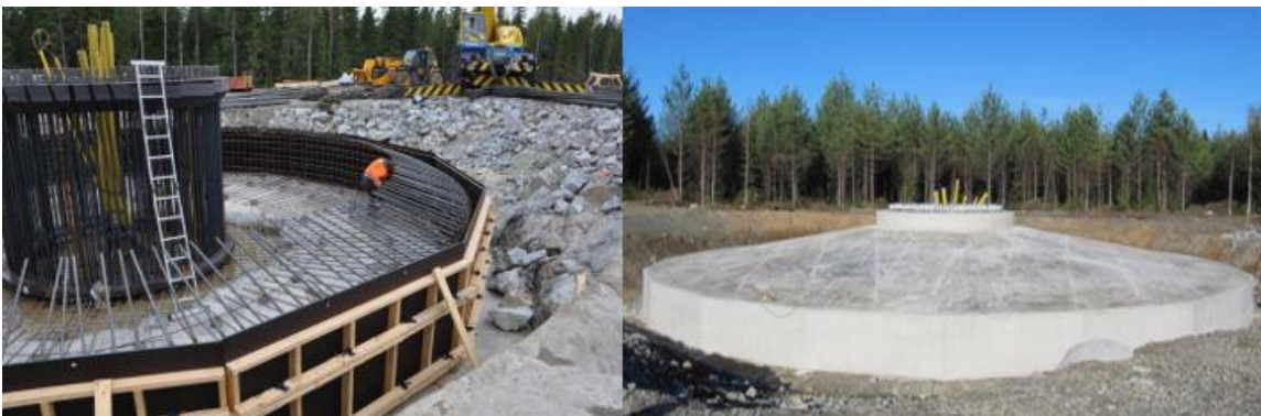
Kuva 9.11. Tuulivoimalan perustusten rakentamista (Leila Väyrynen, FCG).
