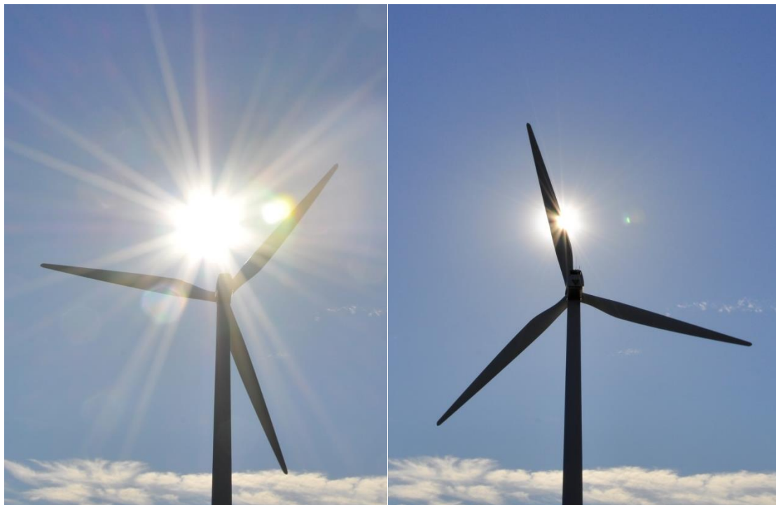
Kuva 8.36 Tuulivoimaloiden lavat aiheuttavat pyöriessään vilkkumista ja varjon välkkymistä aurinkoisella säällä.
