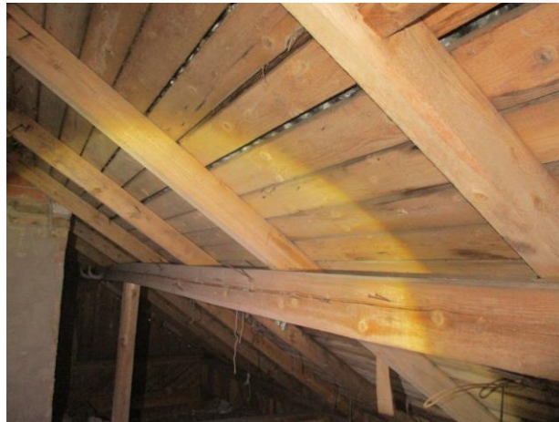
Kuva 4h. Laperakennetta. Aluskatetta ei ole asennettu.
