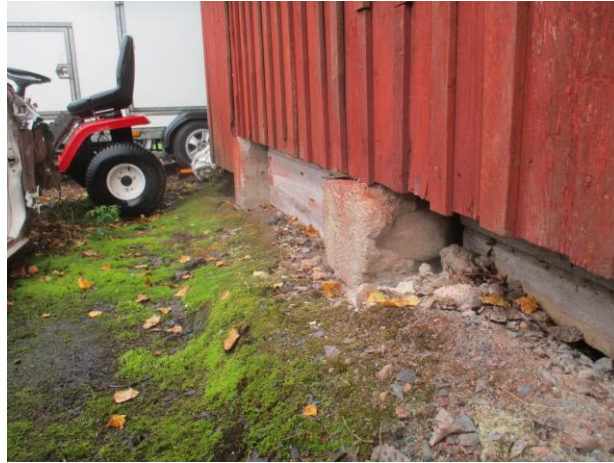
Kuva 1k. Päätty on pilariperusteinen.
