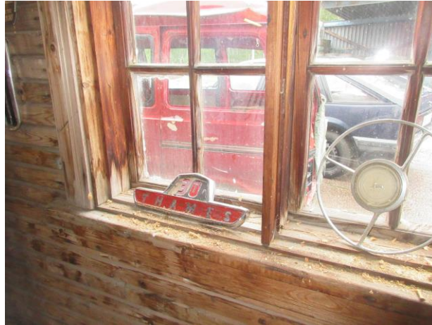
Kuva 3c. Kosteusjälkiä ikkunoissa.
