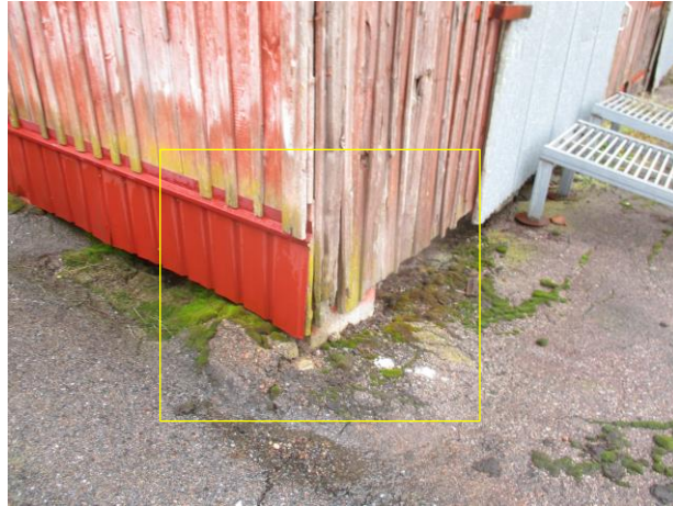
Kuva 1f. Rungon korkoaseman tarkastelua.
