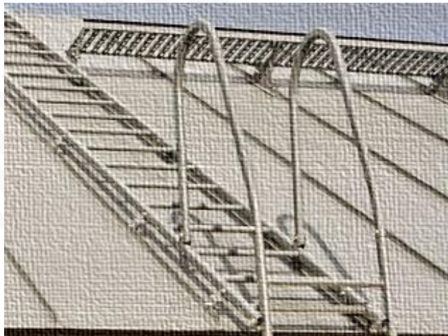
Talotikkaiden ankkurointi rakenteeseen.
