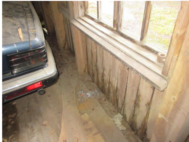
Kuva 2f. Kosteaa verhouslautaa sisäpuolella.
