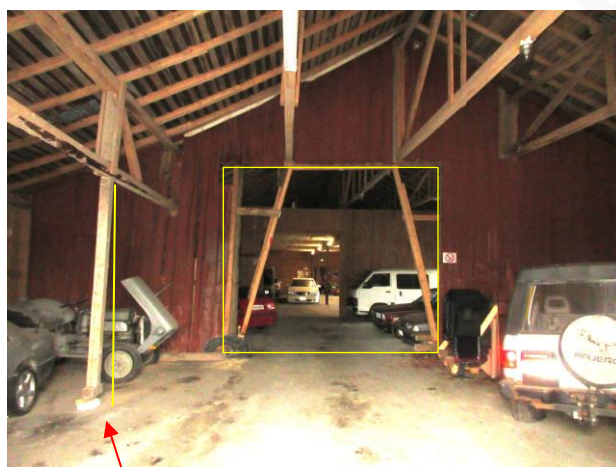
Kuva 1f. Rakennusta on jäykistetty. Viivastolla py- ritään havainnollistaman rakennuksen liikkumi- nen (kallistuma).
