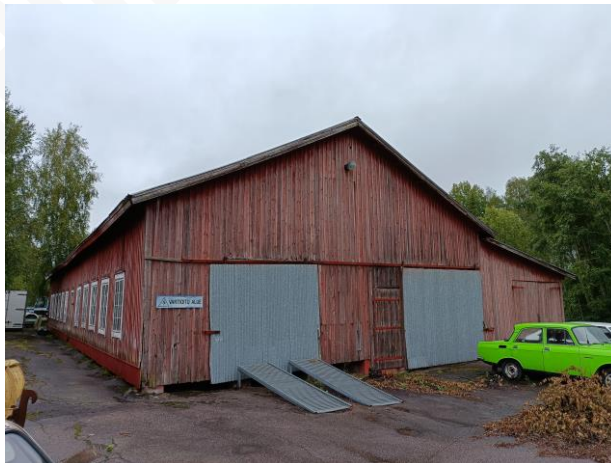
Kuva 3c. Liukuovet päädyssä.
