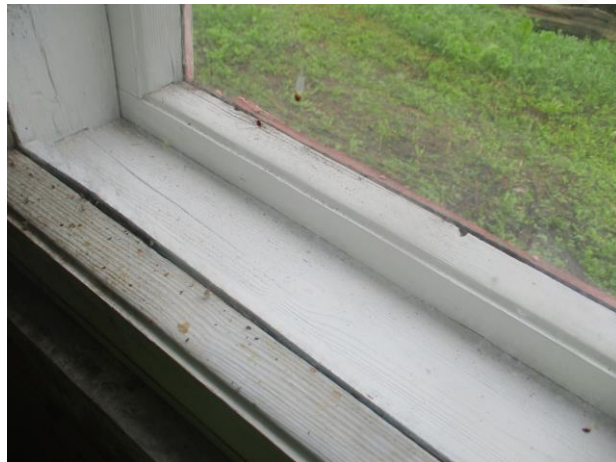
Kuva 3c. Ikkunan välissä ei havaittu huurtumista tarkastushetkellä.
