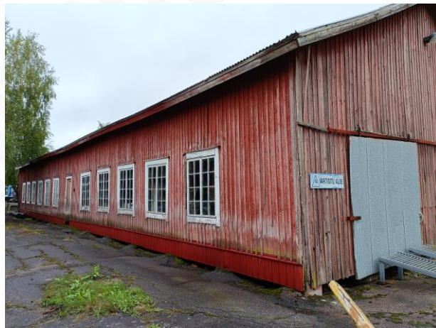
Kuva 1h. Rakennuksen vierustaa.
