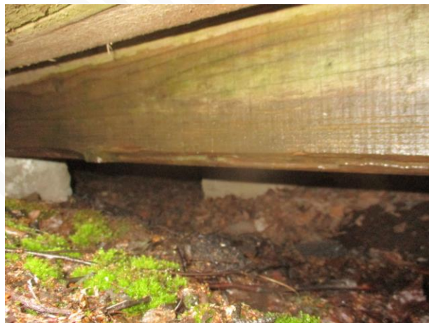
Kuva 1e. Alaside puu märkä, johtuu roiskevedestä.
