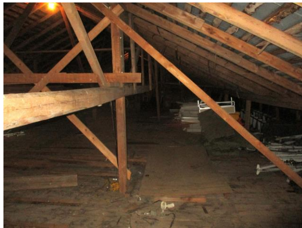
Kuva 4g. Yleiskuvaa yläpohjasta.
