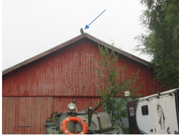
Kuva 4g. Harjapelti on kiinnitettävä.
