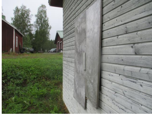
Kuva 3b. Yksittäinen ikkuna on poistettu.
