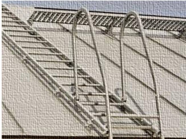
Talotikkaiden ankkurointi rakenteeseen.
