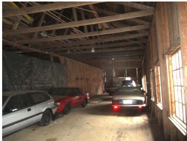
Kuva 1g. Lattia oli kuormasta huolimatta vakaa, eikä resonointia tai taipumia havaittu.
