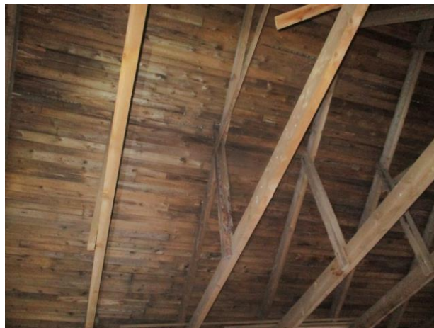
Kuva 4d. Yläpohjarakenteita ja aluslaudoitusta.
