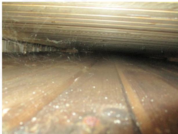
Kuva 5.2d. Panelin takainen ilmarako on riittävä.
