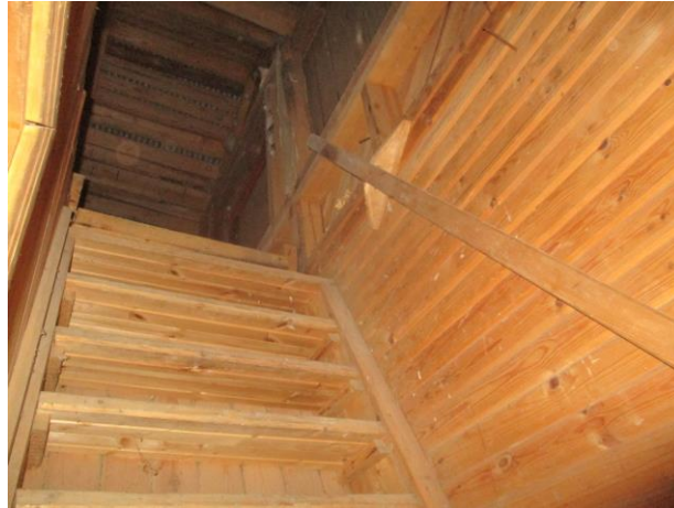
Kuva 6e. Ullakkoportaikko. Käsijohde on asennettu.
