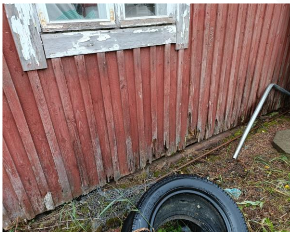
Kuva 2b. Lahoja verhouksen alaosassa.
