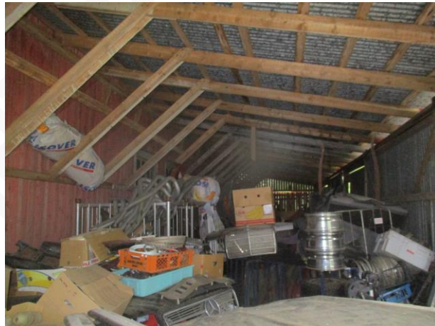
Kuva 4c. Yläpohjarakenteita (ko. tila on havainnon mukaan laajennus).
