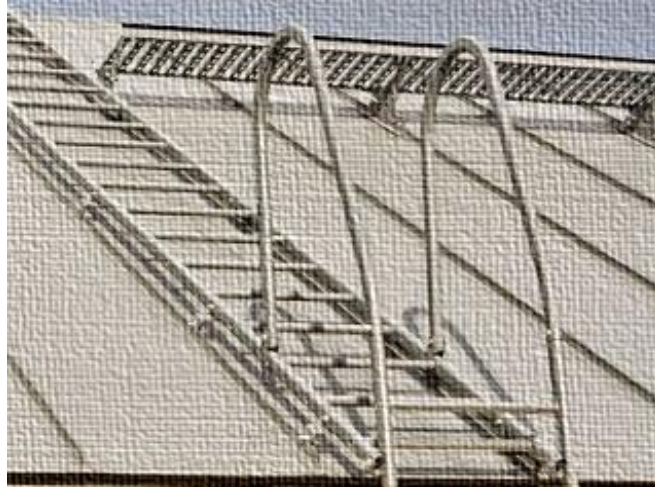
Talotikkaiden ankkurointi rakenteeseen.
