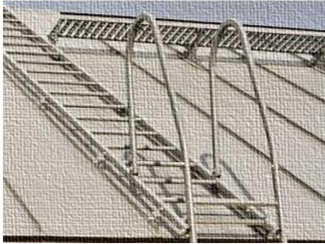
Talotikkaiden ankkurointi rakenteeseen.
