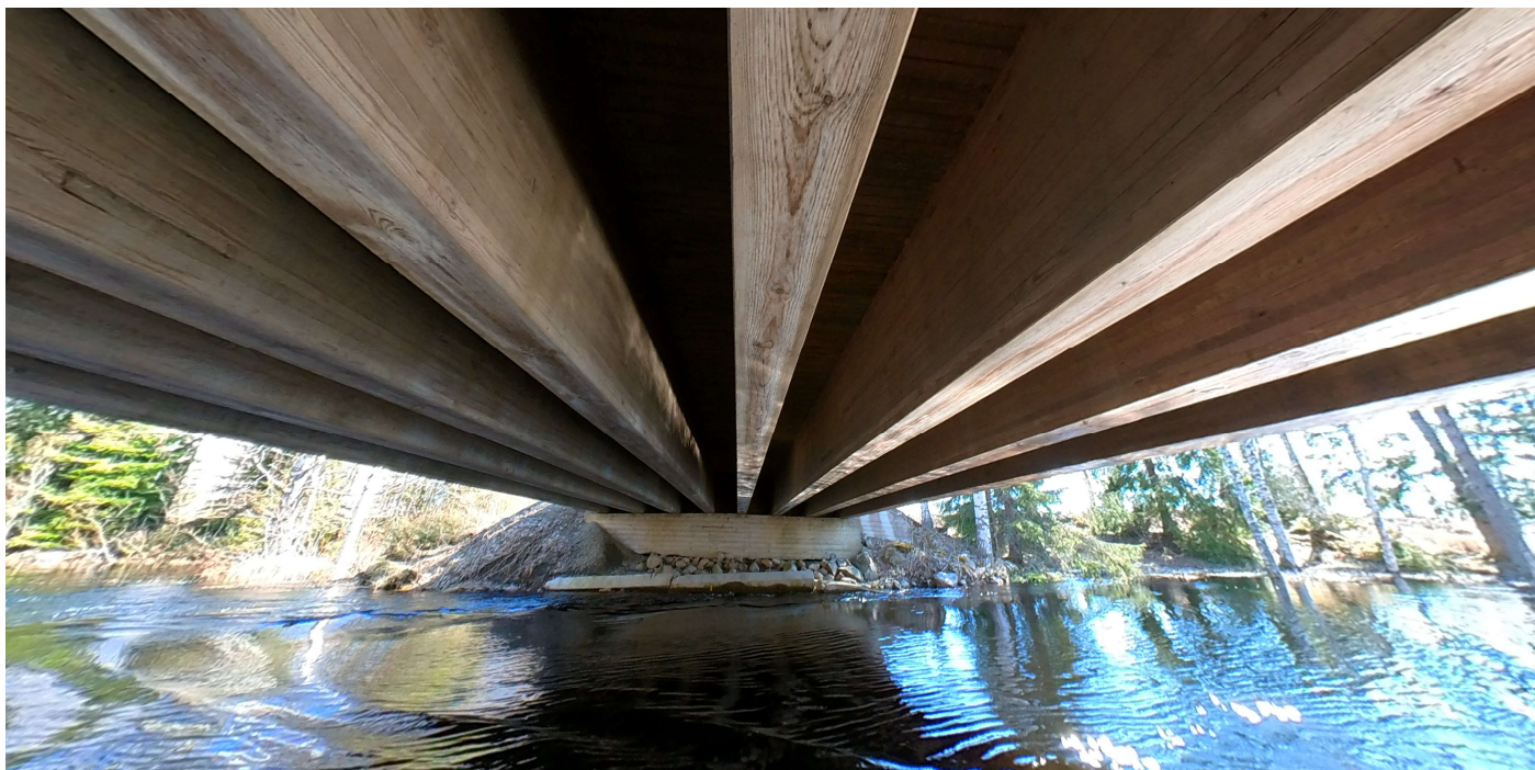
Kuva 14. Sillan kantavat liimapuupalkit, korkeus 910 mm, leveys 210 mm, 8 kpl.
