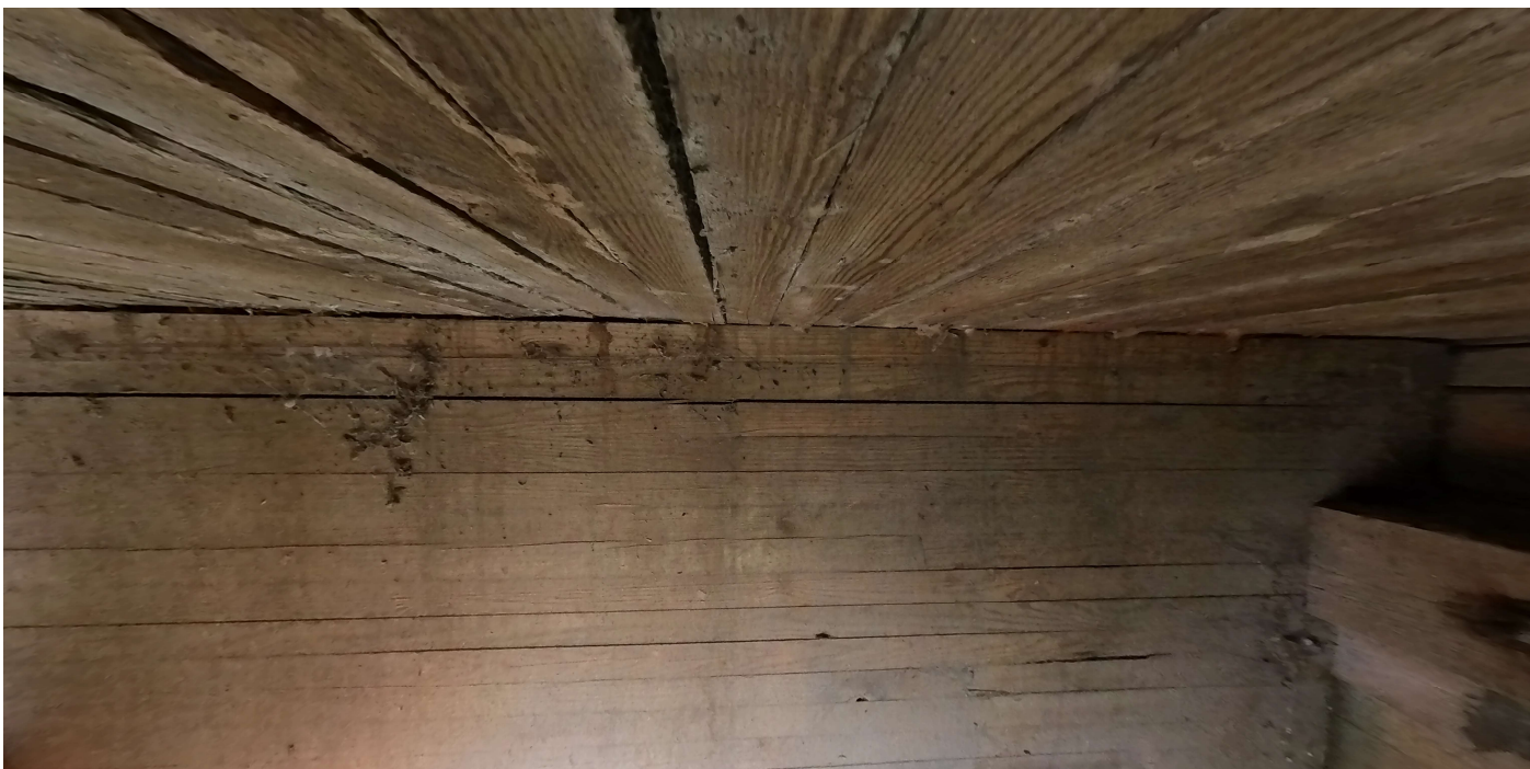
Kuva 18. Halkeamavauriot palkissa
