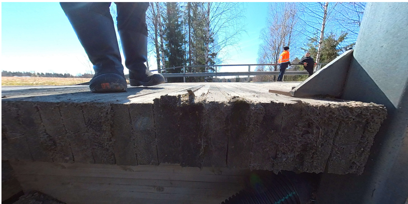
Kuva 15. Syrjälankkukannen lahovaurio.
