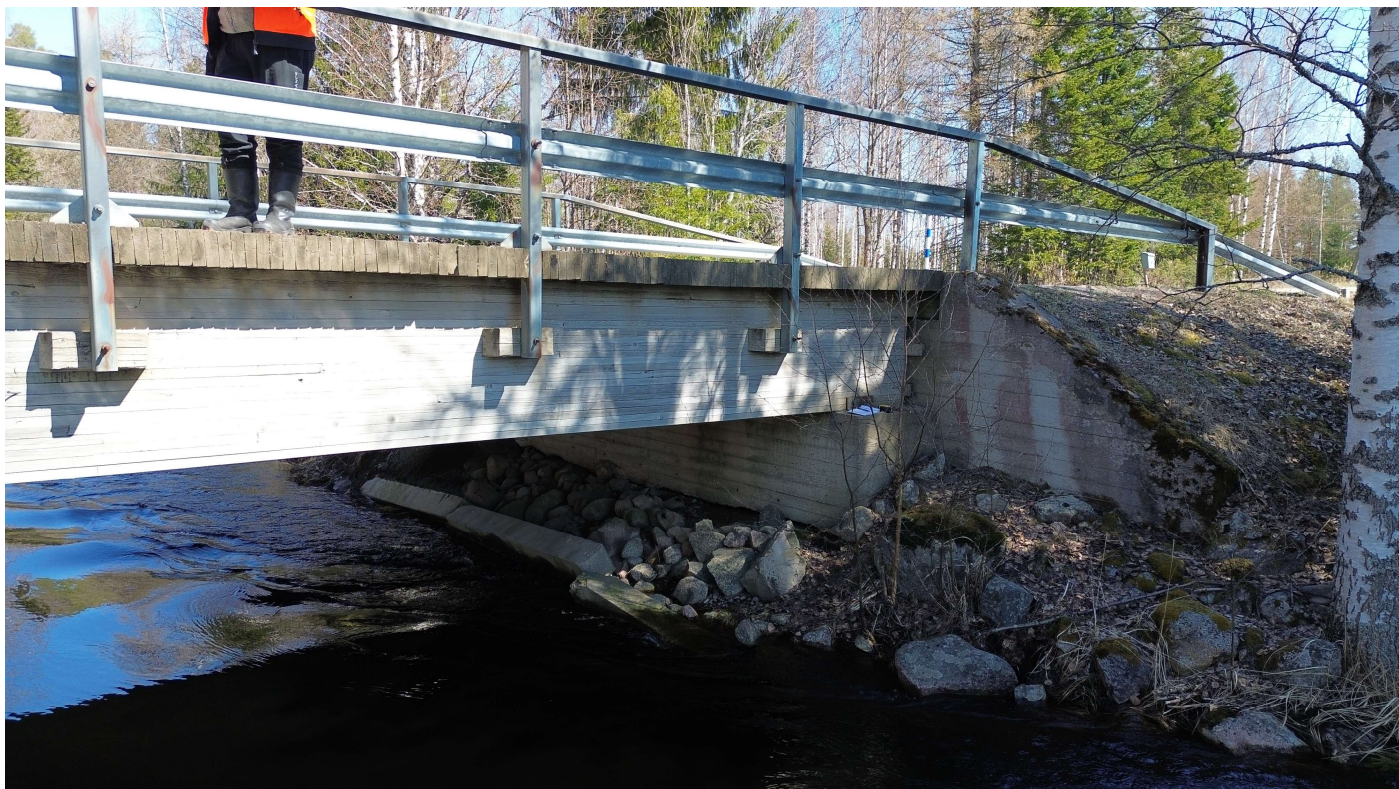
Kuva 10. Betoninen perustus ja maatuki 1.
