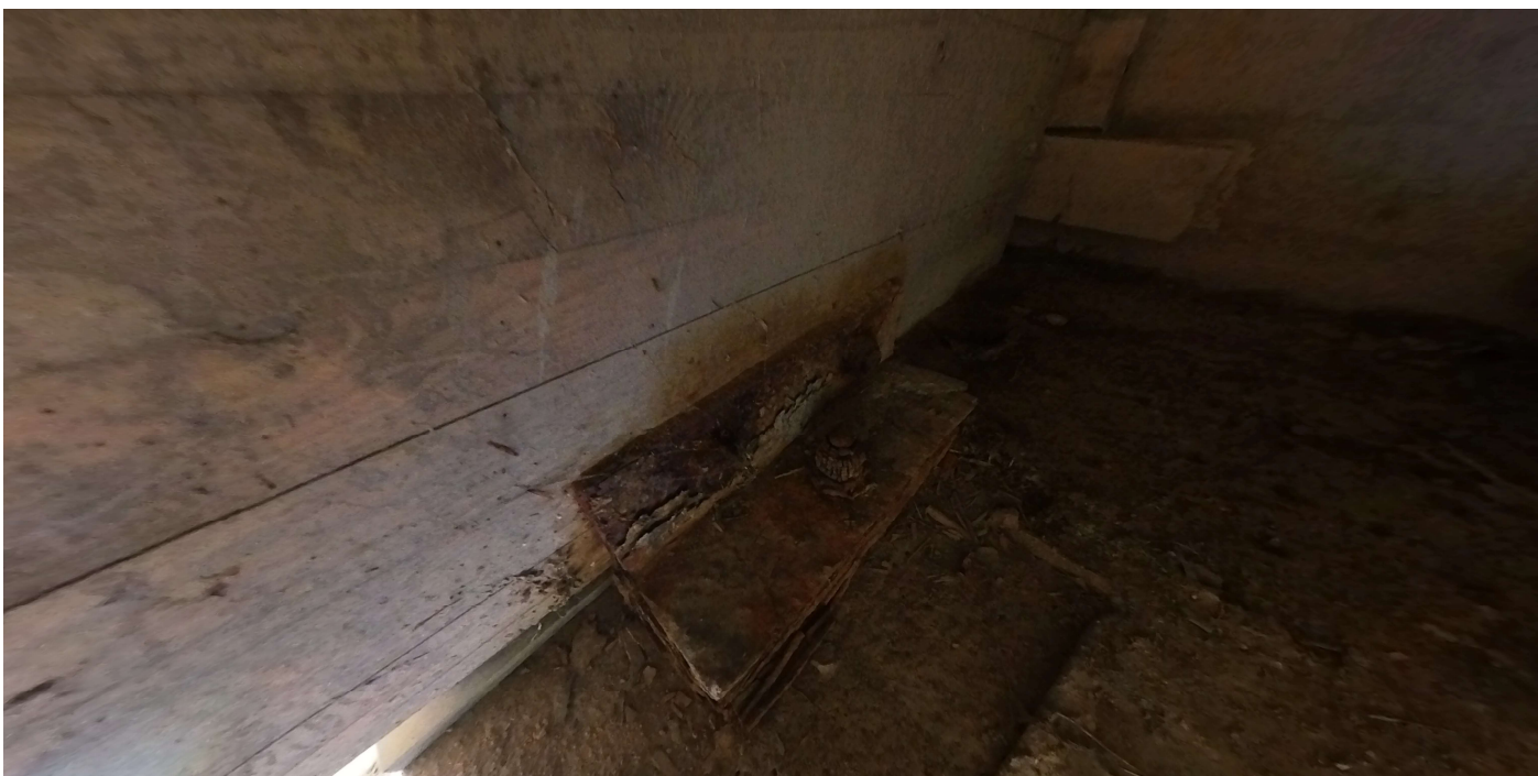
Kuva 19. Lehtiruostetta palkkien kiinnitysraudoissa
