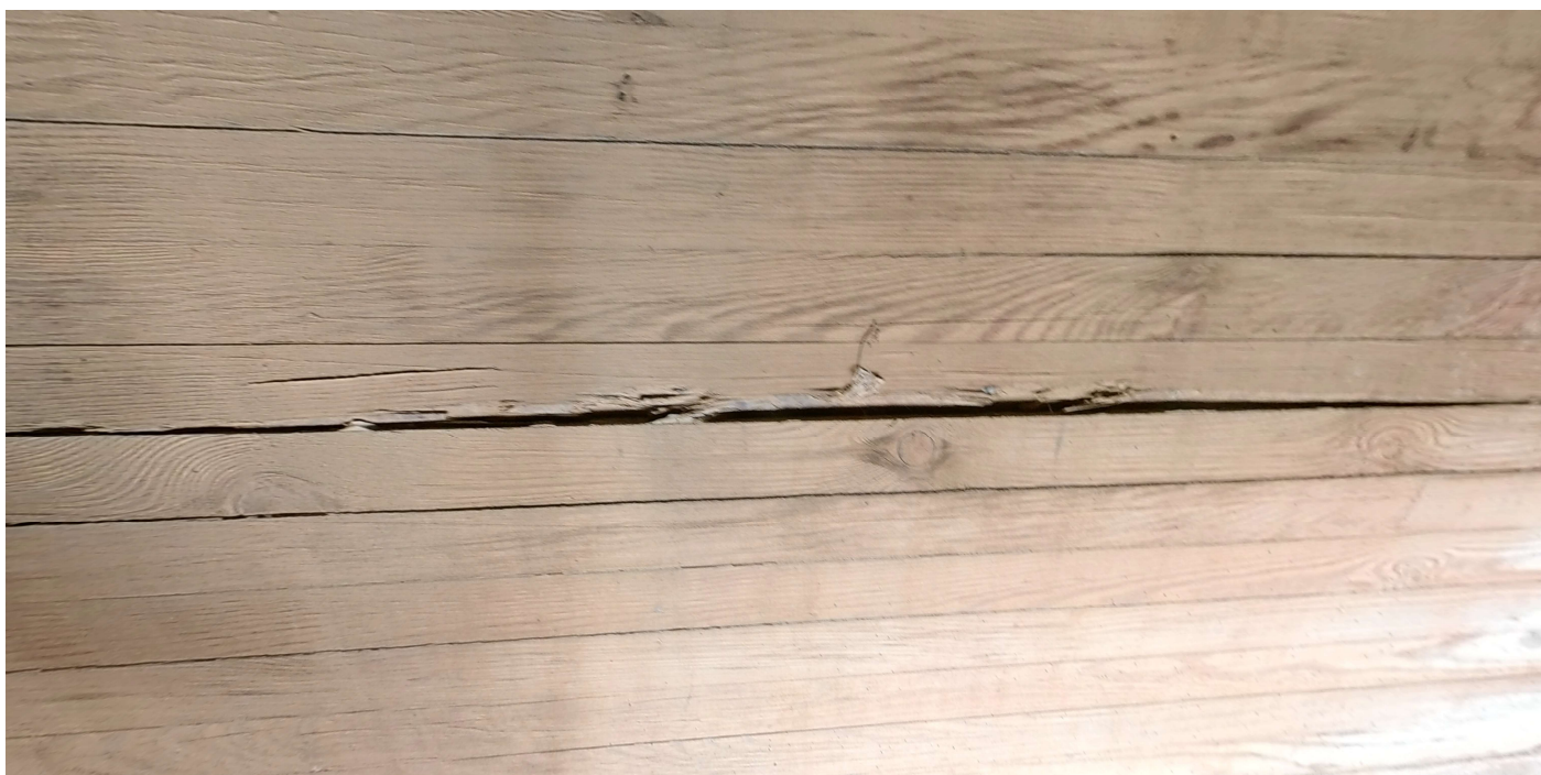
Kuva 17. Liimapuupalkin halkeamavaurio
