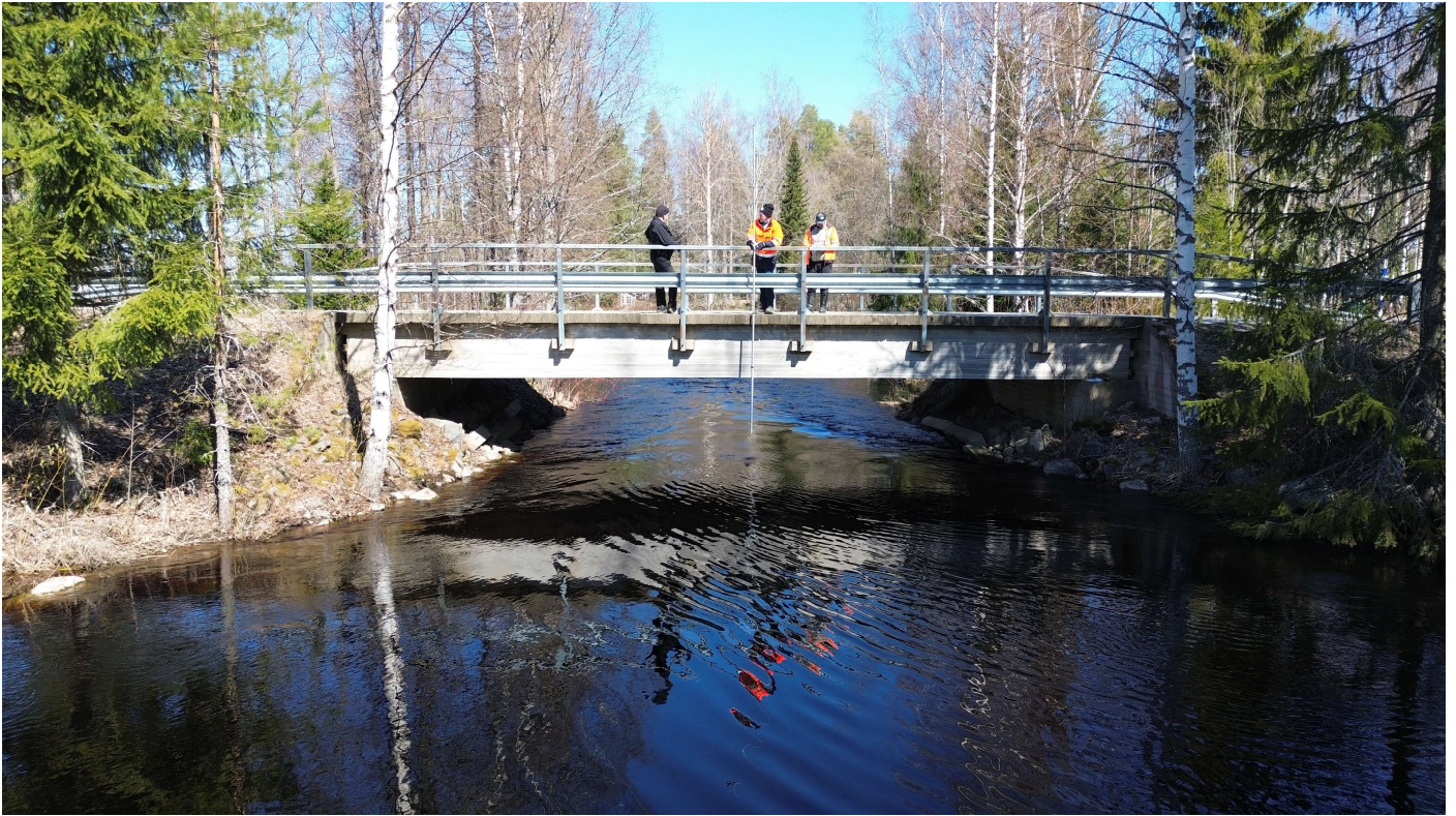
Kuva 8. Yleiskuva sillan sivulta ylävirran puolelta.
