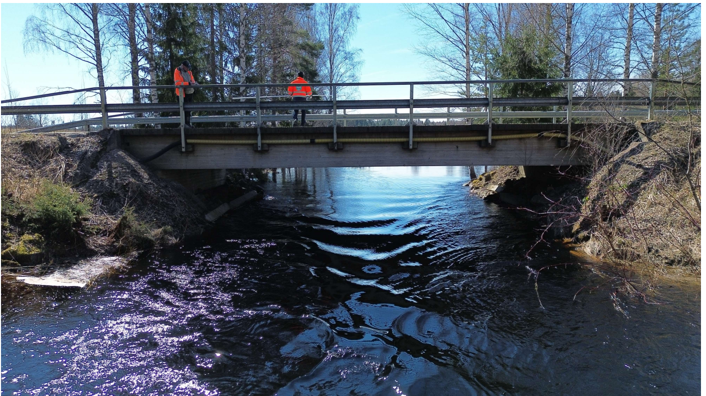
Kuva 9. Yleiskuva sillan sivulta alavirran puolelta.
