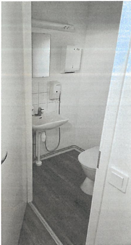
Eteläosan remontoitu wc (vesivahinko n. 2018).
