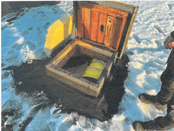
Yläpohjatilien huoltoluukku.
