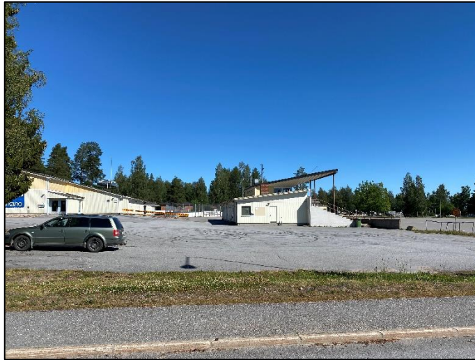
Katsomorakennus Urheilukujalta kuvattuna. Vasemmalla jäähalli.
