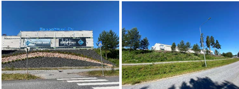
Teollisuus- ja varastorakennuksia kaava-alueen kiinteistöllä 581-5-5090-4.
