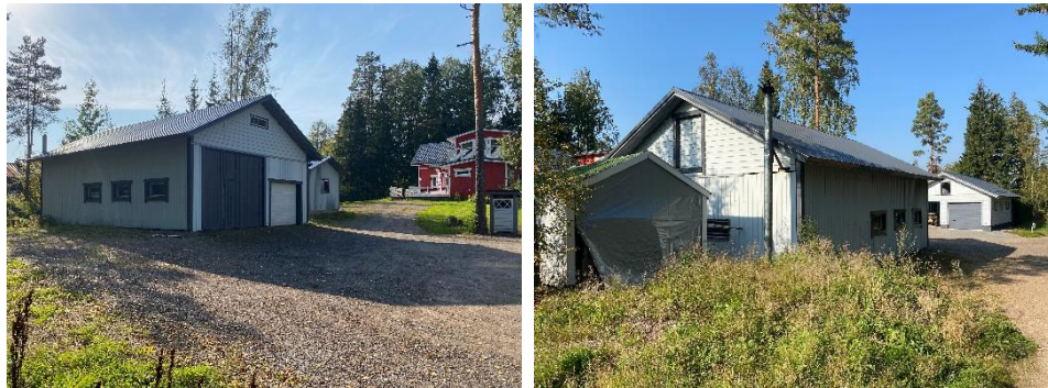
Rakennuksia suunnittelualueen kiinteistöillä 581-4-4025-13 ja 581-4-4025-14.
