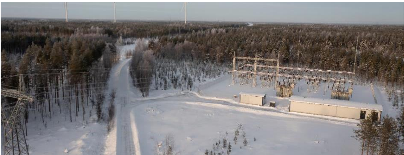
Kuva 17: Sähköasema, kuvituskuva ©FCG
