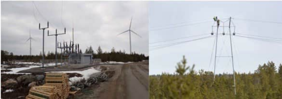
Kuva 5.17 Sähköaseman ja voimajohdon rakentamista (FCG).
