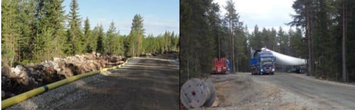
Kuva 5.7 Vasemmalla esimerkki tuulivoimapuiston rakennus- ja huoltotiestä. Oikealla tuulivoimalan osia kuljetetaan erikoiskuljetuksina (FCG).
