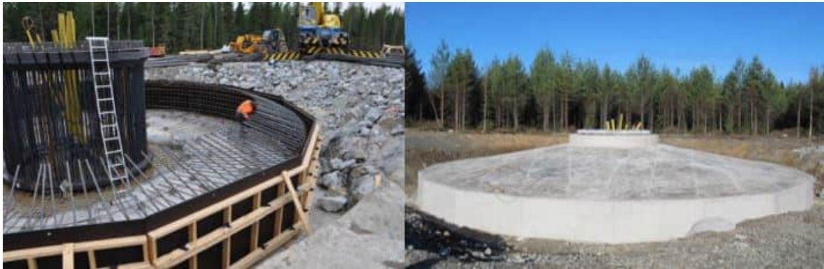
Kuva 5.14 Tuulivoimalan perustusten rakentamista (FCG).
