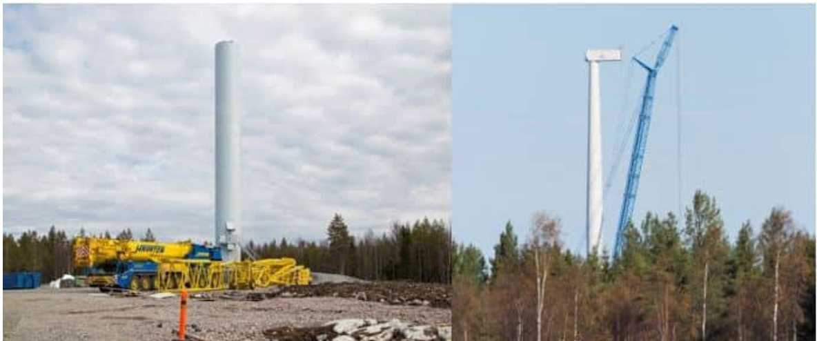
Kuva 5.15 Tuulivoimalan kokoamista (FCG).
