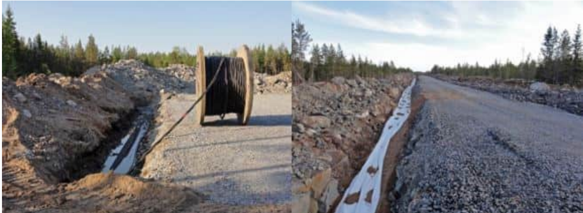
Kuva 5.13 Maakaapelit upotetaan huoltoteiden yhteyteen (FCG).
