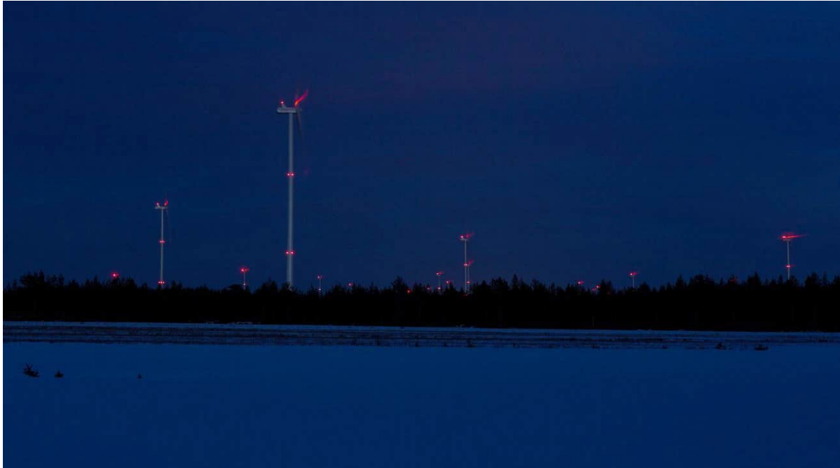
Kuva 5.5 Kiinteät punaiset lentoestevalot (FCG).
