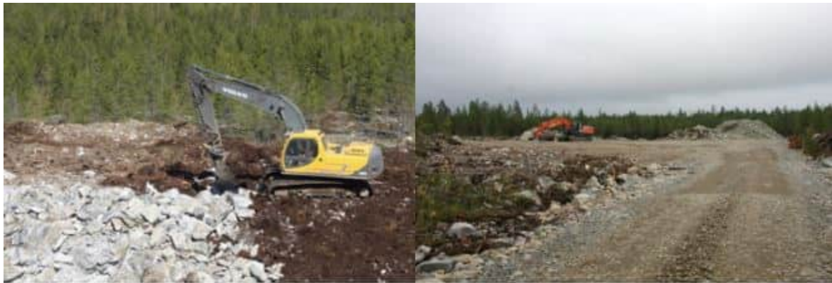
Kuva 5.12 Tuulivoimapuiston rakentaminen alkaa huoltoteiden ja pystytysalueiden rakentamisella (FCG).
