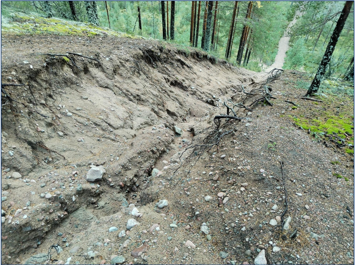
Kuva 2. Vatulanharjun eroosiokouru vuonna 2024.
