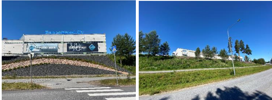
Teollisuus- ja varastorakennuksia kaava-alueen kiinteistöllä 581-5-5090-4.
