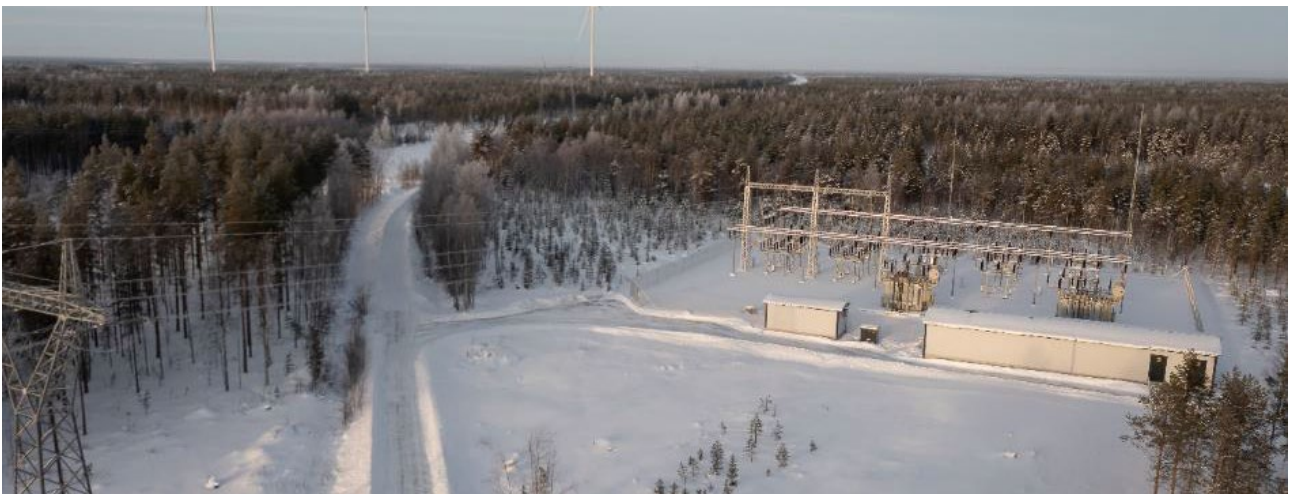
Kuva 17: Sähköasema, kuvituskuva ©FCG
