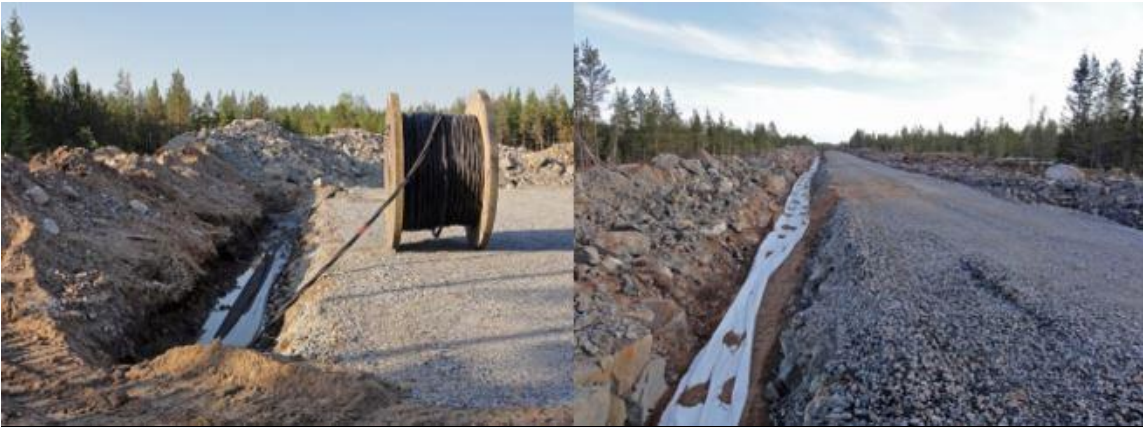
Kuva 9.10. Maakaapelit upotetaan huoltoteiden yhteyteen (Ville Suorsa, FCG).
