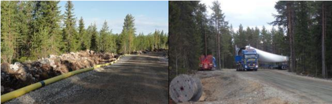
Kuva 9.8. Vasemmalla esimerkki tuulivoimapuiston rakennus- ja huoltotiestä. Teitä käytetään muun muassa betonin, soran ja voimaloiden komponenttien kuljetuksiin sekä tuulivoimapuiston käyttöväheessä huoltoajoihin. Maakaapeli sijoitetaan ojakaivantoon tien reuna-alueelle. Oikealla tuulivoimalan osia kuljetetaan erikoiskuljetuksina. (Ville Suorsa, FCG).
