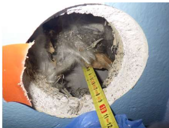
Kuva 81. Rakenneavaus RA-US3. Patterisyvennyksessä on lämmöneristeenä lasivillaa ja lastuvillalevyä, jonka sisäpinnassa on rappaus.
