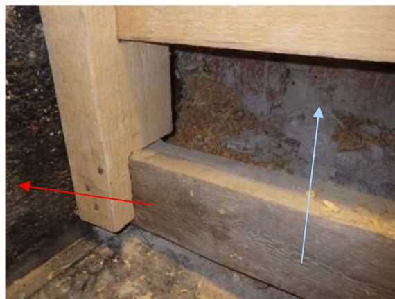
Kuva 167. Rakenneavaus RA-VP14. Alalaattapalkiston ympärillä on bitumisively. Ulkoseinässä ei ole betonista välipohjan sidepalkkia (sininen nuoli).
