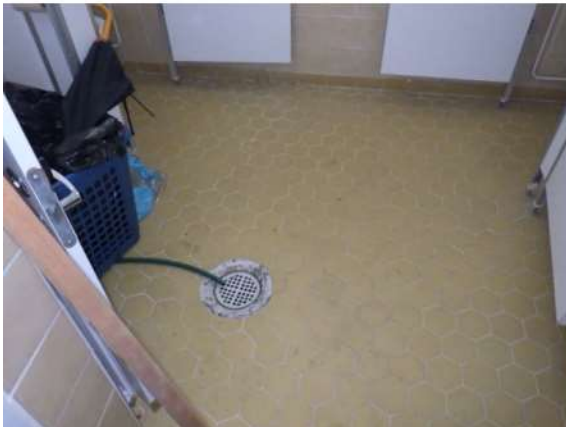
Kuva 192. Kuva tilasta 108, jossa alkuperäinen valurautainen lattiakaivo sekä klinkkerilaatoitus.
