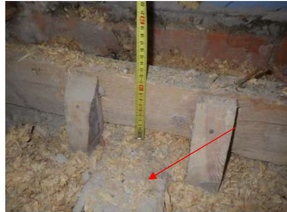
Kuva 169. Rakenneavaus RA-VP9. Alalaattapalkiston palkkien leveys noin 120 mm, joiden päällä noin 120 mm koolaus ja puukansirakenne.
