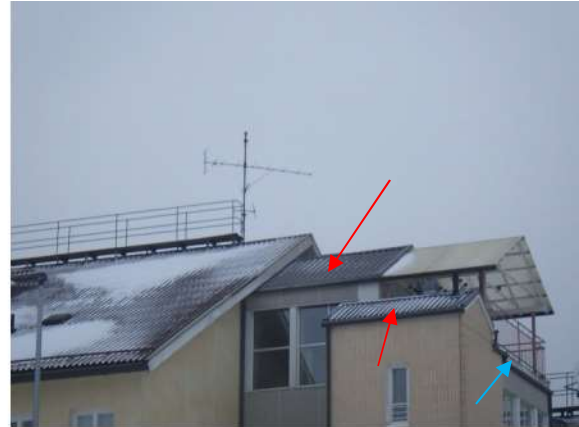
Kuva 253. Punaisella merkitty vuoden 1994 osan profiilipeltikatteet ja sinisellä näköalatasanne.
