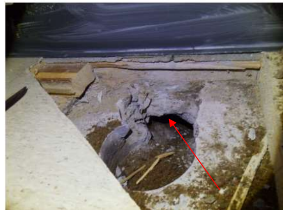
Kuva 31. Rakenneavaus RA-AP2 maanvastaisen seinän liitokseen. Maanvastaisen seinän verhomuuraus on muurattu alapohjan betonilaatan päältä (punainen nuoli).
