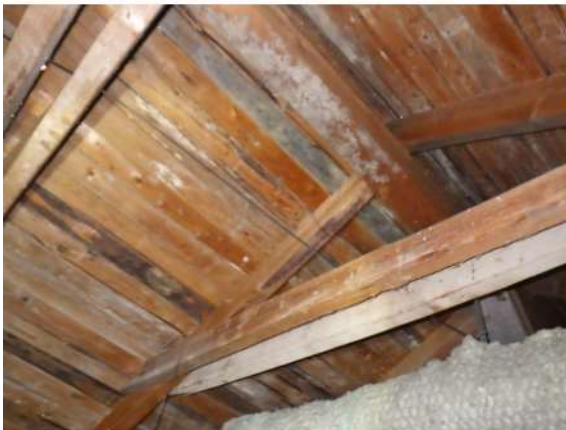
Kuva 263. Alkuperäinen ruodelaudoitus, jonka raot noin 10-20 mm eli k-jako noin k120.
