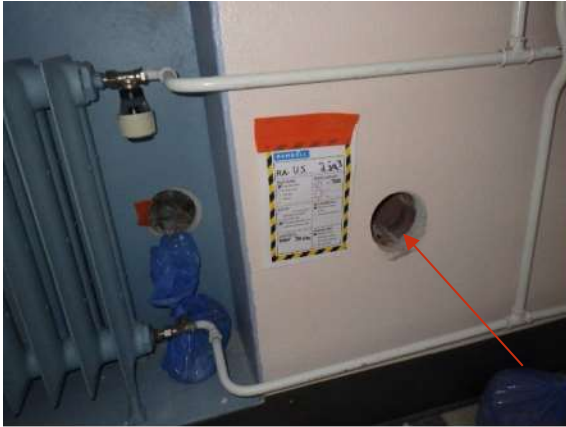
Kuva 76. Rakenneavaus RA-US2 seinän suoralle pinnalle patterisyvennyksen vieressä (punainen nuoli).
