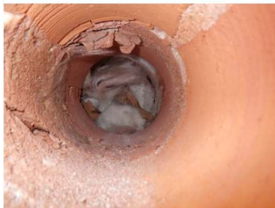
Kuva 83. Rakenneavauskohta RA-US7. Kantavan punatiilirakenteen ja kevytbetonin välissä on noin 50 mm lasivillaa.
