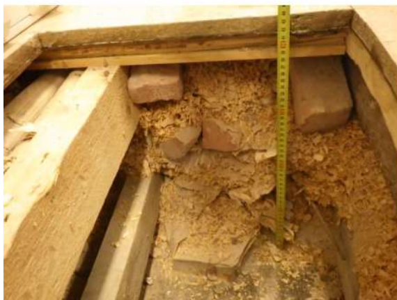
Kuva 166. Täyttökerroksena kutterinlastun lisäksi tiilenpalasia ja hiekkaa.
