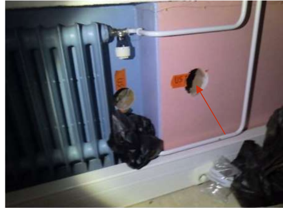
Kuva 95. Rakenneavaus RA-US6. Kuvassa myös patterisyvennyksen rakenneavaus RA-US10.
