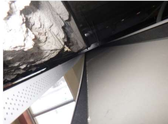
Kuva 124. Liitoskohdassa ei havaittu ulkoseinän US1 epäpuhtauslähteitä.
