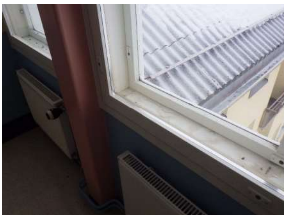
Kuva 135. Vuoden 1994 laajennusosan ikkunat ovat MSE-ikkunoita vuodelta 1994.
