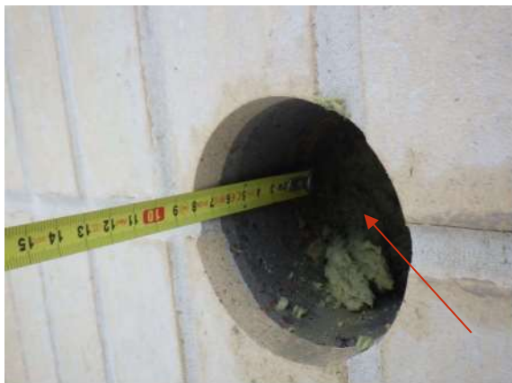
Kuva 107. Rakenneseinän RA-US13 Ulko-kuoren kokonaispaksuus noin 80 mm, josta tiililaatta noin 20 mm.
