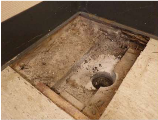
Kuva 28. Rakenneavaus RA-AP1 tilassa 007 väliseinän ja maanvastaisen seinän liitokseen.
