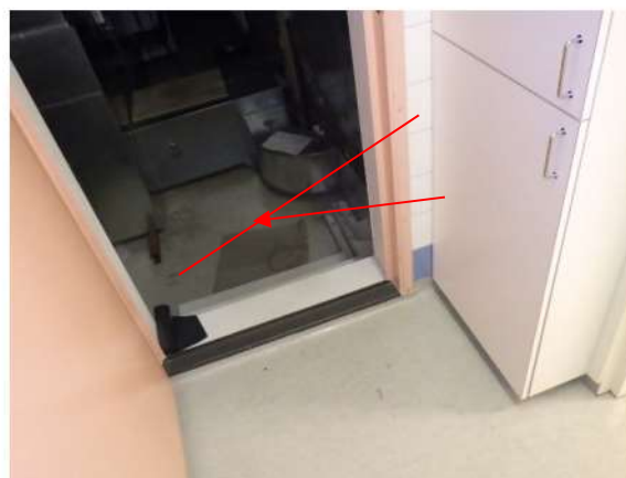
Kuva 207. Kuva tilaan 506, jossa IV-konehuoneen lattia vanhan kouluosan yläpohjan päällä.
