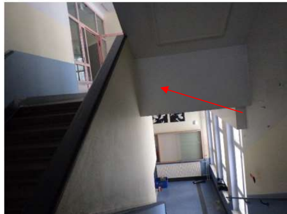
Kuva 211. Kouluosan porrastasanne on aistienvaraisten havaintojen perusteella alalaattapalkkistoa.
