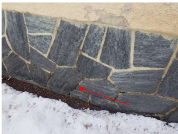
Kuva 68. Liuskekivien saumoissa on pitkälle edennyttä ja laaja-alaista rapautumaa ja liuskekiviä on monin paikoin irti tai ne ovat kopona.
