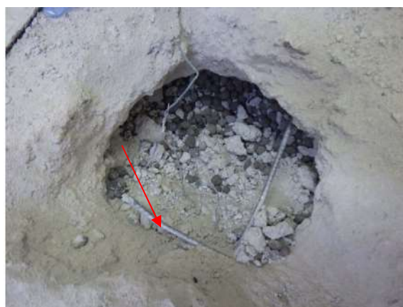
Kuva 204. Uusi pintabetonilaatta ja harjateräsrudoitus. Rakenneavauskohdassa kevytbetonin lisäksi paikallisesti kevytsoraa.
