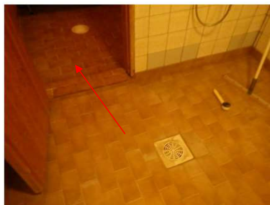
Kuva 37. Kuva tiloista 021 ja 022. Lattia-kaivoja on uusittu muovikaivoiksi.
