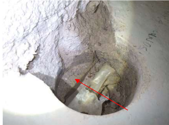
Kuva 39. Rakenneavaus RA-AP9. Teräs-betonilaatat on valettu maanvastaisen seinän anturan päälle. Alla muovikalvo.
