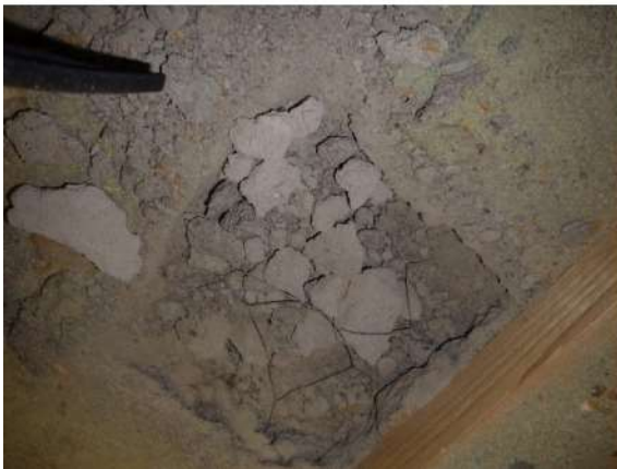
Kuva 202. Alkuperäinen yläpohjarakenne mineraalivillan alapuolella.
