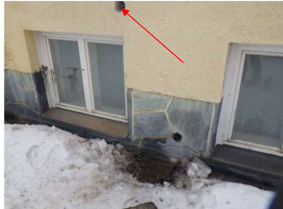
Kuva 85. Rakenneavaus RA-US4 välipohjan kuormantasauspalkin kohdalle.
