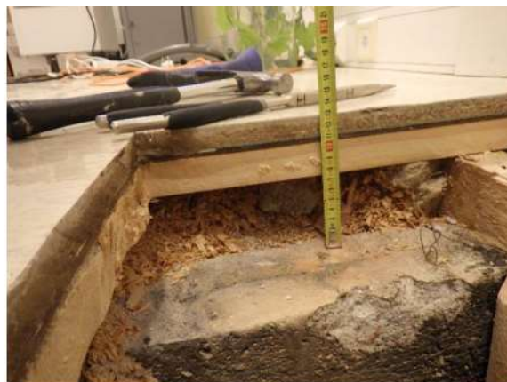
Kuva 165. Rakenneavaus RA-VP14. Alalaattapalkiston päällä noin 70 mm koolaus, kutterinlastu ja pintarakennekerrokset.
