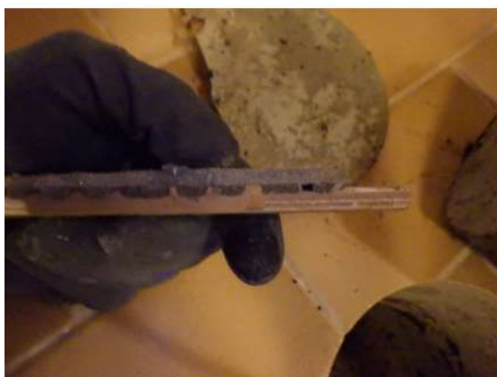
Kuva 36. Rakenneavaus RA-AP7. Vanhan betonimaalin päälle on tehty tasoitekerros sekä keraaminen laatoitus.
