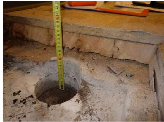
Kuva 29. Rakenneavaus RA-AP1 tilassa 007. Alkuperäisen puulattian päälle on tehty lastulevytys ja muovimatto.
