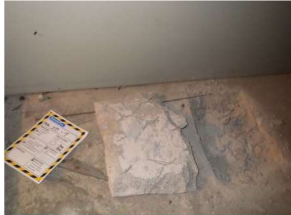
Kuva 222. Rakennuskohta RA-YP1. Lämönneristeenä kevytbetonia 150 mm.
