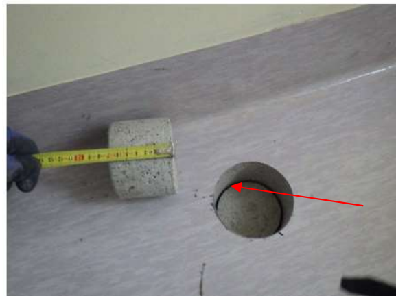
Kuva 180. Rakenneavaus RA-VP11 WC-tiilissä, jossa rakenne vastaa kuivan tilan rakennetta.
