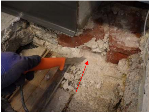
Kuva 84. Rakenneavauskohta RA-VP18. Välipohjan kohdalla ulkoseinässä betoninen kuormantasauspalkki (punainen nuoli).
