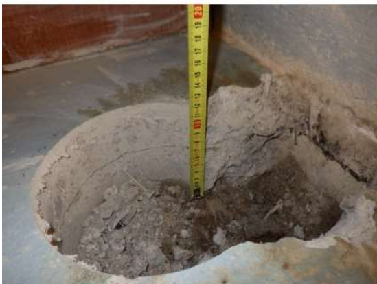
Kuva 25. Rakenneavaus RA-AP5 tilassa 032. Alapohjalaatta valettu kantavaa väliseinää vasten.
