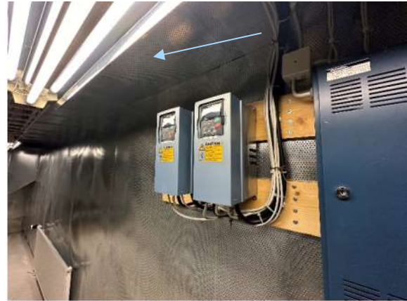
Kuva 249. IV-konehuoneen sisäkattopinna reikäpelti ja ääneneristys.
