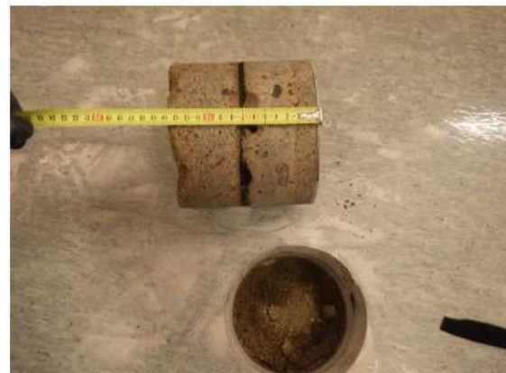
Kuva 26. Rakenneavaus RA-AP8 tilassa 018. Täyttökerroksena hieno hiekka, joka on kapillaarista.
