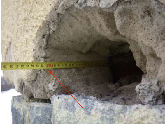
Kuva 94. Rakennuksen päädyssä valmiina ollut rakenneavaus RA-US9. Kevytbetonin vahvuus noin 200 mm.
