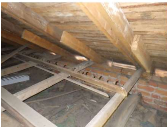
Kuva 265. Kouluosalla räystäällä on arviolta riittävä tuuletusrako. Vesikaton puurakenteita on vahvistettu.
