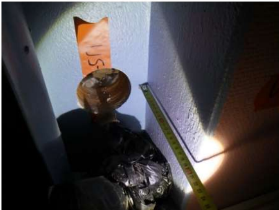
Kuva 96. Rakenneavauskohta RA-US10. Patterisyvennyksen syvyys noin 170 mm
