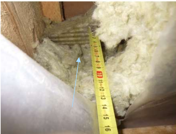
Kuva 246. Rakenneavauskohta RA-YP3. Rakenne on mineraalivillaeristetty puurankarakenne.
