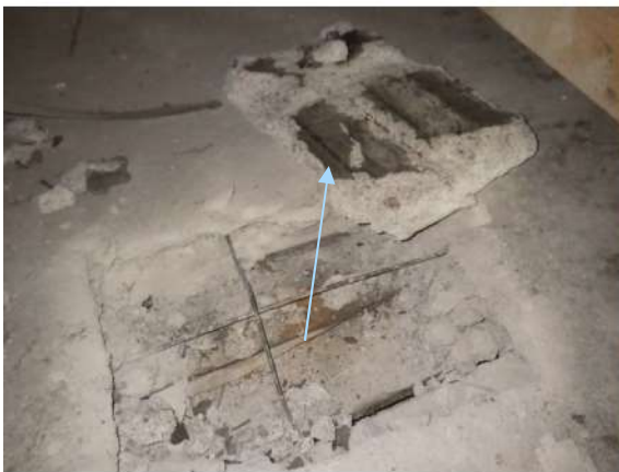
Kuva 231. Rakenneavauskohta RA-YP2. Korppubetonin alla tervapaperi.
