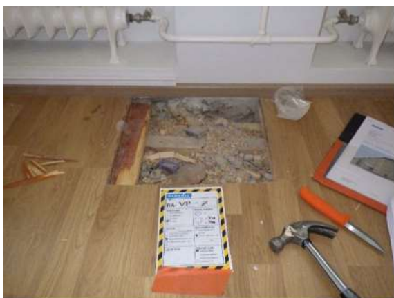
Kuva 160. Rakenneavaus RA-VP7 tilassa 323, jossa alkuperäisen rakenteen päälle on tehty laminaattilattia.
