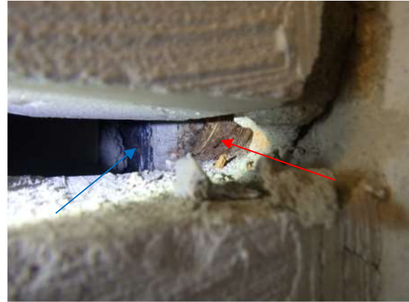
Kuva 66. Umpeen muuratun aukon il-mavälissä on näkyvissä vanhat ikkunari-veet sekä maanvastaisen seinän bitumi-sively.
