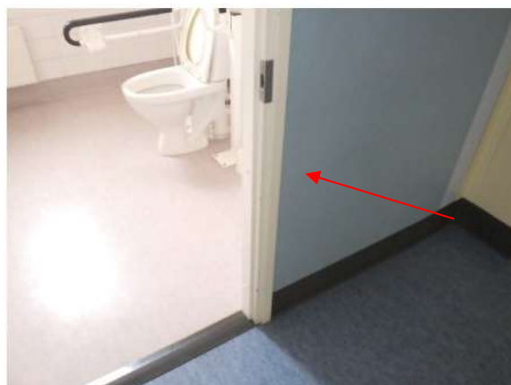
Kuva 219. Vuoden 1994 laajennuksen kalkkihiekkatiilimuurattua väliseiniä.
