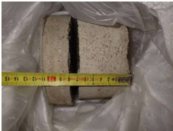
Kuva 188. Rakenneavaus RA-VP12 asunto-osalla tilassa 132. Pintalaatassa on alkuperäinen bituminen vedeneriste.
