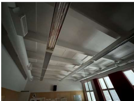
Kuva 186. Ylälaattapalkisto alapuolelta. Alapinnassa akustiikkalevyjä, valaisimia ja IV-putkia.
