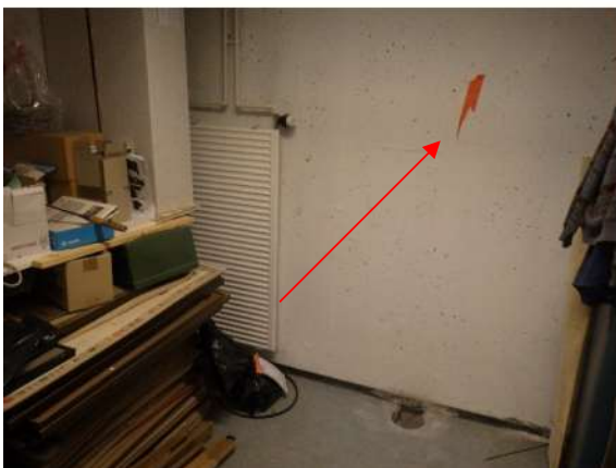
Kuva 59. Kuva tilasta 053, jossa maanvastainen seinän kantava rakenne on paikallavalettua ja maalattua betonia. Seinän alaosassa rakenneavaus/kuivaporaus RA-MVS6.
