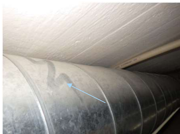
Kuva 234. Yläpohjan alla on käytävillä alakattorakenteet. Alakattotiloissa rakennusmateriaalipölyä.
