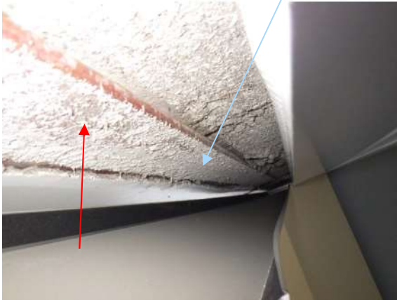
Kuva 123. Vanhaan ulkoseinään tehtyä aukkoa on tuettu ulkoseinässä teräsrakenteella.
