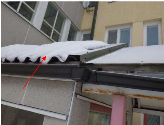
Kuva 254. Vuoden 1994 osan 1. krs tuuli-kaapin vesikatteena varttikate.
