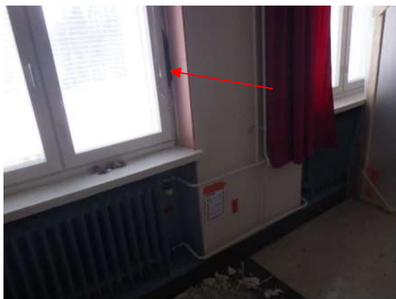
Kuva 87. Rakenneavauskohta RA-US5. Ikkunat on uusittu ja ne on asemoitu patterisivennyksen lämmöneristekerroksen kohdalle.
