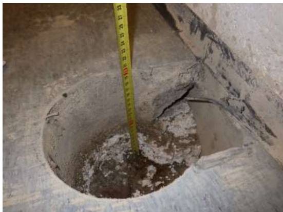
Kuva 42. Rakenneavaus RA-AP10 tilassa 053 maanvastaisen seinän liitoksessa.
