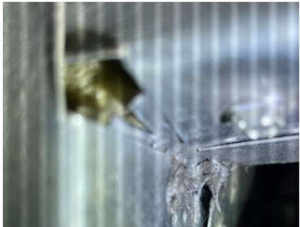
Kuva 277. Endoskooppikameran ottamaa kuvaa koneen sisältä. Kammioissa on reikäpellityksen takana mineraalivillaa. Kulmaliitoksista mineraalivilla on näkyvissä.
