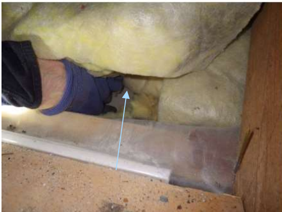
Kuva 239. Rakenneavauskohta RA-YP4. Rakenne on mineraalivillaeristetty puurankarakenne, jonka sisäpinnassa on höyrynsulku ja kipsilevytys.
