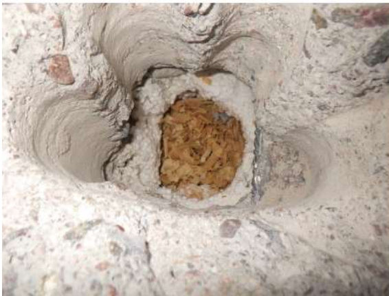
Kuva 196. Rakenneavaus RA-VP13. Massiivibetonilaatan, tervapaperin ja EPS-eristeen alla alkuperäistä kutterinlastua.
