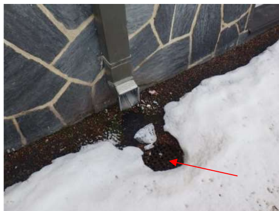
Kuva 8. Sadevesikaivot ovat muovikaivoja ja syvyydeltään noin 0,5 m.
