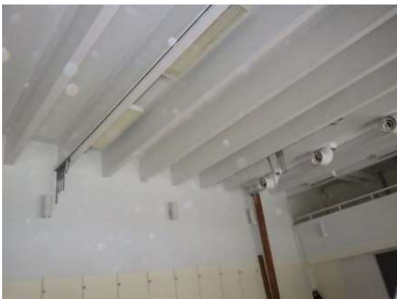
Kuva 225. Ylälaattapalkistojen alapuolella ei pääosin ole alakattorakenteita. Kuva tilasta 310.
