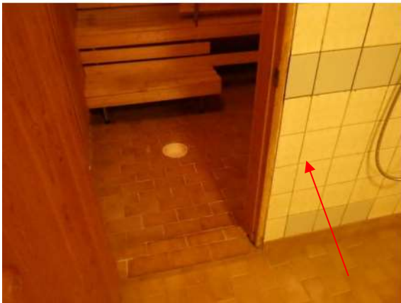
Kuva 214. Alkuperäinen kevyt väliseinärakenne.
