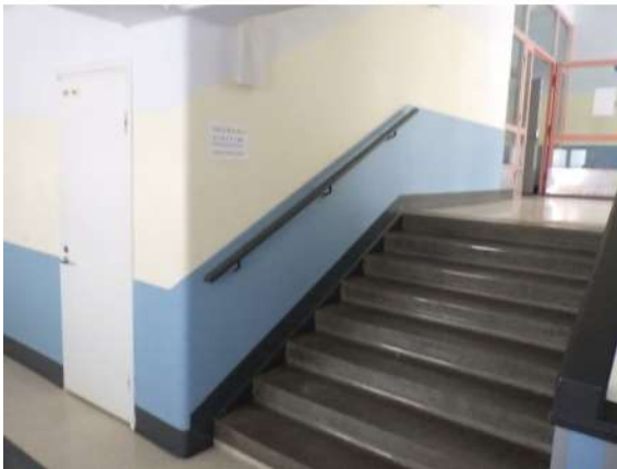
Kuva 210. Kouluosan portaikko, jossa ainoastaan porraskelmat ovat mosaiikki-betonisia massiivibetonirakenteita.
