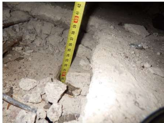
Kuva 232. Rakenneavauskohta RA-YP2. Täyttökerroksessa kutterinlastua, hiekkaa ym. ja täytön paksuus noin 300 mm.
