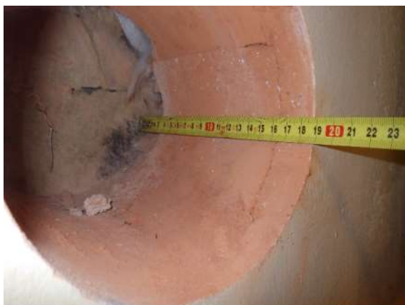
Kuva 53. Rakenneavaus RA-MVS3. Kellarikerroksen asunto-osan maanvastainen seinärakenne MVS2 on paikalla valettu teräsbetoniseinä, jonka sisäpinnassa on bitumisively, lasivilla ja verhomuuraus.
