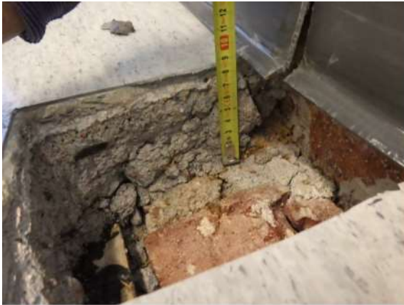
Kuva 151. Välipohjan ja väliseinän liitoksen rakenneavaus RA-VS1.
