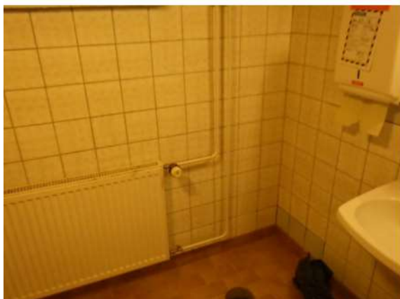
Kuva 55. Tilassa 021 verhomuurauksen sisäpintaan toteutettu keraaminen laatoitus tasoitekerroksen päälle.
