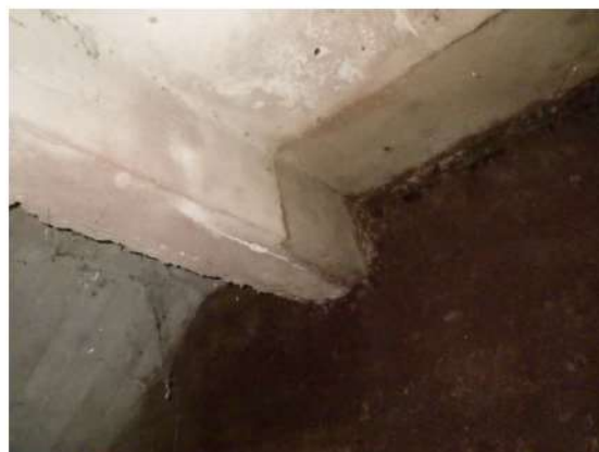
Kuva 47. Rakenneavaus RA-POR1. Portaikon rakenteet teräsbetonirakenteita.
