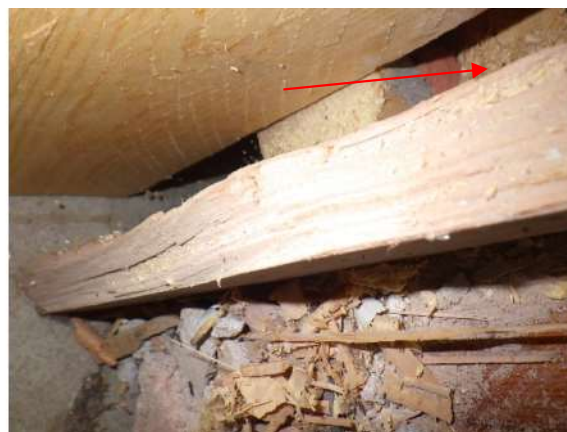
Kuva 173. Rakenneseuraus RA-VP8. Alkuperäisen ponttilautalattian alla on kutterinlastu- ja hiekkatäyttökerros.
