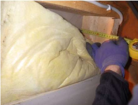
Kuva 127. Ulkoseinärakenteessa US7 on puurunko ja 150 mm mineraalivillaeristys. Kuva rakenneavauksesta RA-US15.
