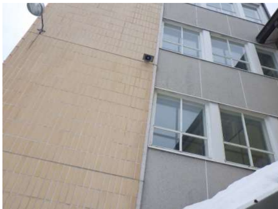
Kuva 105. Laajennusosan tiililaattapintainen sandwich-elementti.
