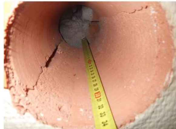
Kuva 79. Rakenneavaus RA-US8. Punatiilen ja kevytbetonin välissä noin 30-50 mm ilmarako.
