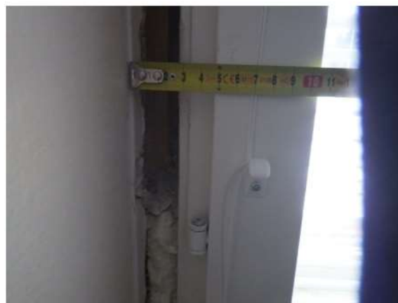
Kuva 104. Rakenneavauskohta RA-US12. Ikkunoiden asennusväli noin 30 mm.
