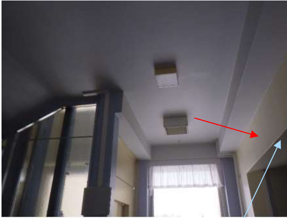
Kuva 121. Vanha ulkoseinärakenne US1 vuoden 1994 laajennuksen ja kouluosan välillä (punainen nuoli).
