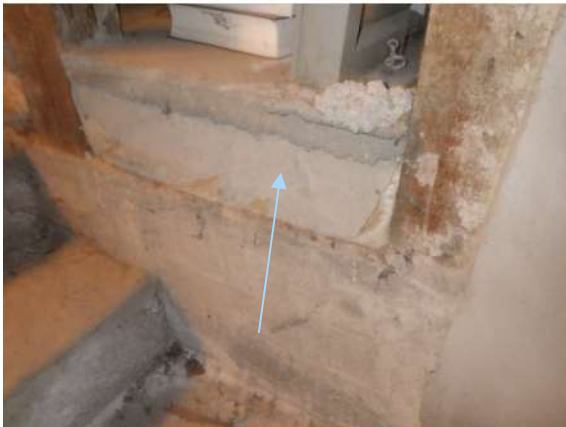
Kuva 223. Yläpohjan eri tasoja, joista havaittavissa myös rakennekerrokset.
