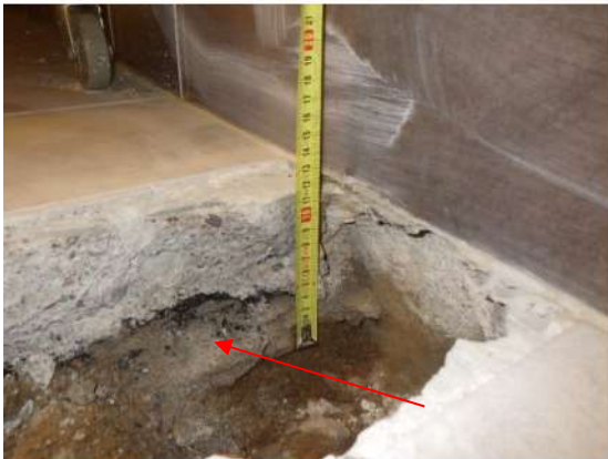
Kuva 23. Rakenneavaus RA-AP4 käytävällä 001, jossa lattianpinnoitteena on ke-raaminen laatta. Pohjalaatta on haurasta hiekkansekaista betonia.
