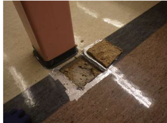
Kuva 33. Kuva tilasta 006, jossa on tehty arviolta vuonna 1994 teräspilarivahvistuksia keskelle tilaa. Teräspilarien kohdalle alapohjaan on valettu uudet betoni-anturat, joiden päällä on suoraan lastulevy ja muovimatto.
