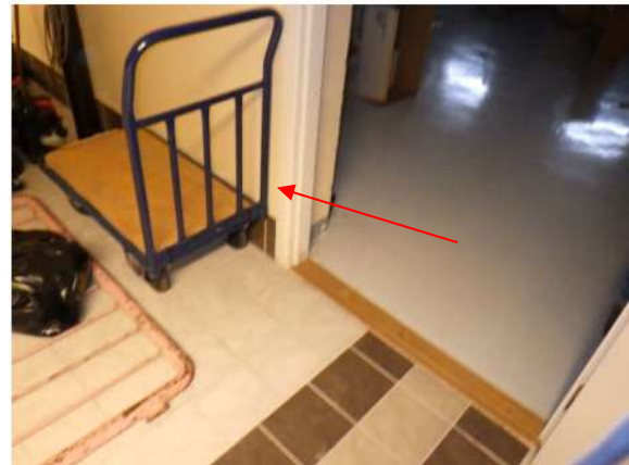
Kuva 215. Alkuperäinen kantava väliseinä tilojen 010 ja 001 välissä.
