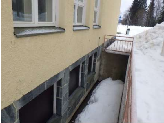
Kuva 9. Rakennuksen päädyssä oleva portaikkosyvennys, johon kerääntyy runsaasti lunta.
