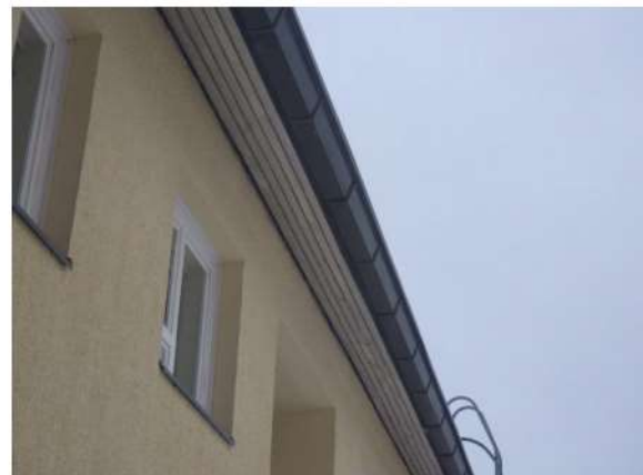
Kuva 257. Rästäiden aluslaudoitus on arviolta uusittu vuonna 1994. Rästään kautta on toteutettu ullakon tuuletus.
