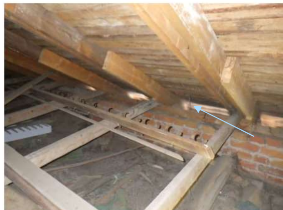
Kuva 226. Ullakko tuulettuu räystäiden kautta, jossa on tuuletusraot.
