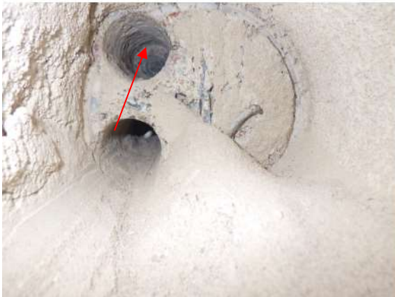
Kuva 86. Rakenneavauskohta RA-US4. Välipohjan kohdalla ulkoseinässä on lastuvillaeristekerros betonipalkkien välissä.
