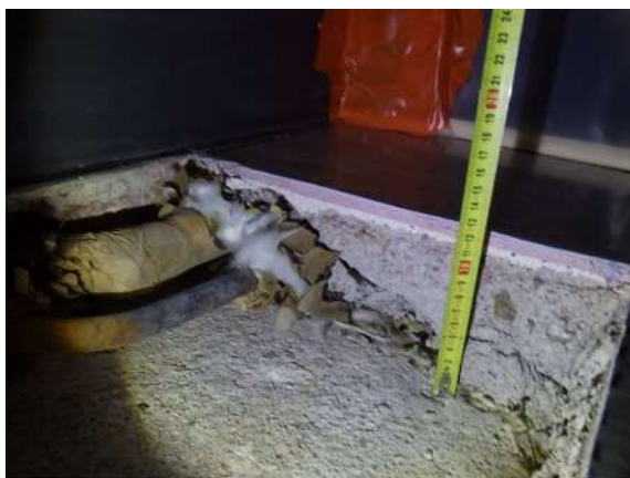
Kuva 184. Rakenneavaus RA-VP3. Pinta-laattakerroksessa lämpöputkia ja putkieristeitä.
