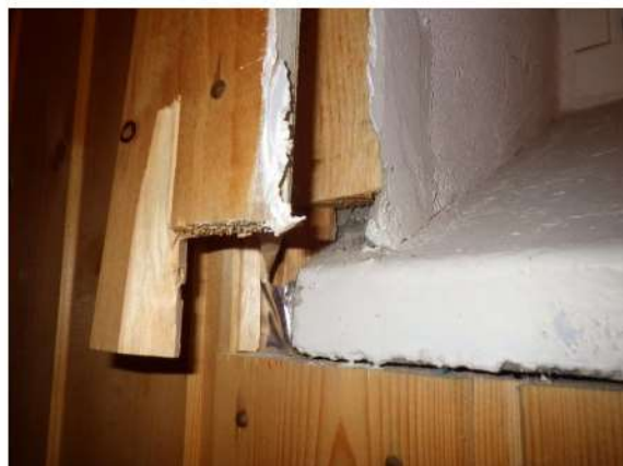
Kuva 56. Tilassa 022 verhomuurauksen sisäpintaan toteutettu koolaus 22x100, alumiinipaperi ja panelointi.
