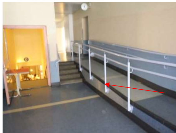
Kuva 156. Vuonna 1994 toteutettuja puu-/levyrakenteisia luisia betonikantisen välipohjan päälle.
