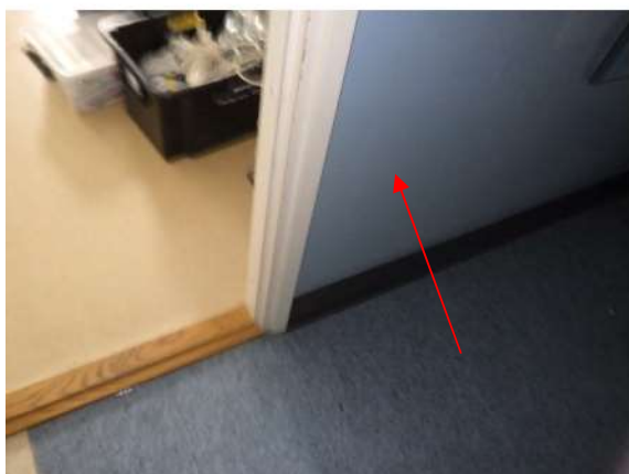
Kuva 218. Alkuperäisellä asunto-osalla välipohjan päälle vuonna 1994 toteutetuja rankarakenteisia väliseiniä.
