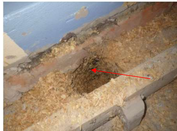
Kuva 171. Rakenneavaus RA-VP9. Ulkoseinässä on välipohjan sidepalkki, jonka sisäpinnassa on bitumisively.
