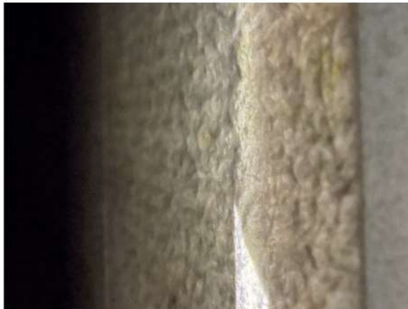
Kuva 276. Äänenvaimentimet ovat pinnoittamatonta mineraalivillaa. Levyn pinta on paksun pölykertymän peittämä.
