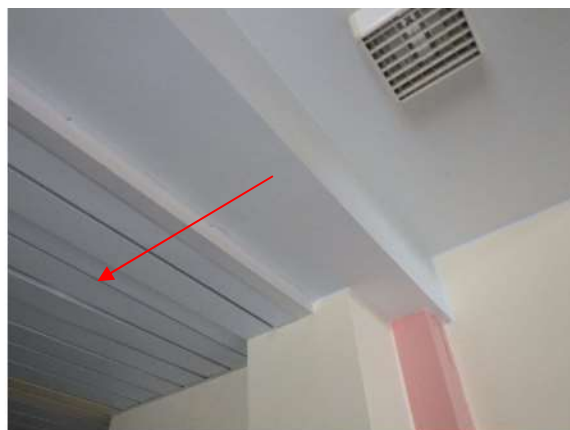
Kuva 146. Kuva kouluosan ja vuoden 1994 laajennusosan liitoksesta. Käytävillä on alakattorakenteet.
