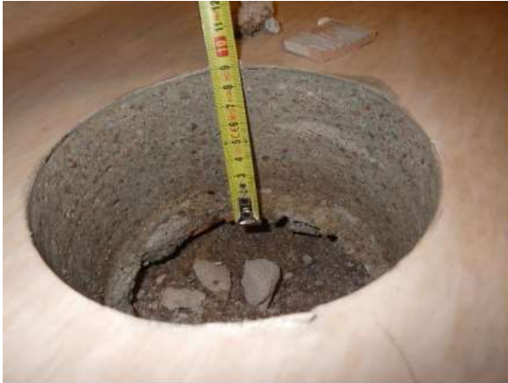
Kuva 190. Rakenneavaus RA-VP17 kouluosalla tilassa 107. Lattiapinnoite on uusittu muovimatoksi.
