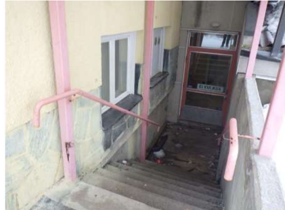
Kuva 10. Rakennuksen keskellä laajenusosaan johtava portaikko on katettu.
