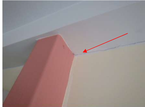
Kuva 178. Laattapalkisto on valettu vanhaa ulkoseinää vasten.
