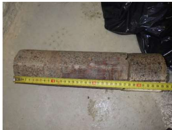
Kuva 62. Rakenneavaus RA-MVS4. Havainnon perusteella betonirakenne on säästökivibetonia.
