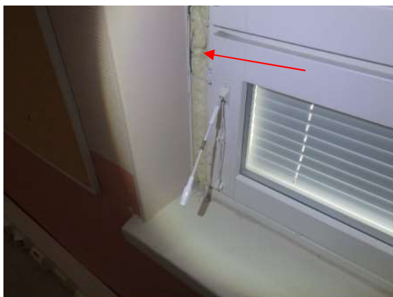
Kuva 101. Rakenneavauskohta RA-US12. Ikkunat on uusittu.
