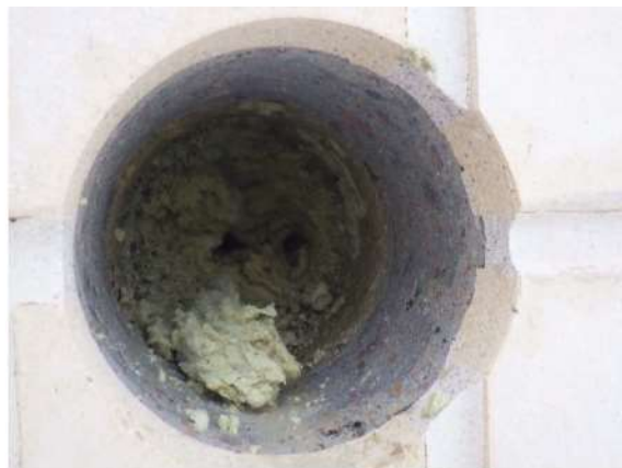
Kuva 108. Rakenneseinän RA-US13. Mineraalivilla lämmöneristeenä.
