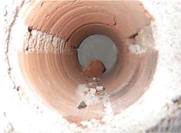
Kuva 77. Rakenneavaus RA-US2. Kantavan massiivitiiliseinän paksuus on 270-280 mm.
