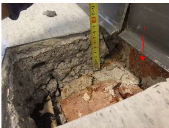
Kuva 216. Rakennusaukko RA-VS1. Ei-kantava punatiilestä muurattu väliseinä (punainen nuoli). Välipohjan pintalaatta on valettu ei-kantavaa väliseiniä vasten.
