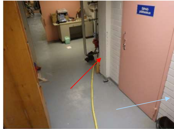
Kuva 213. Kellarissa alkuperäinen teräs-betoninen kantava pilari (punainen nuoli) sekä vuonna 1994 muurattu kevyt väliseinä tilassa 029.
