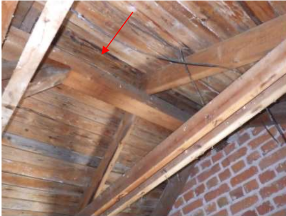
Kuva 229. Asunto-osalla kylmä ullakotila.
