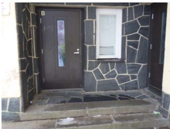
Kuva 133. Alkuperäisen rakennuksen ulko-ovista osa on uusittu ikkunoiden uusimisen yhteydessä.
