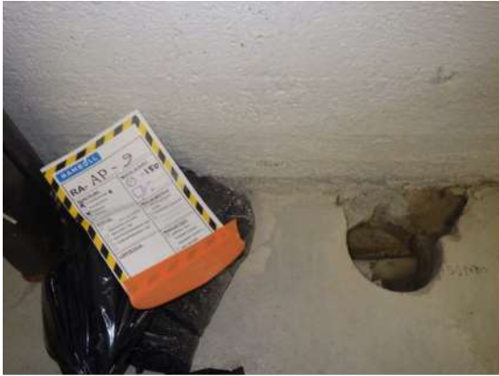
Kuva 38. Rakenneavaus RA-AP9 tilassa 014.
