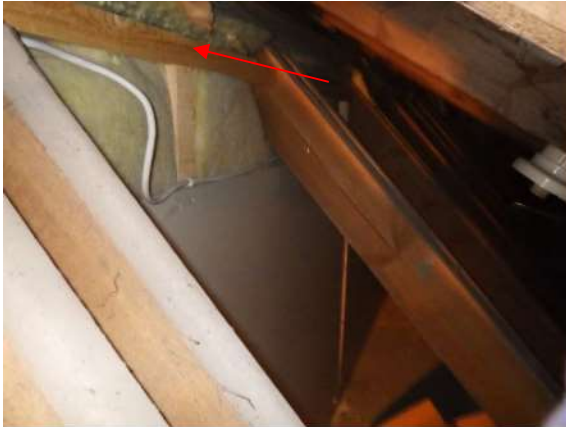
Kuva 237. Ullakkostudiotilojen ulkoseinän ja yläpohjan liitoskohta kylmän ullakkotilan puolelta.
