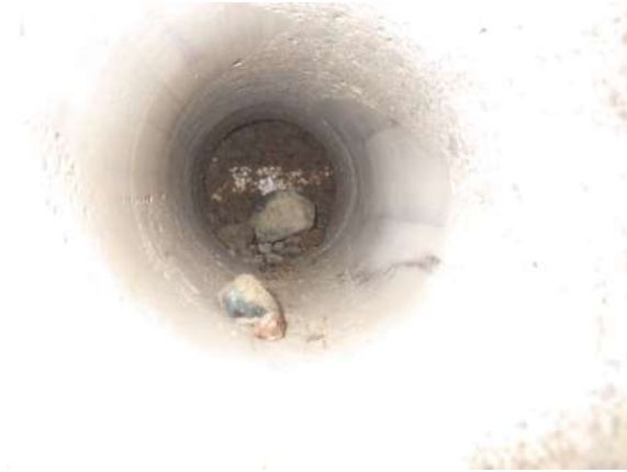
Kuva 63. Säästökivibetonin ulkopintaan on lisätty 50 mm EPS-eristys. Rakennearaus RA-MVS4. Havainnon perusteella EPS-eristettä on vain seinän alaosassa.
