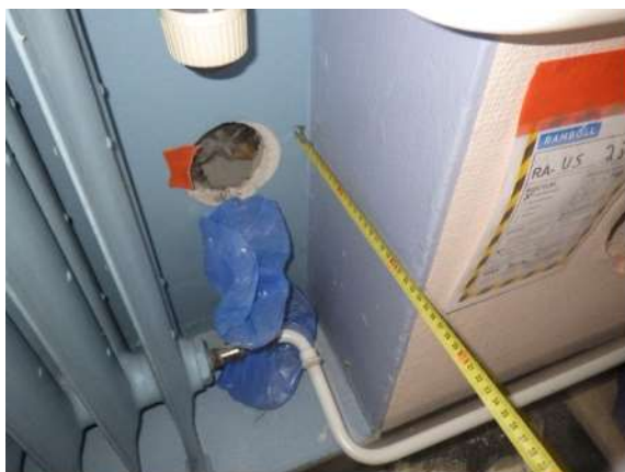
Kuva 80. Rakenneavauskohta RA-US3. Patterisyvennyksen syvyys noin 230 mm
