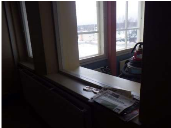
Kuva 11. Vanha ulkoseinärakenne vuoden 1994 laajennuksen ja asunto-osan välillä.
