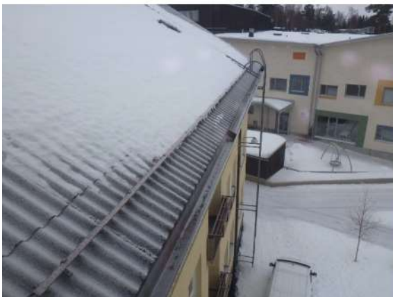
Kuva 256. Rästäillä on lumiesteet.
