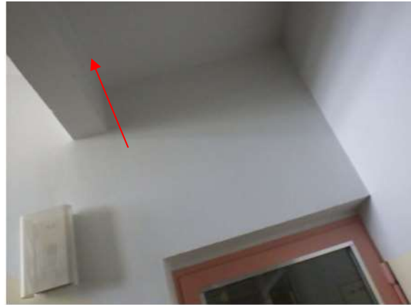
Kuva 209. Porrastanteet ovat asuntoosalla laattapalkkistoja.
