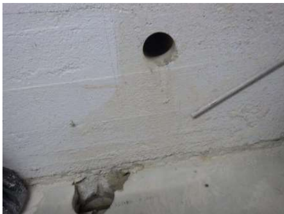
Kuva 61. Rakenneavaus RA-MVS4. Maanvastaisen seinän sisäpinta on maalattu.
