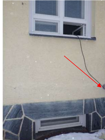
Kuva 99. Rakenneavaus RA-US11 ulkopuolelta välipohjan kohdalle.
