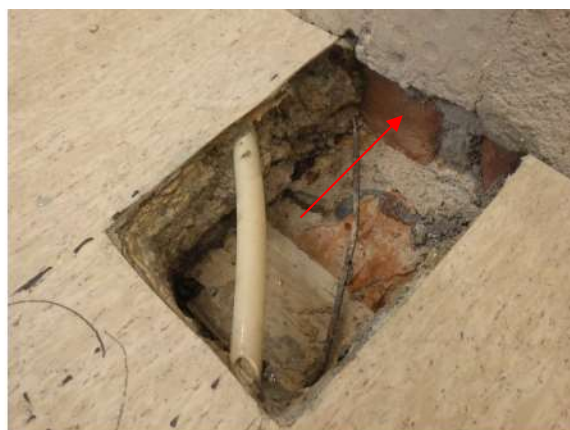
Kuva 217. Rakennusaukko RA-VP10. Kantava punatiilestä muurattu väliseinä (punainen nuoli). Välipohjan pintalaatta on valettu kantavaa väliseiniä vasten.
