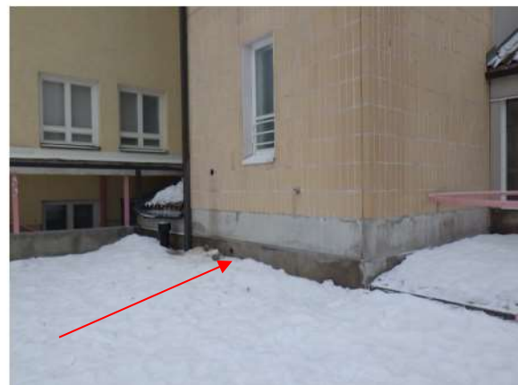
Kuva 60. Vuoden 1994 laajennuksen maanvastaisen seinän yläosa.
