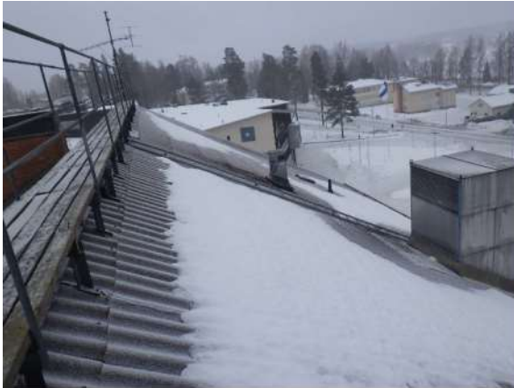
Kuva 252. Alkuperäisen rakennuksen osan kuitusementtiaaltokate. Harjalla on puiset kulkusillat.
