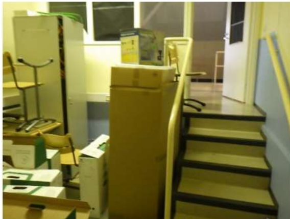
Kuva 198. Kuva tilasta 509 tilaan 508, jossa alkuperäisen yläpohjan päälle koolatulla puurakenteella on toteutettu porras- ja luiskarakenteet.
