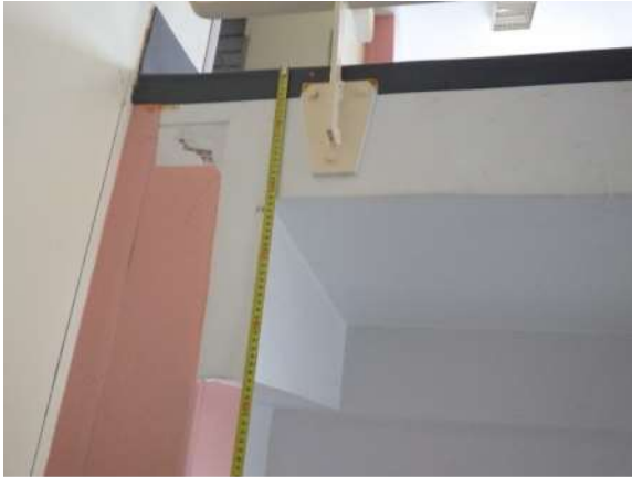
Kuva 177. Vuoden 1994 välipohjarakenne aulaan. Rakenteen yläosa on teräspilari, johon on kiinnitetty laattapalkisto. Laattapalkiston palkin kohdalla rakennevahvuus noin 470 mm ja laatan kohdalla noin 210 mm.
