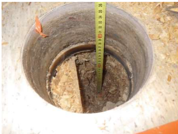
Kuva 155. Rakenneavaus RA-VP16. Täyttökerroksen paksuus noin 250 mm.
