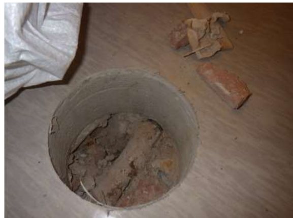
Kuva 189. Rakenneavaus RA-VP12. Lattiapinnoite on uusittu muovimatoksi. Täyttökerroksena rakennusjätettä, jossa puuta, hiekkaa, laastia, tiilenpalasia jne.
