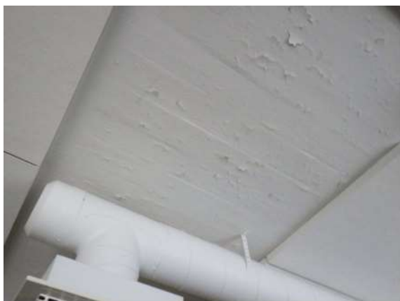
Kuva 145. Osittain sisäkattopinnat (pääosin luokkatilat) ovat tasoitettuja ja maalattuja alalaattapalkistoja, joiden alapinnoissa on akustiikkalevyjä, valaisimia ja IV-putkia.
