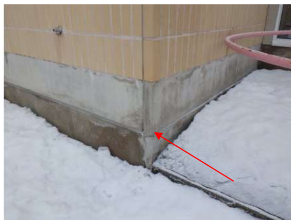
Kuva 110. Alimman elementin alaosa on betonipintainen ja alin elementti on asennettu maanvastaisen seinän / sokkelin päälle.
