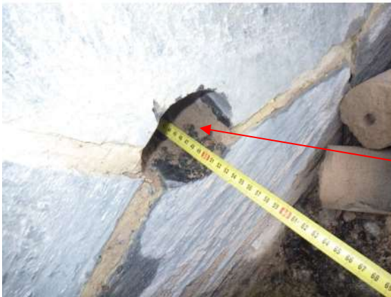
Kuva 51. Rakenneavaus RA-US/sokkeli2 ulkopuolelta.
