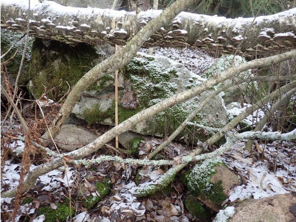
Kuva 5. Sahan luonnonkivistä ladottua perustusta.
