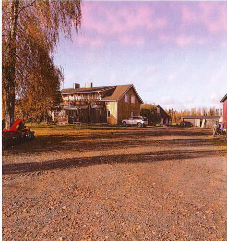
Mäntymäki- tilan asuinrakennus
