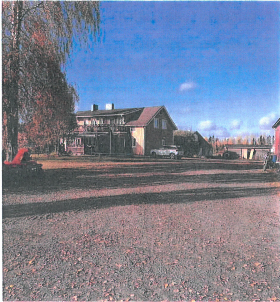
Mäntymäki- tilan asuinrakennus
