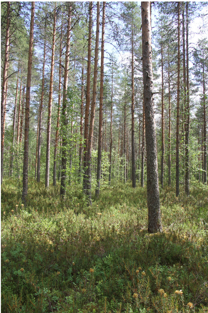
Yleiskuva uuden sähkösiirtolinjan keskivaiheilta Ylimysnevan alueelta
