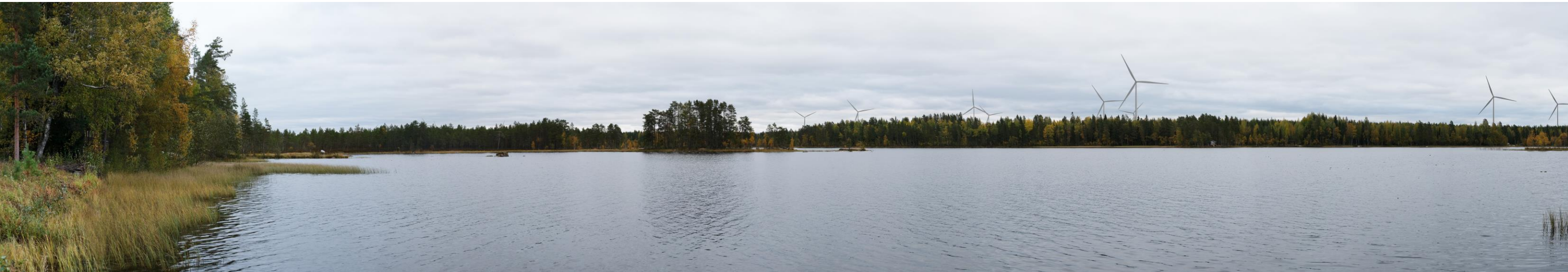
Kuva 16. Valokuvasekoitus kuvauspisteestä 8 on otettu Iso Someronjärven rannalta Hirvinevan alueelta. Etäisyys voimaloihin on noin 2 kilometriä. VE 1
