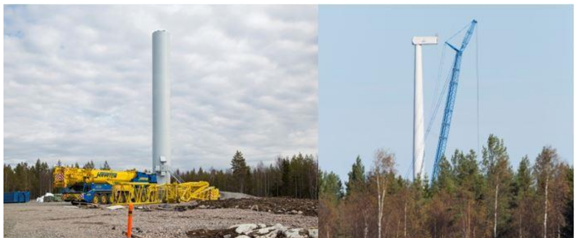
Kuva 9.12. Tuulivoimalan kokoamista (Ville Suorsa, FCG).
