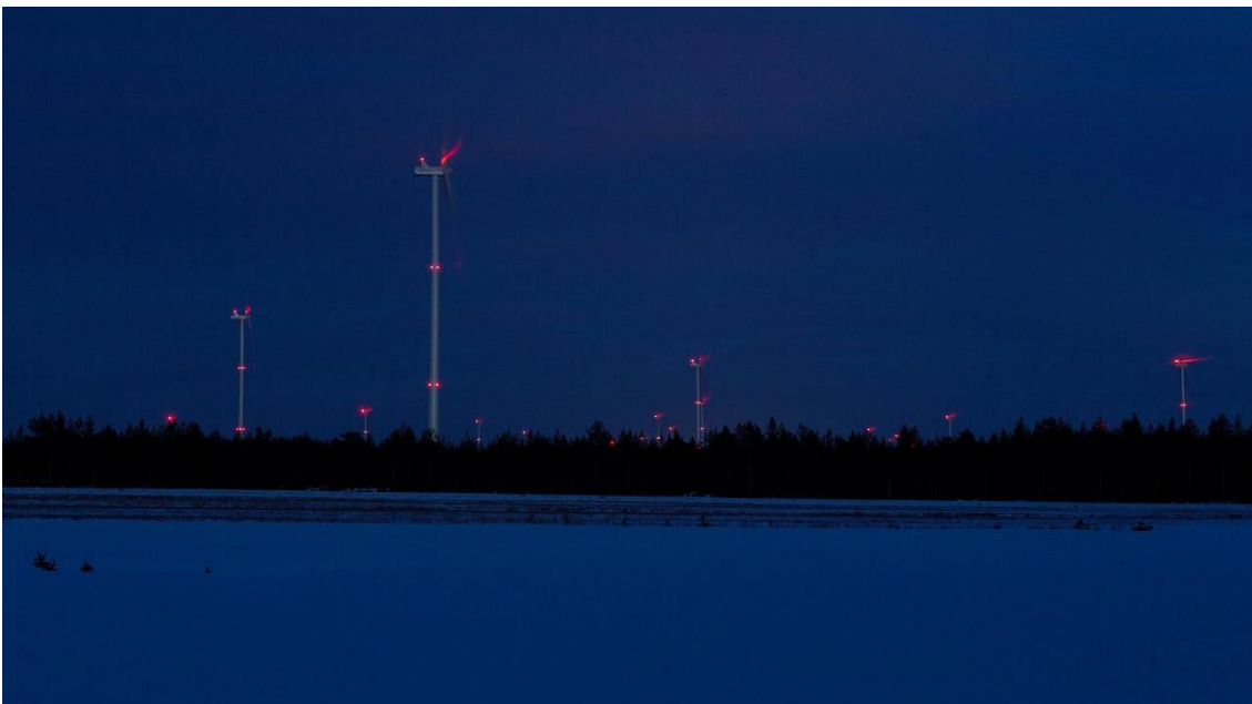
Kuva 9.4. Kiinteät punaiset lentoestevalot (Ville Suorsa, FCG).
