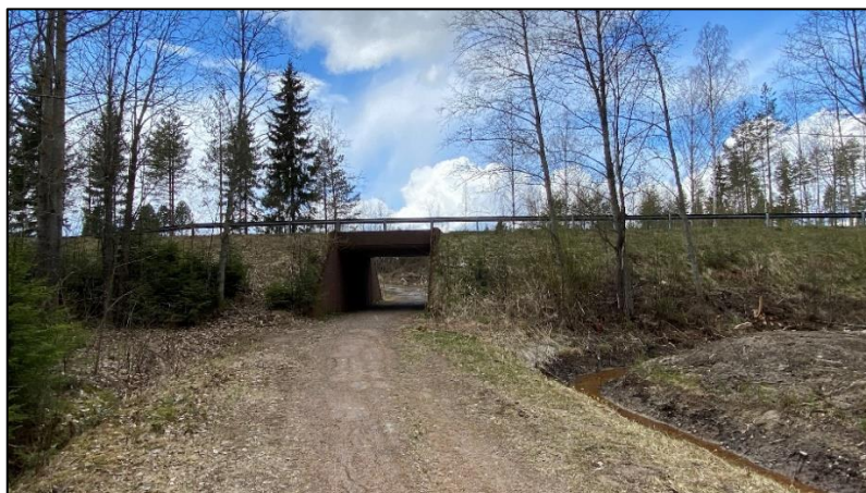
Alikulku Repolanraitilla suunnittelualueen länsiosassa. Yläpuolella kulkee Vatusentie (mt 13322).
